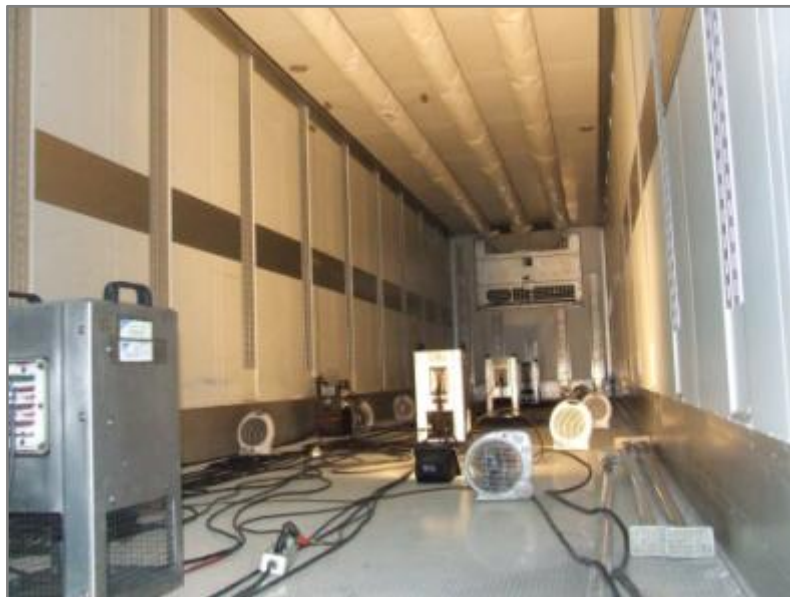
Figura 3 - Montagem do permutadores e dos termoventiladores no interior do veículo
