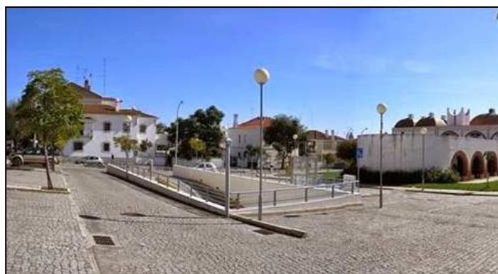
Figura 5. 39 – Parque de estacionamento subterrâneo da Casa da Cultura
