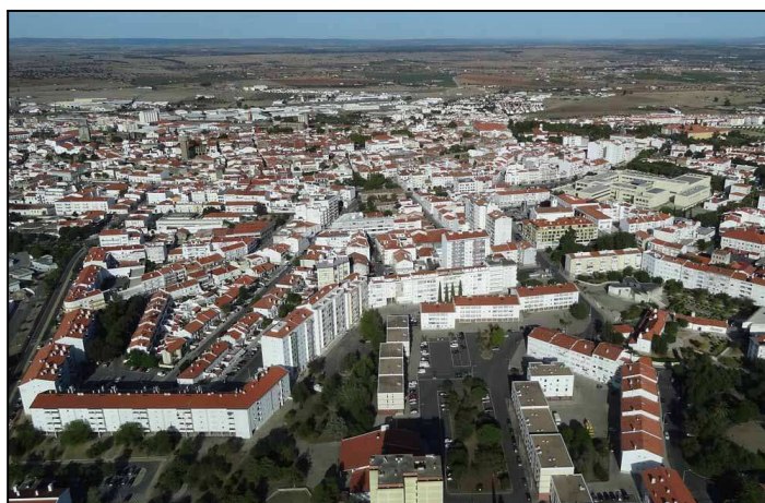
Figura 5. 11 – Bairro Residencial da Força Aérea
