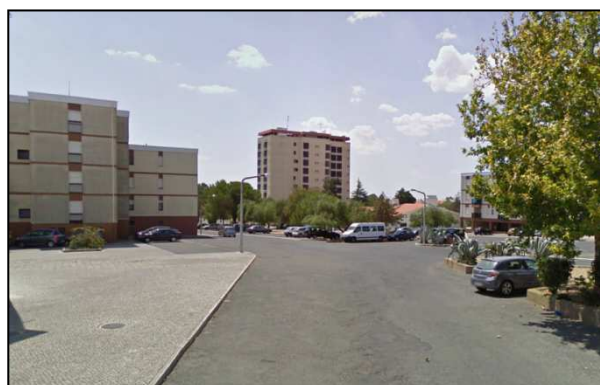
Figura 6. 26 – Bairro Residencial da Força Aérea Portuguesa
