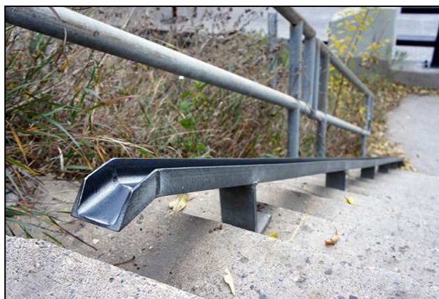
Figura 3. 7 – Calha ao longo de escada para transporte de bicicletas
