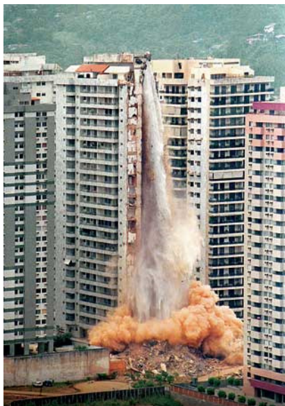
Figura 2.2 - Desabamento do Edifício Palace II, no Bairro da Tijuca, no Brasil [s8].
