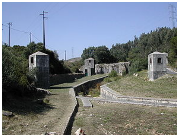
Figura 2.4 - Vestígios da Barragem Romana de Belas – Construída no Século III [Appleton, J., 2005].
