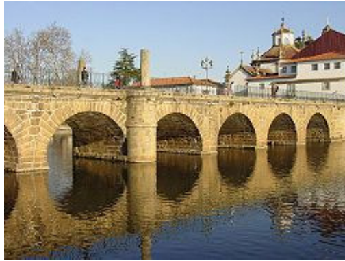
Figura 2.3 - Ponte Romana de Chaves – Construída entre fins do Século I e o início do Século II [Appleton, J., 2005].
