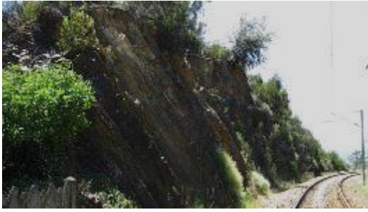
“Linha do Norte, Inspeção de Talude/Observação de zona a intervir”
