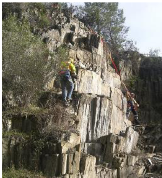
“Linha da Beira Baixa, Troço Abrantes – Guarda – Estabilização de Taludes e Drenagem”
