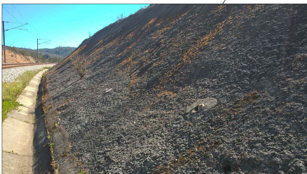
FOTO 6 - SOLUÇÃO DE ESTABILIZAÇÃO DO TALUDE DE ESCAVAÇÃO
