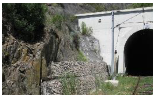
“Linha da Beira Baixa, Troço Abrantes – Guarda – Estabilização de Taludes”
