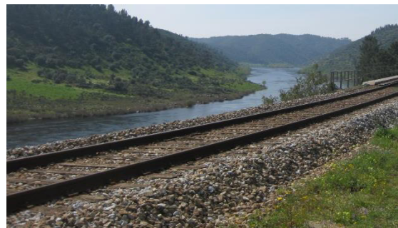
Figura 4-3 – Talude de aterro
