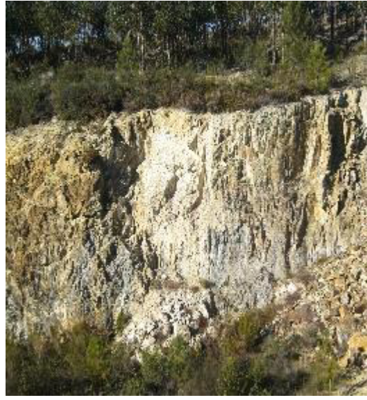
“Linha do Norte, Inspeção de Talude/Observação de zona a intervir”
