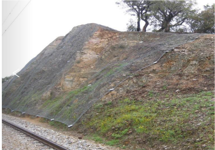
Figura 4-23 – Pregagens em talude, Borges (2014)
