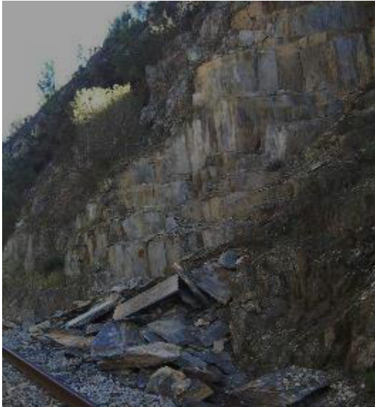
“Linha da Beira Baixa, Inspeção de Talude/Observação de zona a intervir”
