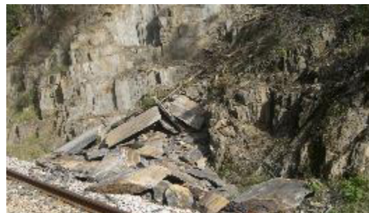
“Linha da Beira Baixa, Inspeção de Talude/Observação de zona a intervir”
