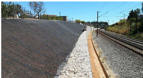
Figura 4-2 – Talude de escavação
