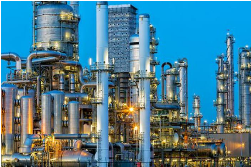
Figura 3.1 - Instalação industrial no setor petroquímico.
