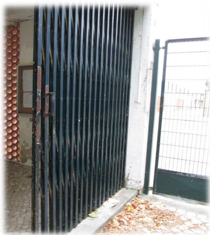
Figura 18 – Portão metálico da Escola Básica Teixeira Pascoais
