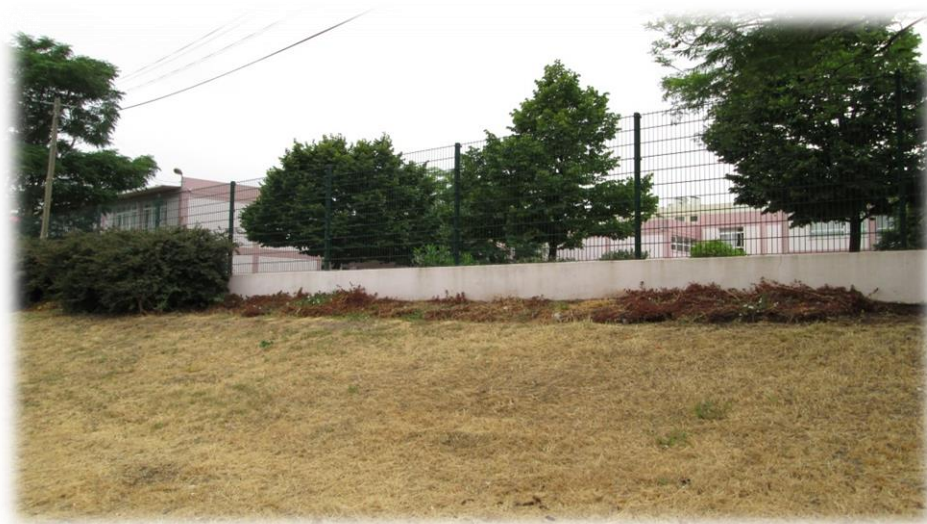
Figura 17 - Muro de Vedação e Vedação metálica da escola nº57 em Telheiras
