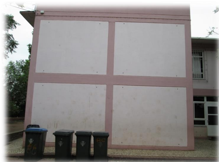
Figura 40 - Vista dos elementos da estrutura (pré-fabricada) e das paredes exteriores
