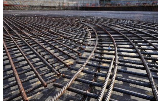
Figura 8.26 - Disposição de armaduras em sapatas circulares (Cruz F. d., 2009)
