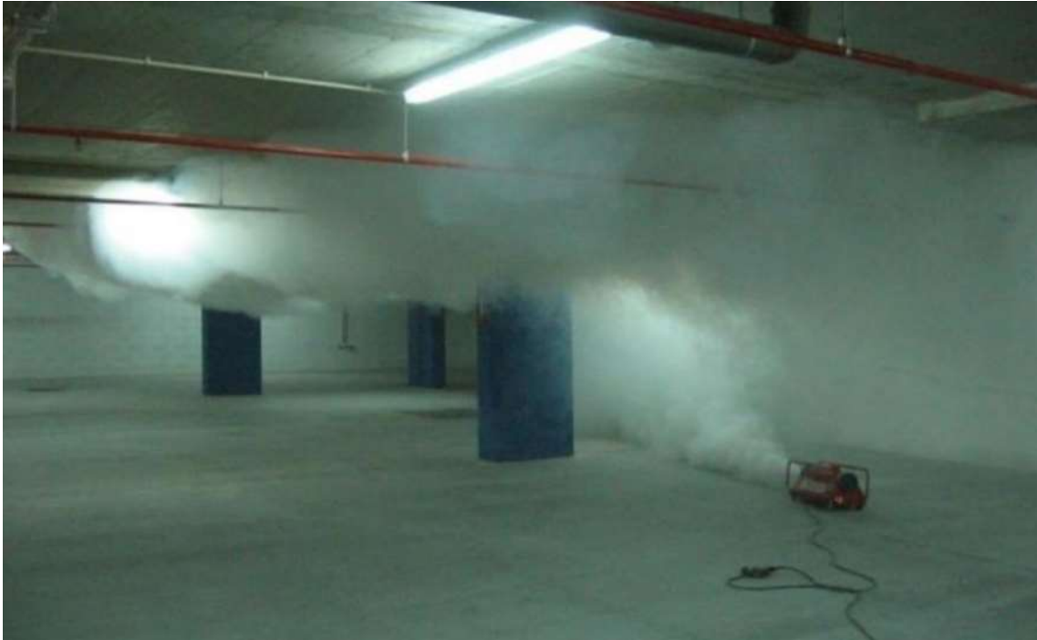
Figura 5.3 – Ensaio de fumos num parque de estacionamento
