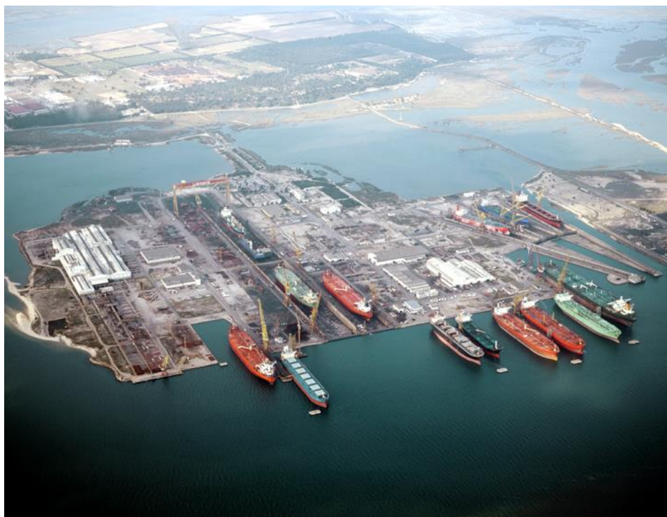
Figura 8 - Lisnave, vista sul-norte (Fonte: Lisnave, S.A.)
