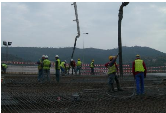
Betonagem do tabuleiro.
