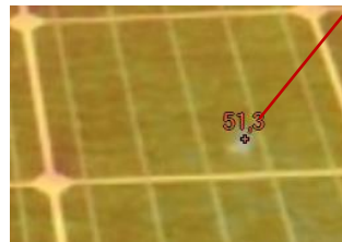
Figura 51: Imagem termográfica de um módulo do sistema com visualização de um ponto quente
