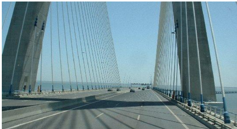
Figura 3.9 – Barreira de Betão New Jersey em separador central, na Ponte Vasco da Gama
