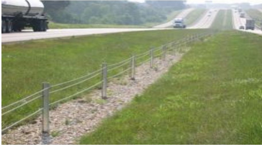
Figura 3.7 – Utilização de barreiras de cabos de aço em separador central
