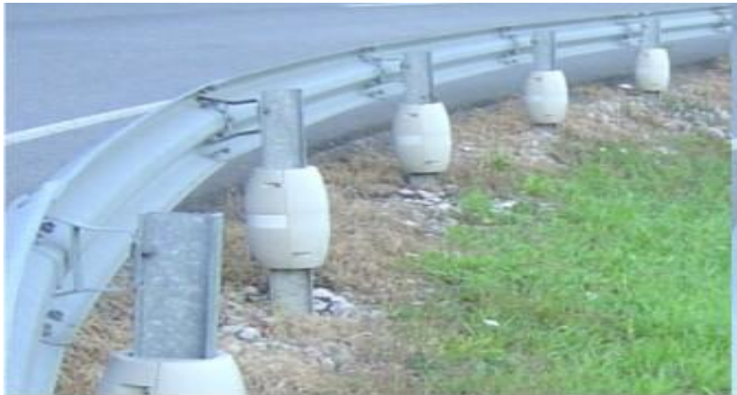
Figura 3.15 - Proteção dos prumos de barreiras metálicas simples com Poliestireno Expandido
