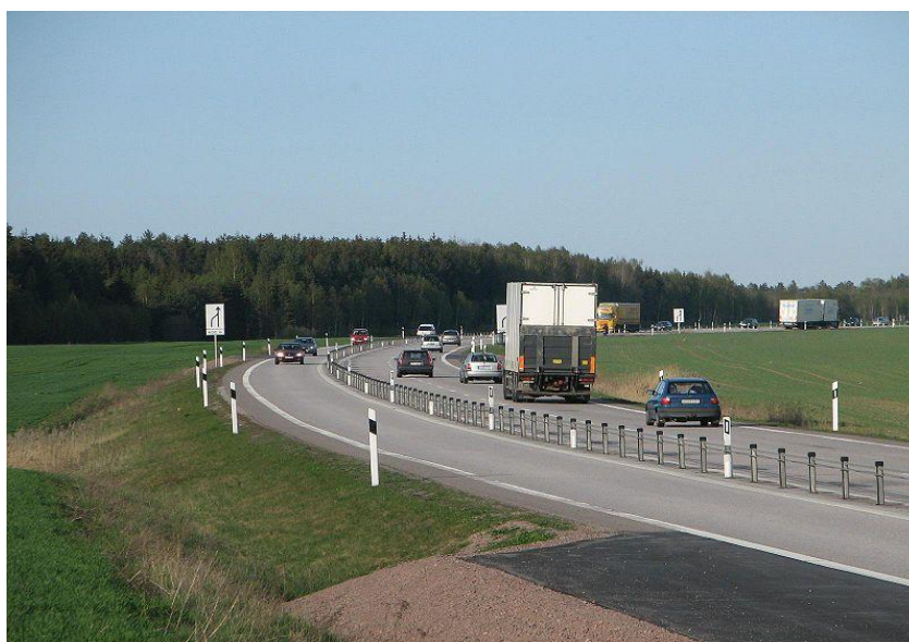
Figura 3.8 - Barreira de Cabos em separador central numa estrada da Suécia
