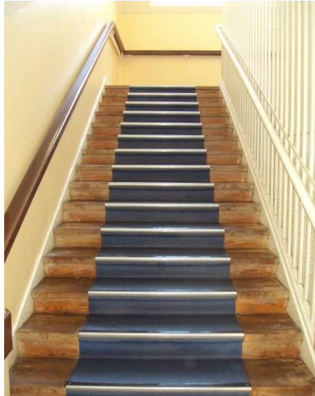
Figura 35: Escadas de acesso ao piso 1 (Fonte: Autor, 2016)
