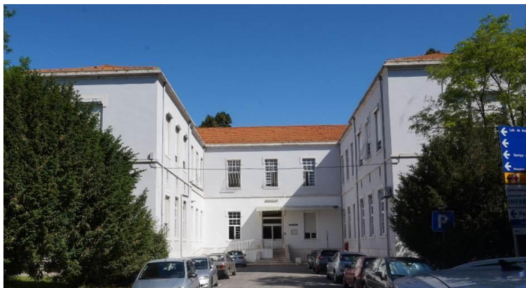
Figura 33: Entrada principal do Pavilhão 24A (Fonte: Autor, 2016)
