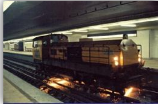
Fig. 72 Unidade esmeriladora Speno em operação, propriedade do Metropolitano de Lisboa, foto do autor.
