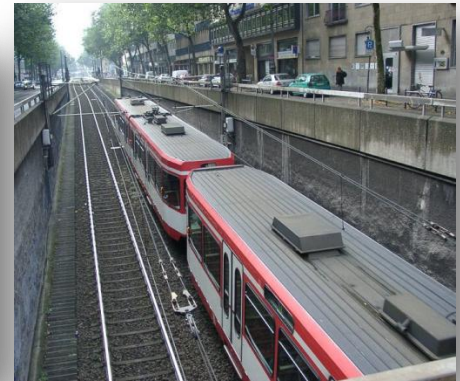
Fig. 31 Rampa de saída do túnel dos eléctricos de Colónia, Rhein Ruhr Stadbahn Album 1.
