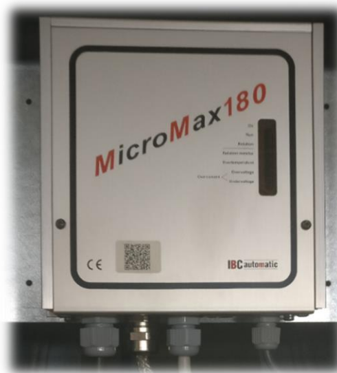
Figura 4.6 – Variador de frequência MicroMax-180 [24]
