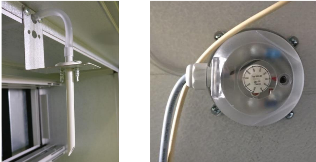
Figura 4.13 – Toma de Pressão (esquerda); Pressóstato (direita)
