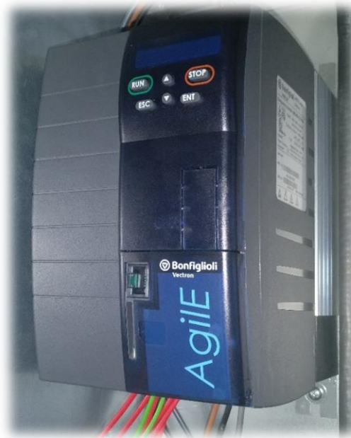
Figura 4.8 – Variador de frequência do compressor
