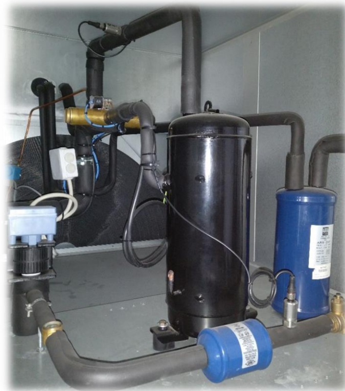
Figura 4.11 – Circuito do compressor
