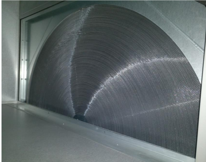
Figura 4.5 – Recuperador de Calor rotativo da Enventus modelo ST1-N-W-1150-CS-V
