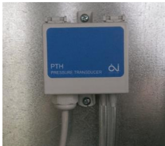
Figura 4.14 – Transdutor de pressão
