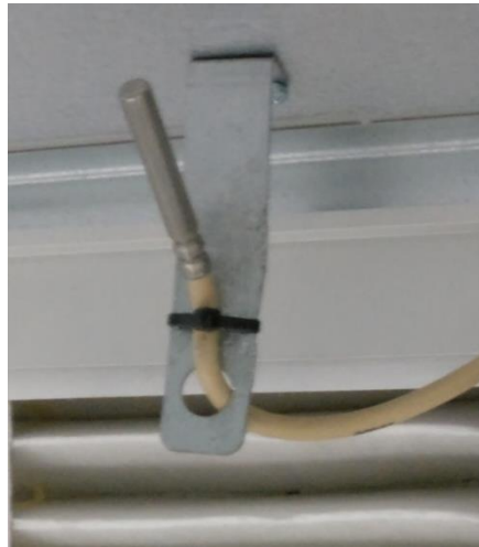
Figura 4.12 – Sensor de Temperatura
