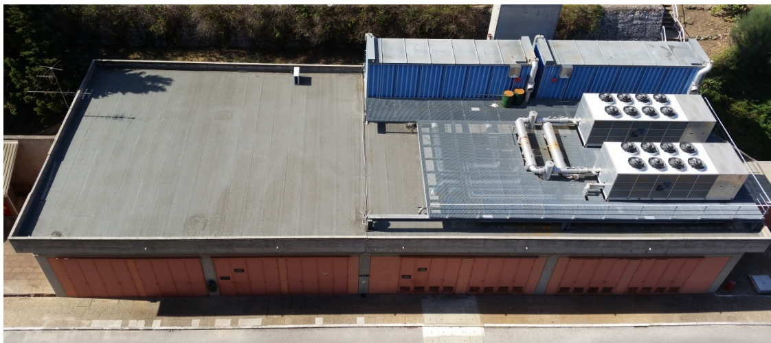
Figura 50 – Cobertura do edifício E.
