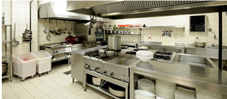
Figura 9 – Vista da cozinha.
