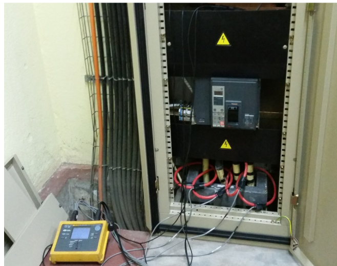
Figura 17 – Analisador de redes registando os dados, ligado na parte baixa do QGBT do PT n° 2.
