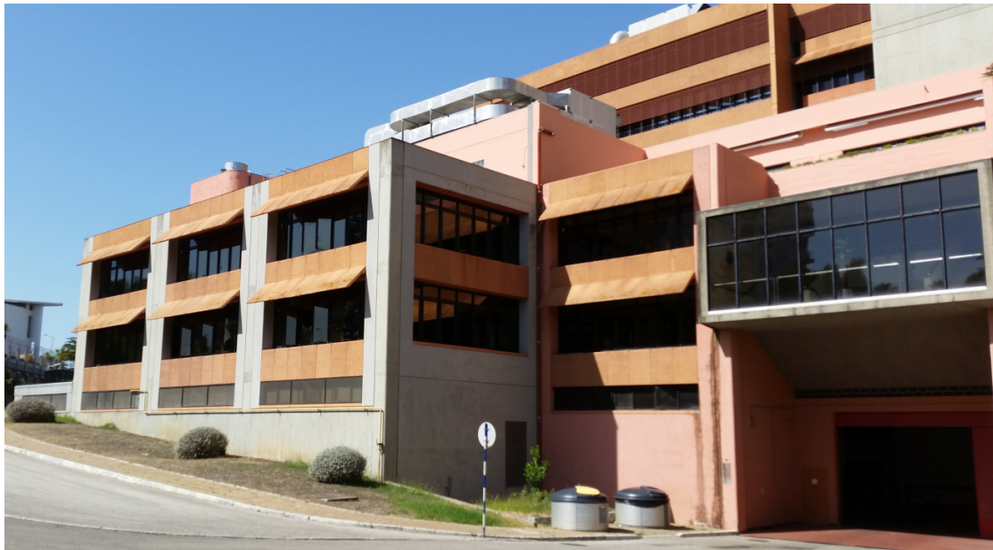
Figura 10 – Vista exterior do edifício D.
