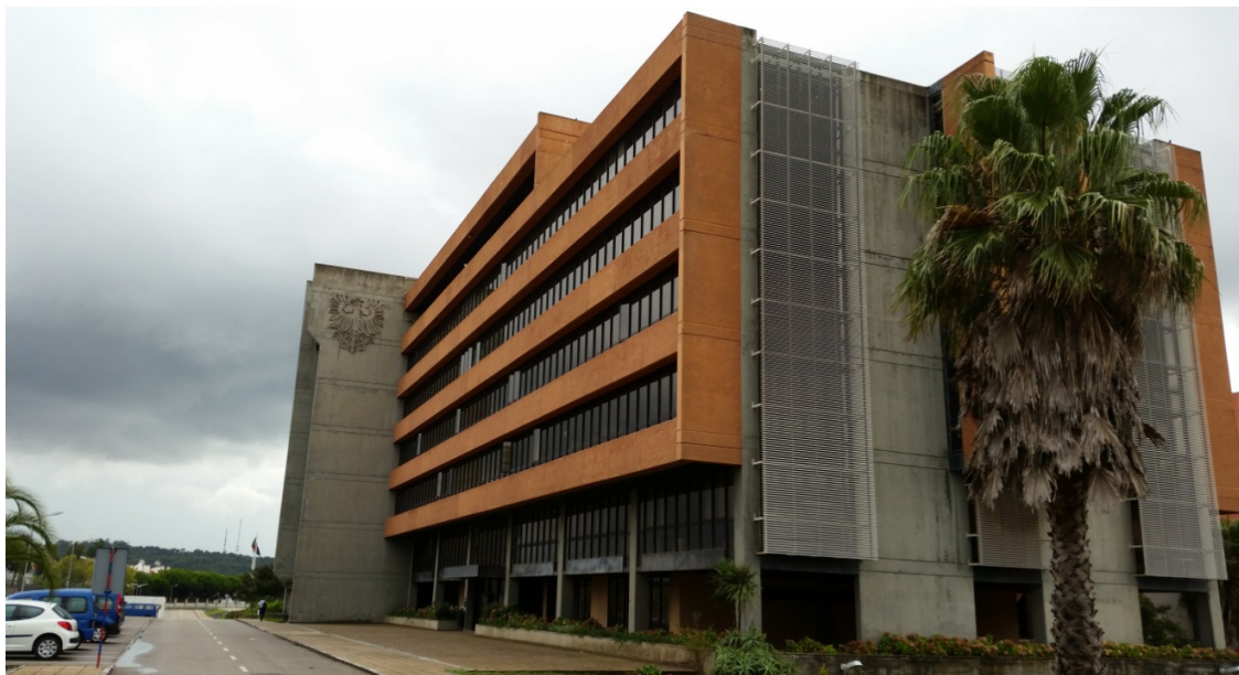
Figura 8 – Vista exterior do edifício A com o pormenor das proteções solares.
