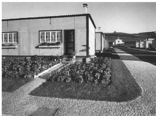
Figura 7 | Casas económicas e rua principal, 1940. Fonte: Arquivo Municipal de Lisboa: [s.d.].
