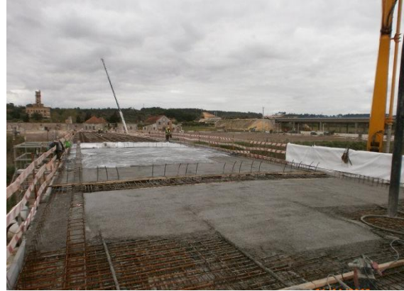
Imagem 23 - Betonagem de um troço do tramo P5
