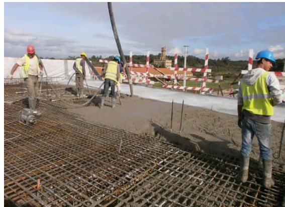
Imagem 4 - Betonagem do 10º tramo do viaduto esquerdo
