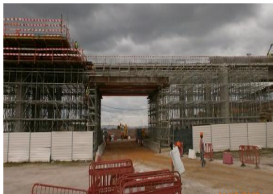
Imagem 28 – Cimbre contínuo com pórtico vigado
