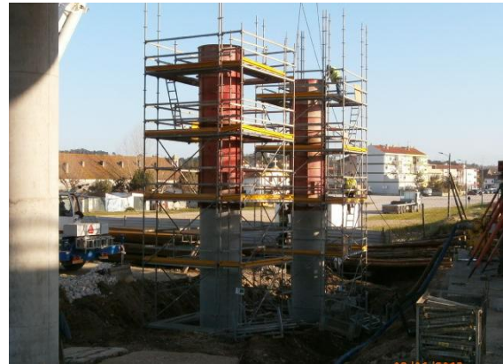
Imagem 2 - Betonagem do lintel de fundação (à esquerda) e cofragem do 3º troço dos pilares (à direita)
