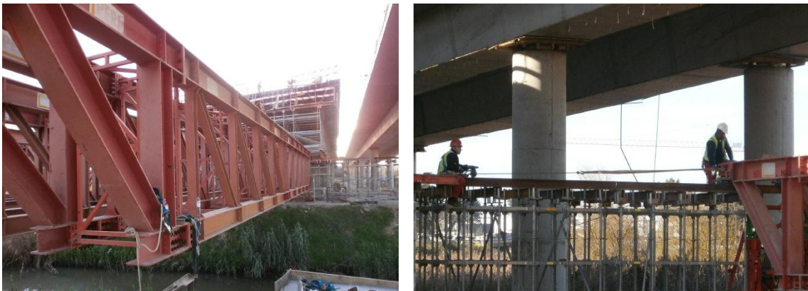
Imagem 7 - Deslocação das asnas do tabuleiro esquerdo para o direito, numa primeira fase por cimbra e tensores
