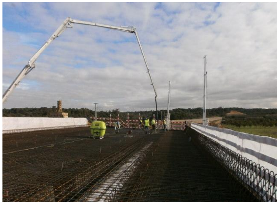
Imagem 4 - Betonagem do 10º tramo do viaduto esquerdo
