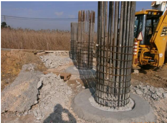
Imagem 16 - Armadura dos pilares (à esquerda) e cofragem dos pilares (à direita)
