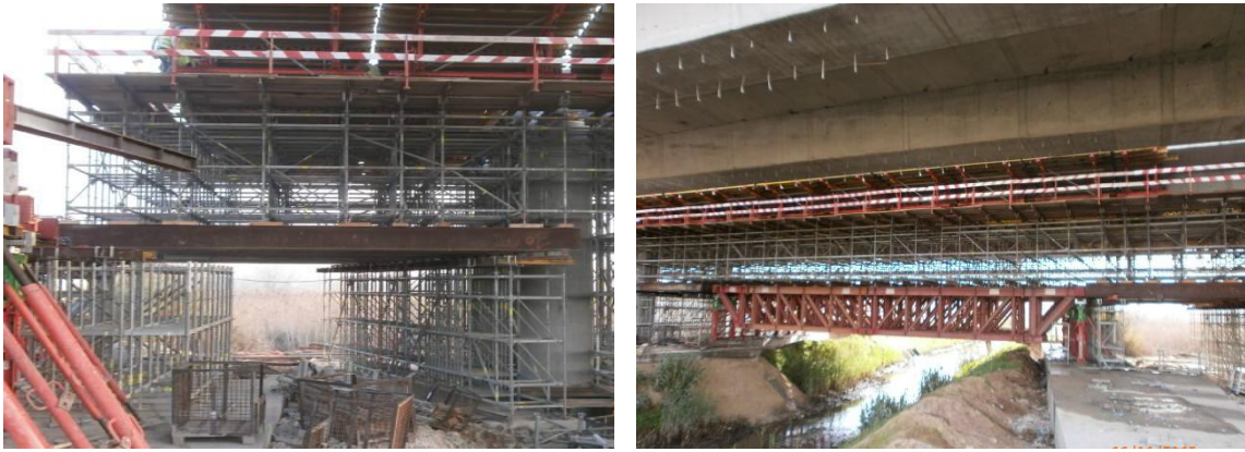
Imagem 6 - Cimbra constituído por torres e vigas (à esquerda) e sobre o Rio em asnas metálicas (à direita)
