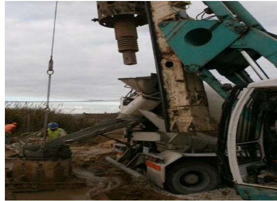
Imagem 15 - Betonagem de uma estaca, com recurso a bomba, funil e tubo trémie (à esquerda) e por descarga directa com recurso a funil e tubo trémie (à direita)
