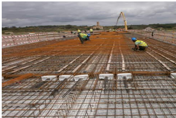
Imagem 30 - Aplicação do aço activo e passivo no tabuleiro. Podemos constatar que existe um pequeno desvio na bainha (da direita) do pré-esforço, causada pelas treliças das pré-lajes
