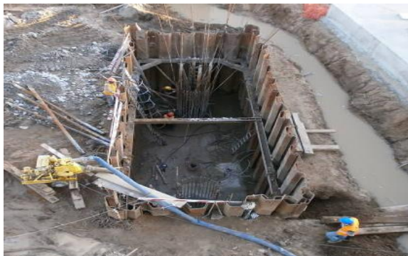
Imagem 26 - Extracção da água através de maíolos mecânicos
