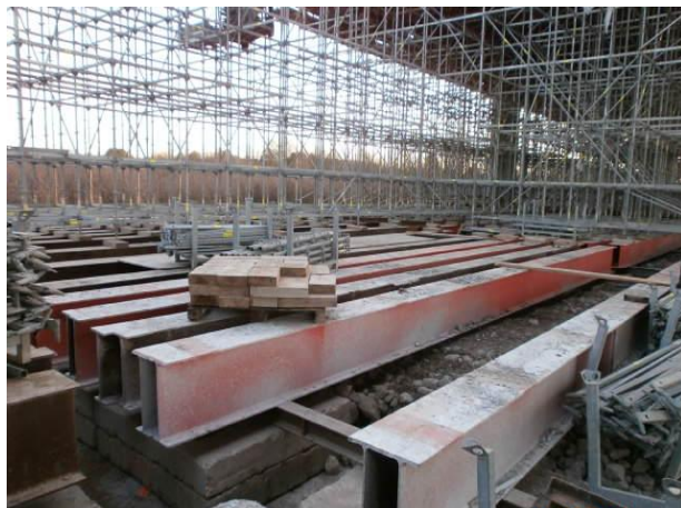
Imagem 27 - Cimbra sobre vigas metálicas
