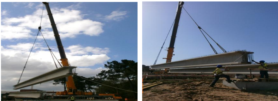
Imagem 20 - Colocação das vigas pré-esforçadas
