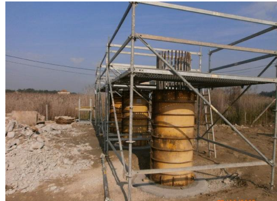
Imagem 16 - Armadura dos pilares (à esquerda) e cofragem dos pilares (à direita)
