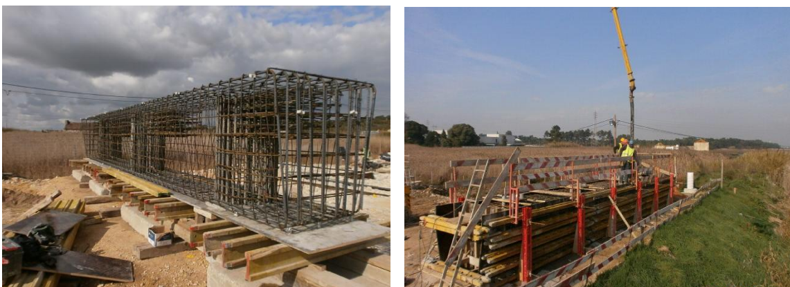
Imagem 18 - Armadura (à esquerda) e betonagem (à direita) da viga travessa
