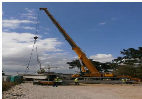
Imagem 29 - Obstrução da passagem pelo camião de transporte de vigas
