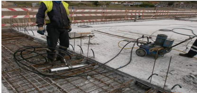
Imagem 24 - Tensionamento dos cabos de pré-esforço (Bomba e macaco hidráulico)
