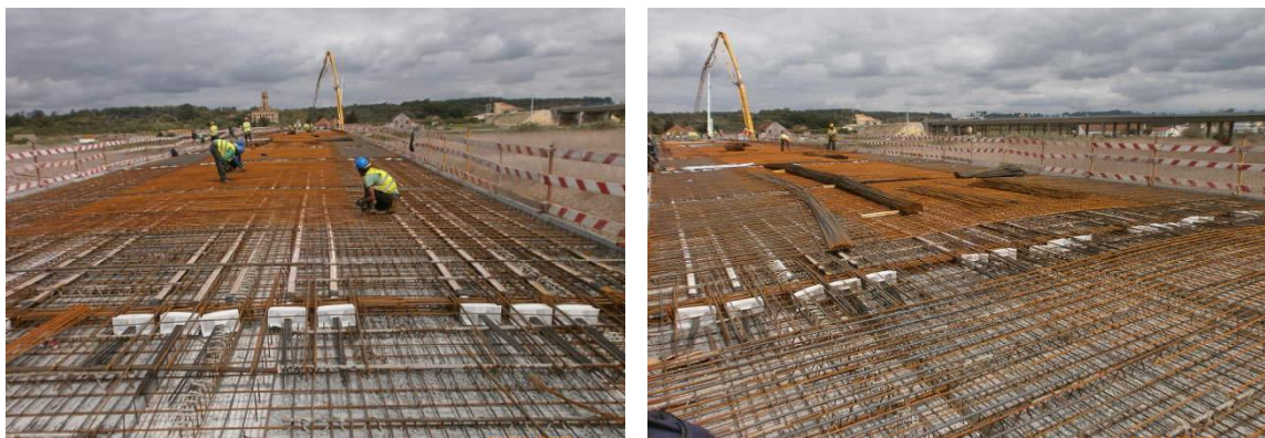
Imagem 22 - Aplicação do aço passivo e activo
