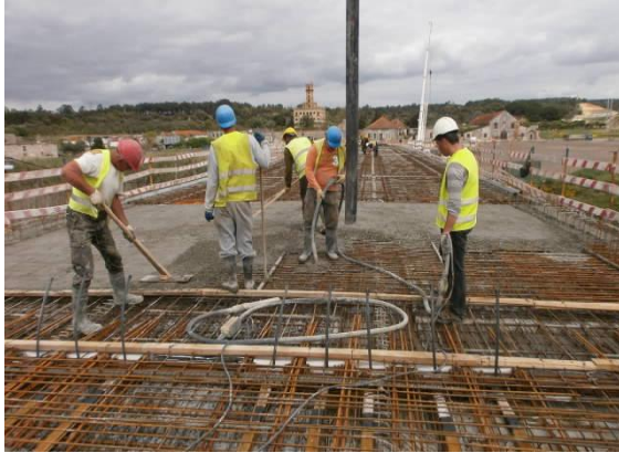
Imagem 23 - Betonagem de um troço do tramo P5
