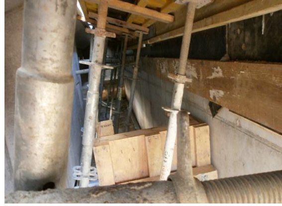
Imagem 9 - Betonagem da laje de transição (à esquerda) e cofragem (no interior do encontro) do muro de testa e cachorro (à direita)
