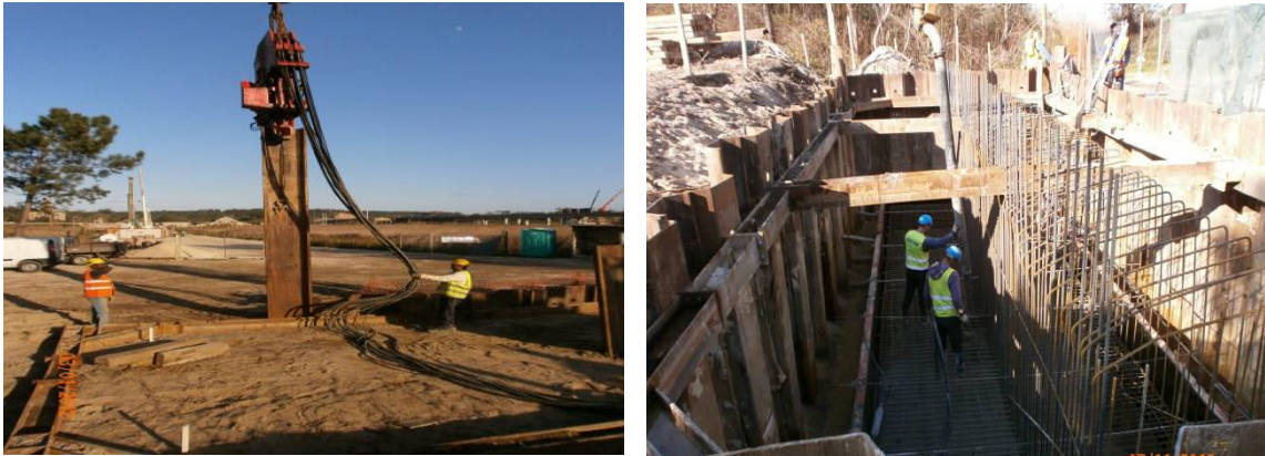
Imagem 17 - Cravação das estacas-prancha no solo (à esquerda) e betonagem da sapata do encontro 1
