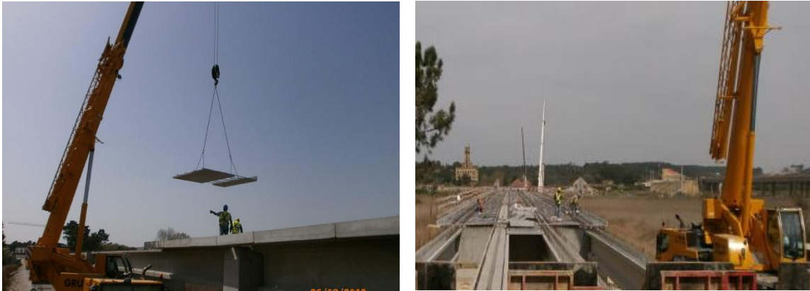
Imagem 21 - Colocação das pré-lajes
