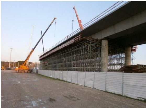
Imagem 3 - Cimbre ao solo contínuo (à esquerda) e cimbre em torres e vigas (à direita)
