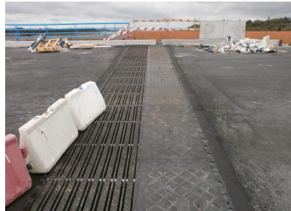
Imagem 11 - Colocação das juntas de dilatação
