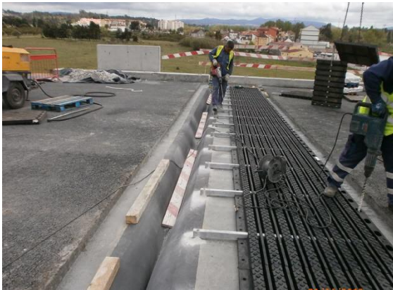
Imagem 11 - Colocação das juntas de dilatação
