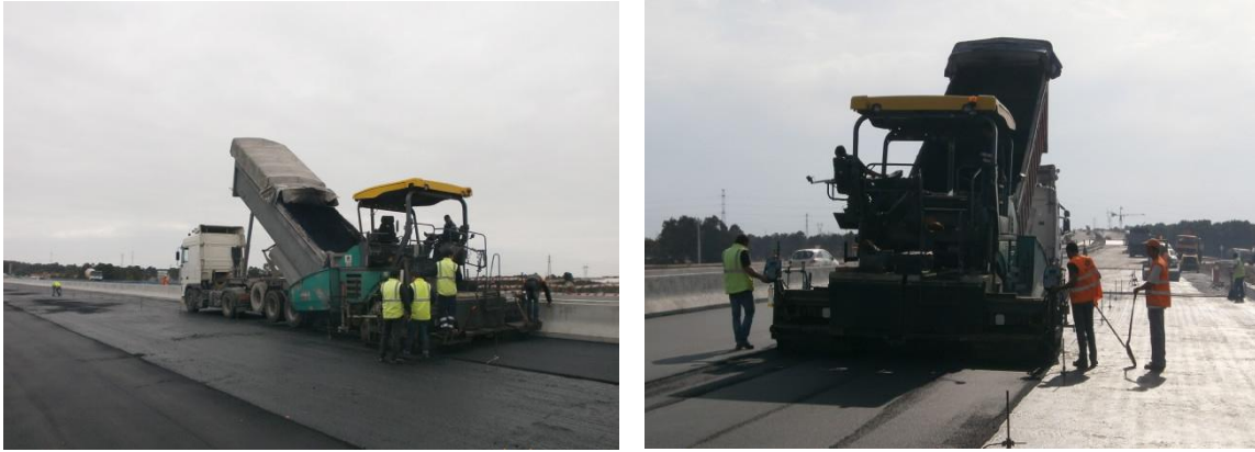
Imagem 12 - Pavimentação, estrato de desgaste
