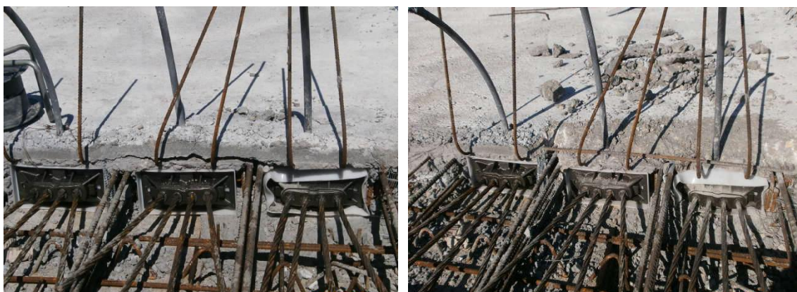
Imagem 31 - Penetração das ancoragens (à esquerda) e clarificação das zonas imperfeitas (à direita)
