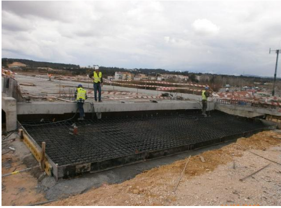
Imagem 9 - Betonagem da laje de transição (à esquerda) e cofragem (no interior do encontro) do muro de testa e cachorro (à direita)
