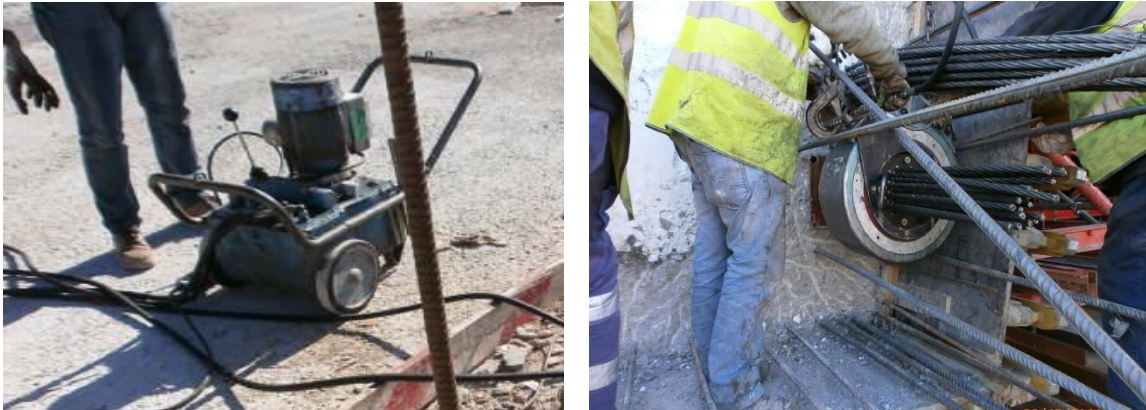
Imagem 5 - Tensionamento dos cabos de pré-esforço (Bomba e macaco hidráulico para o tensionamento, à esquerda e direita, respectivamente)
