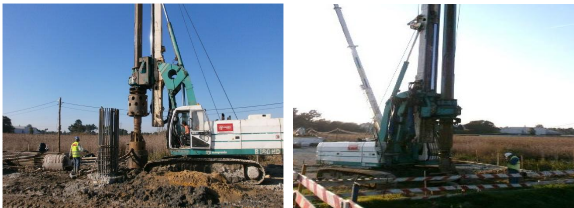
Imagem 14 - Escavação com recurso a balde (à esquerda) e a trado (à direita)
