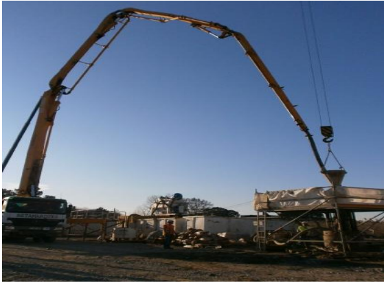
Imagem 15 - Betonagem de uma estaca, com recurso a bomba, funil e tubo trémie (à esquerda) e por descarga directa com recurso a funil e tubo trémie (à direita)
