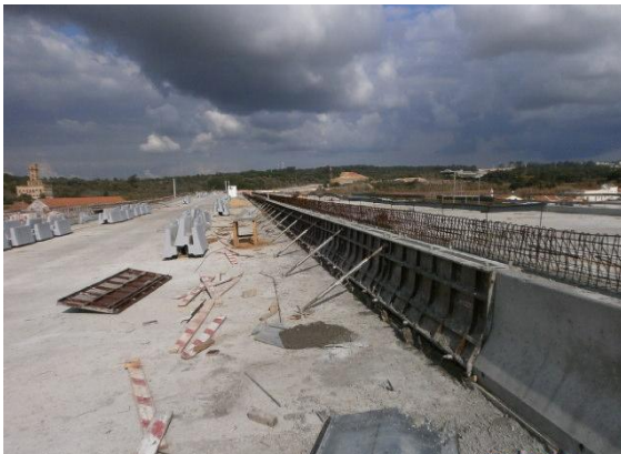
Imagem 10 - Cofragem do new-jersey (à esquerda) e colocação nas cornijas (à direita)
