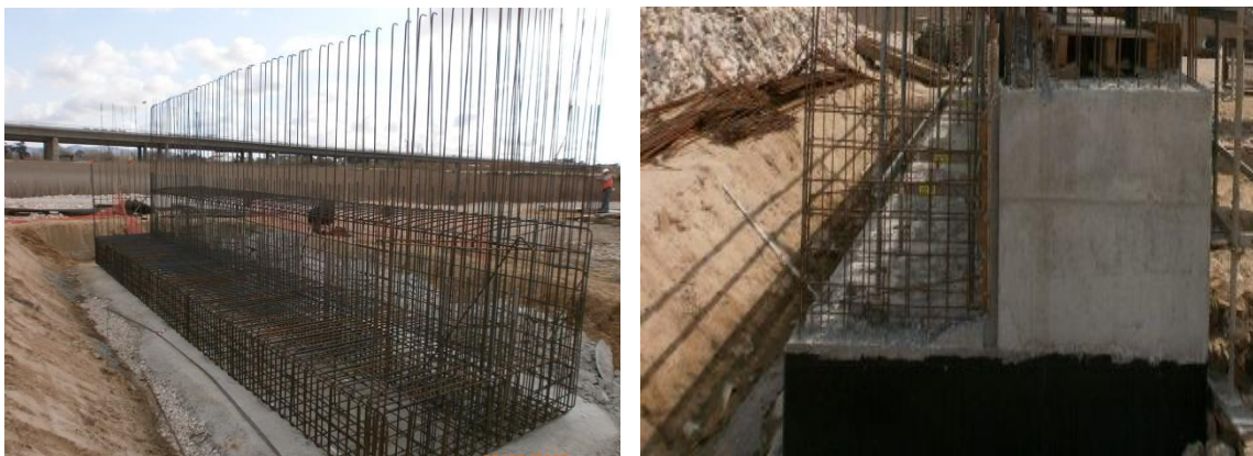
Imagem 19 – Armadura do maciço de encabeçamento e viga de estribo (à esquerda) e elementos betonados (à direita)
