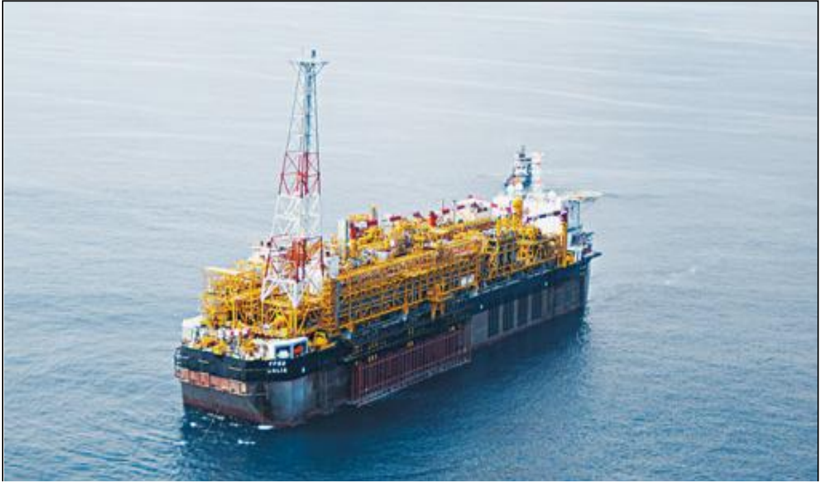
Figura 8 - FPSO DALIA da TOTAL em Angola, Bloco 17.
