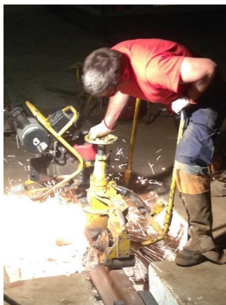
Figura 6.13 - Esmerilagem da soldadura
