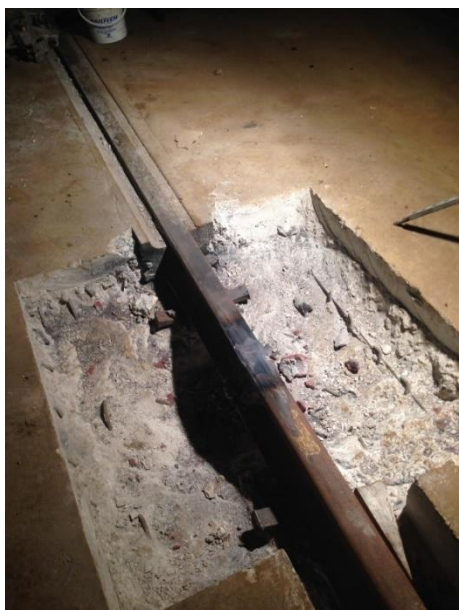
Figura 6.14 – Zona da soldadura após esmerilagem
