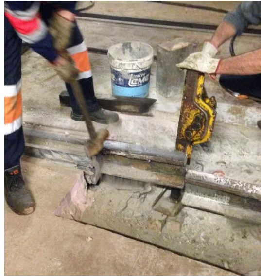
Figura 6.5 - Macacos hidráulicos na ajuda à despregação da barra
