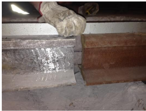
Figura 6.7 - Alinhamento das barras para soldadura
