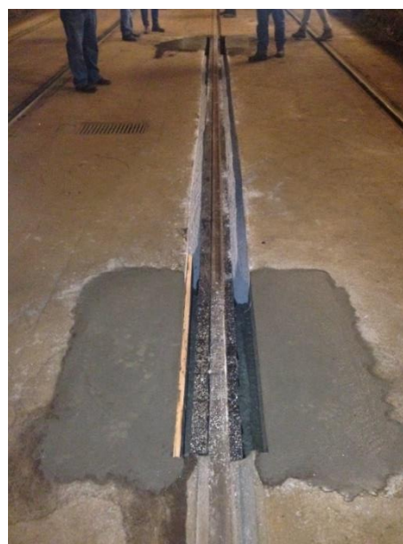
Figura 6.22 - Pormenor da zona betonada já sem cofragem
