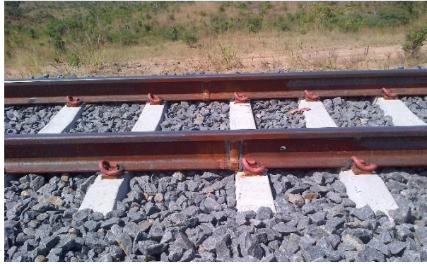
Figura 4.10 - Pregação próxima à zona de soldadura (Fonte: Eng a Maria Peneda)
