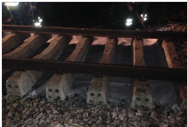
Figura 5.31 - Colocação de manta geotêxtil sob a camada de balastro
