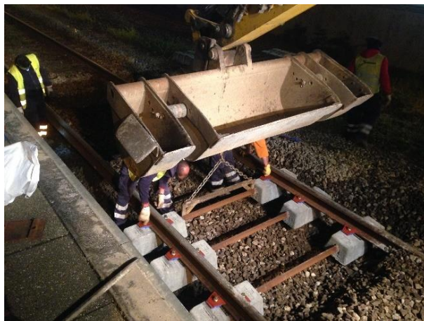
Figura 5.25 - Colocação de travessa nova e posterior aperto
