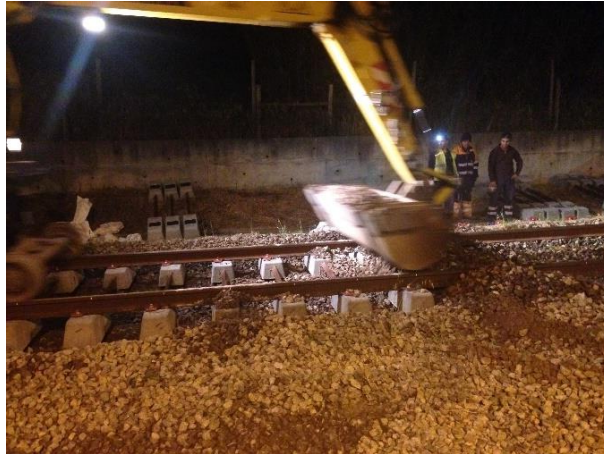
Figura 5.26 - Colocação de balastro
