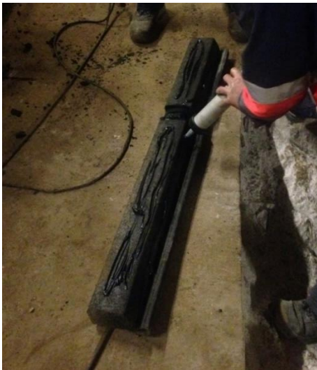
Figura 6.17 - Aplicação de resina especial para colar as mangas ao carril
