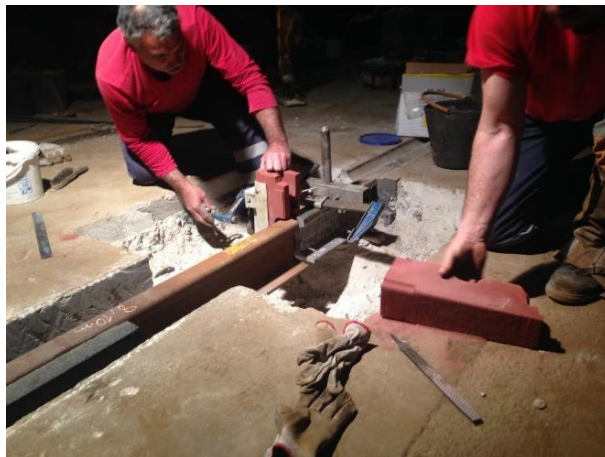
Figura 6.8 - Colocação dos moldes para a soldadura
