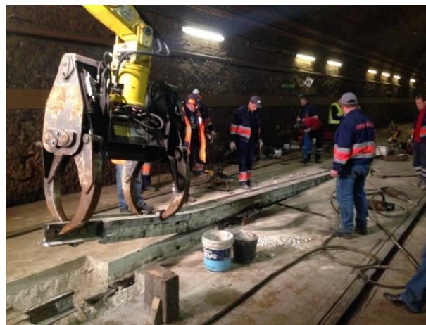
Figura 6.6 - Substituição da barra com recurso a Railroute
