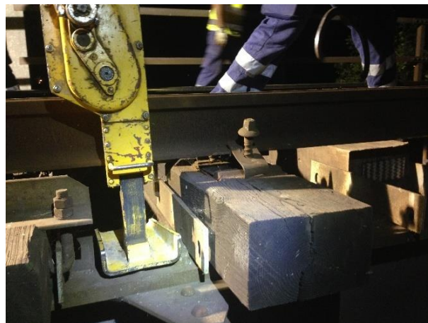
Figura 5.28 - Elevação da via por meio de macaco hidráulico
