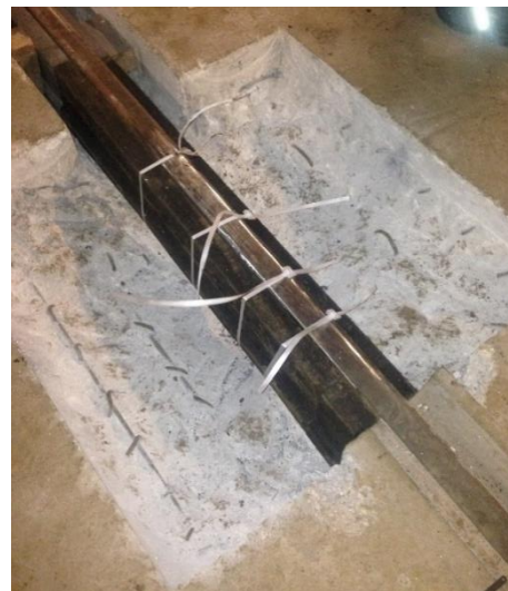
Figura 6.18 - Aplicação das mangas no carril com auxílio de braçadeiras
