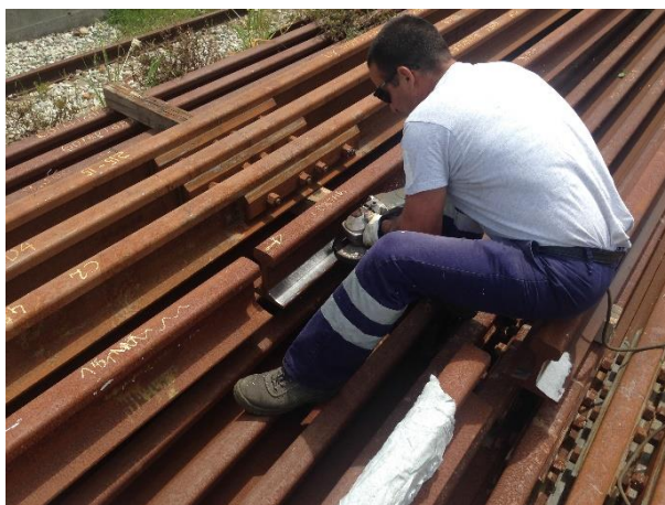
Figura 5.15 - Limpeza do carril
