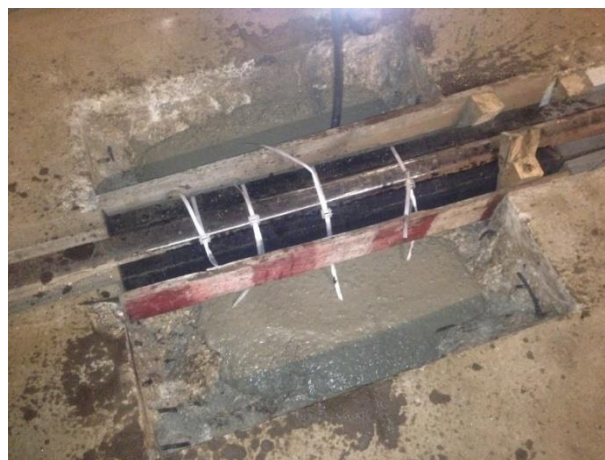
Figura 6.20 - Betonagem da laje
