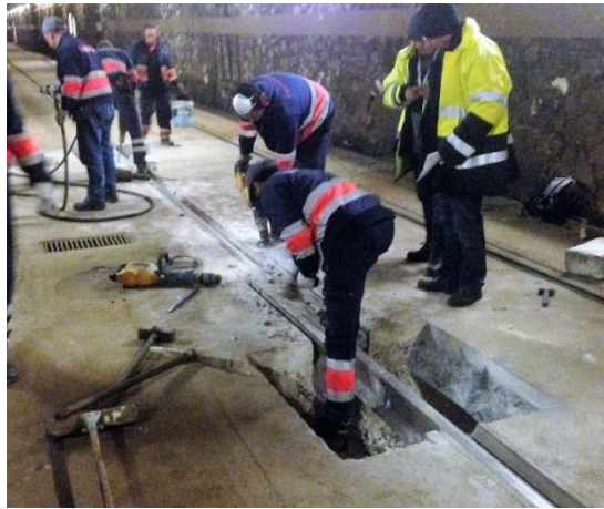
Figura 6.4 - Descolagem da secção de carril à laje
