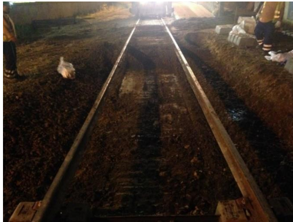
Figura 5.30 - Plataforma após desguarnecimento
