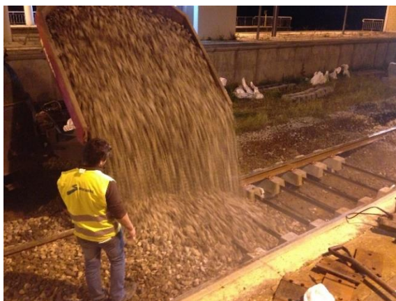
Figura 5.32 - Descarga de balastro novo por meio de “dumper”
