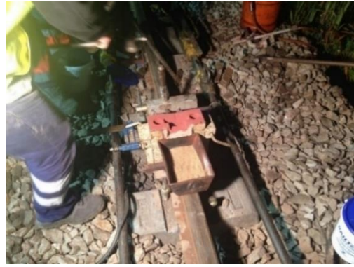
Figura 5.7 - Colocação do molde e posterior calafetagem
