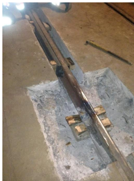
Figura 6.15 - Aplicação de cunhas de madeira
