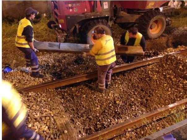
Figura 5.24 - Remoção da travessa existente
