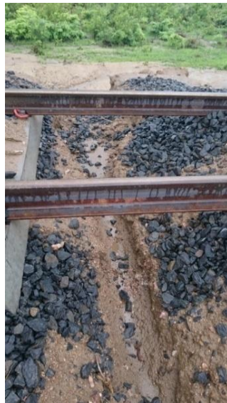
Figura 4.17 - Lavagem da camada de balastro (Fonte: Eng a Maria Peneda)
