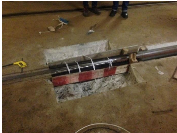
Figura 6.19 - Criação de cofragem para betonagem
