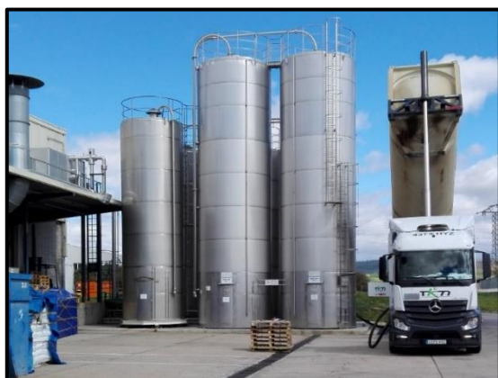
Figura 3.47 – Silos de matéria-prima
