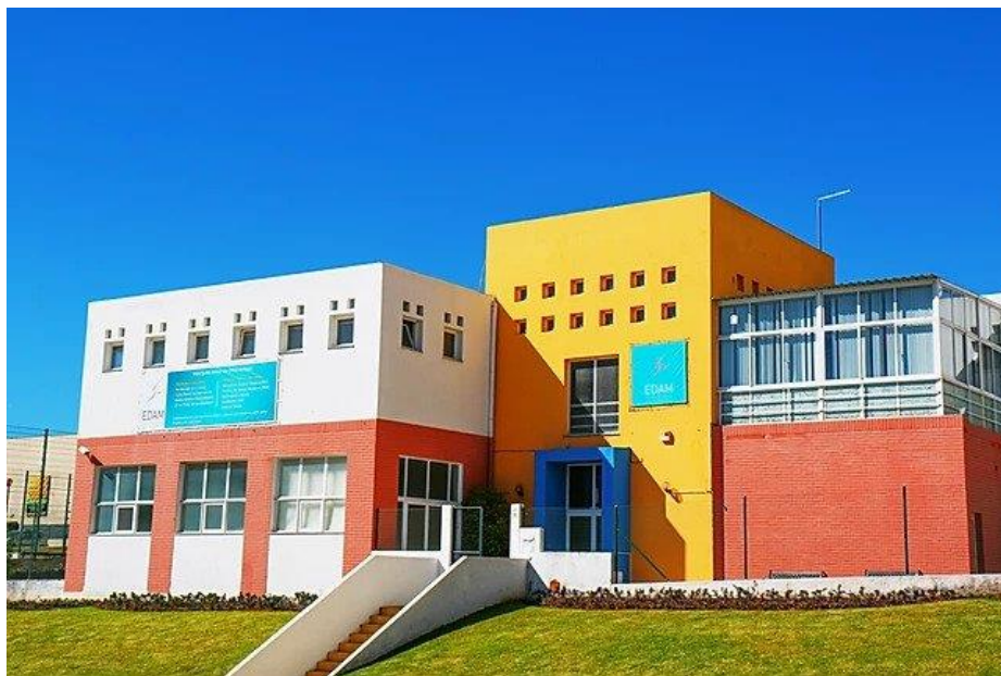
Figura 1 – Instalações da Escola de Dança Ana Mangericão
