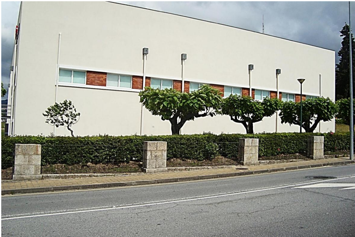
Figura VIII.3 - Centro de Atendimento Permanente em Seia (após intervenção) - Vista Posterior
