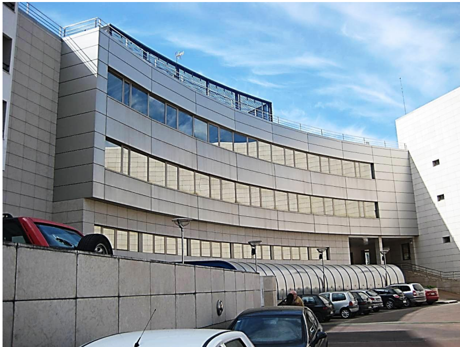
Figura I.1.1 – Edifício Sede de Escritórios em Coimbra – Fachada Norte
