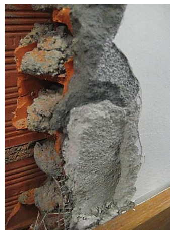
Figura II.7.4 – Edifício Sede de Escritórios em Coimbra - Sondagem S2.3 (Rede de fibra existente no reboco da base da parede)
