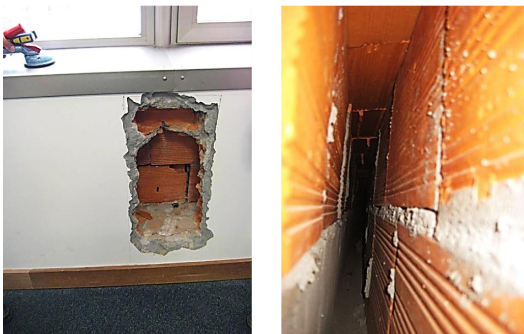
Figura II.5 – Edifício Sede de Escritórios em Coimbra - Sondagem S4.2 (Piso 2 - Fachada Norte)
