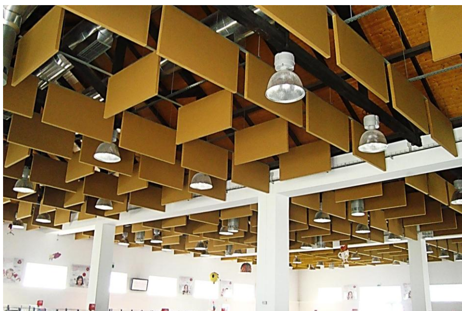
Figura VIII.6 - Centro de Atendimento Permanente em Seia (após intervenção) - Tratamento Acústico
