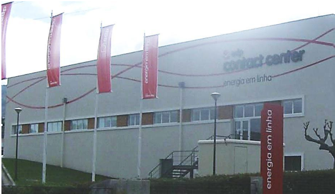
Figura IV.3 - Centro de Atendimento Permanente em Seia (antes da intervenção) - Fachada Norte
