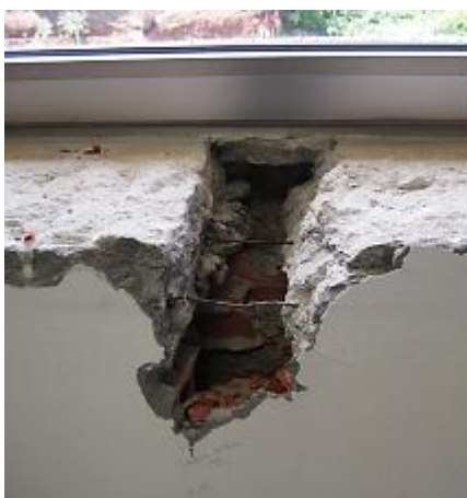
Figura II.7.3 – Edifício Sede de Escritórios em Coimbra - Sondagem S2.3 (Sondagem no lintel de betão existente sobre os dois panos de alvenaria da parede)
