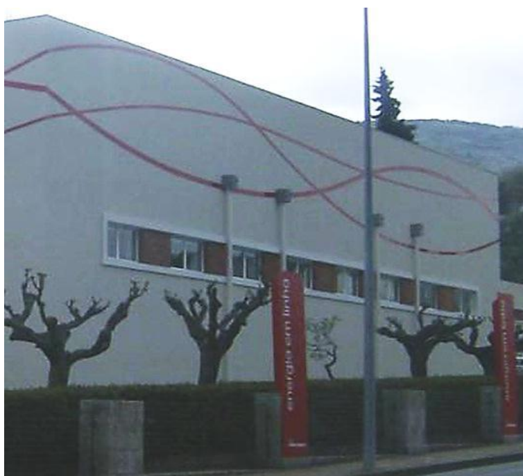
Figura IV.2 - Centro de Atendimento Permanente em Seia (antes da intervenção) - Vista Posterior
