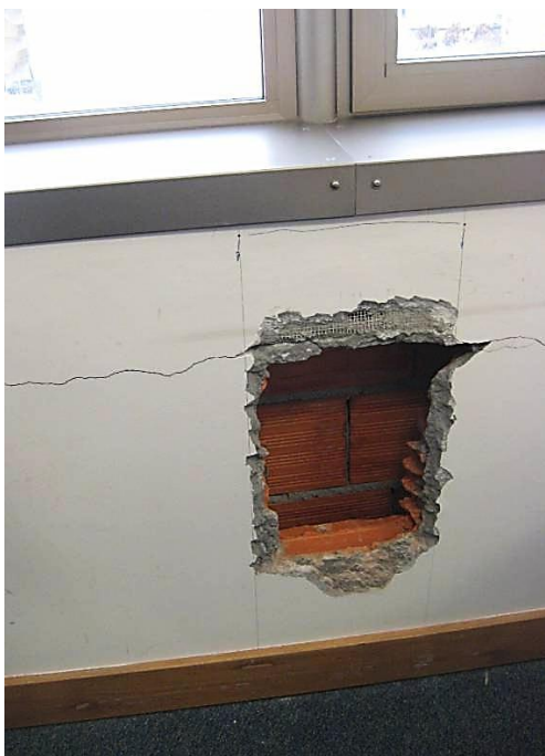
Figura II.9.1 – Edifício Sede de Escritórios em Coimbra - Sondagem S4.3 (Piso 3 – Fachada Norte)
