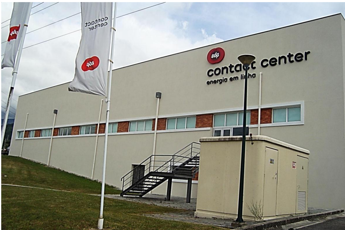
Figura VIII.4 - Centro de Atendimento Permanente em Seia (após intervenção) - Fachada Norte
