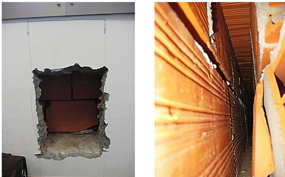
Figura II.3 – Edifício Sede de Escritórios em Coimbra - Sondagem S2.2 (Piso 2 – Fachada Sul)
