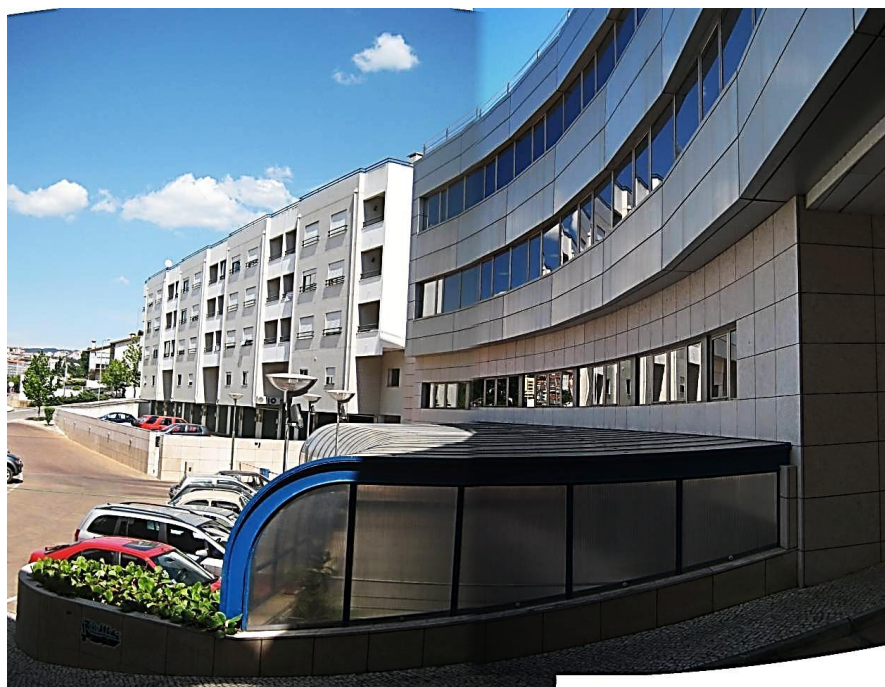
Figura I.1.2 - Edifício Sede de Escritórios em Coimbra – Fachada Norte
