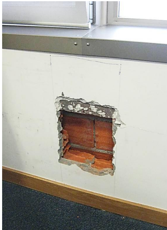
Figura II.8 – Edifício Sede de Escritórios em Coimbra - Sondagem S3.3 (Piso 3 – Fachada Norte)
