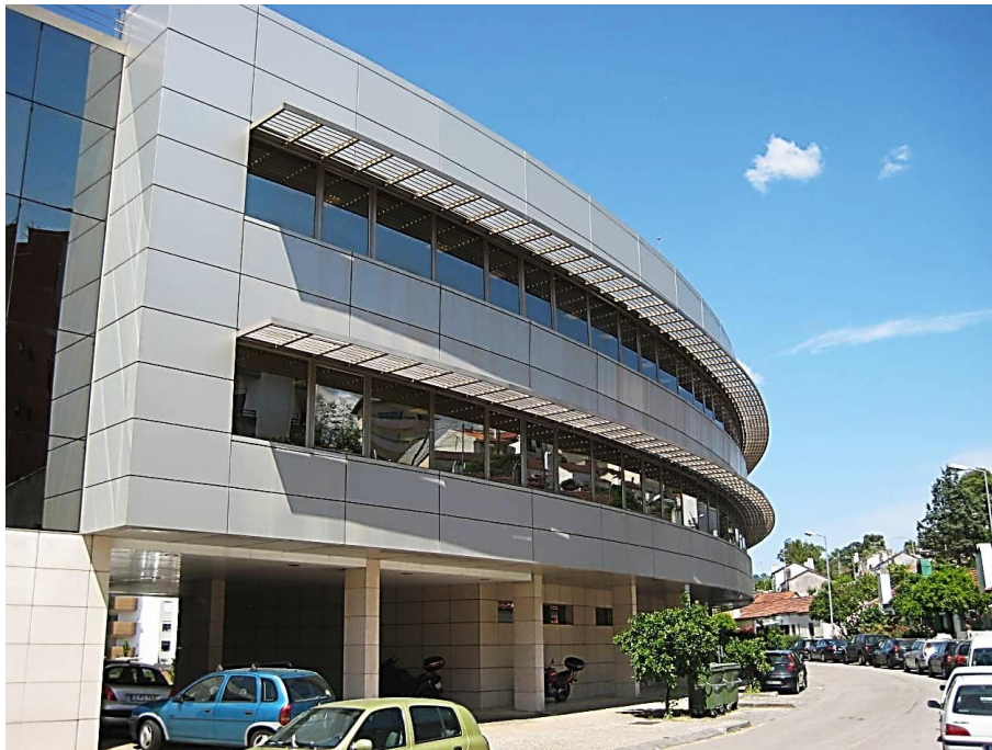
Figura I.2.12 - Edifício Sede de Escritórios em Coimbra – Fachada Sul
