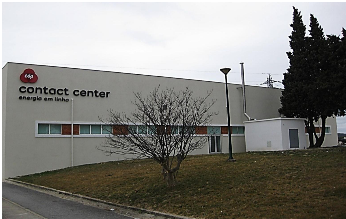
Figura VIII.2 - Centro de Atendimento Permanente em Seia (após intervenção) - Fachada Sul
