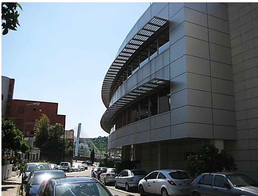
Figura I.2.2 - Edifício Sede de Escritórios em Coimbra – Fachada Sul
