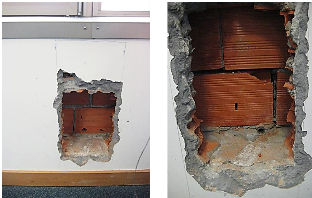
Figura II.4 – Edifício Sede de Escritórios em Coimbra - Sondagem S3.2 (Piso 2 – Fachada Norte)
