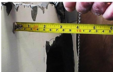
Figura II.7.6 – Edifício Sede de Escritórios em Coimbra - Sondagem S2.3 (Inclinação da parede de fachada)
