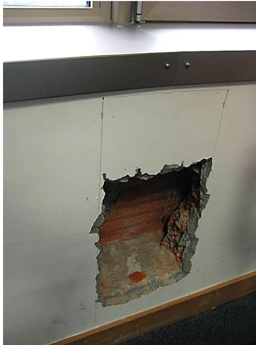
Figura II.2 – Edifício Sede de Escritórios em Coimbra - Sondagem S1.2 (Piso 2 – Fachada Sul)
