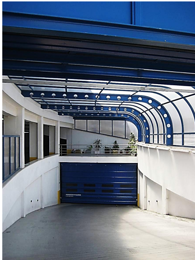
Figura I.1.31 - Edifício Sede de Escritórios em Coimbra – Fachada Norte (acesso ao estacionamento)
