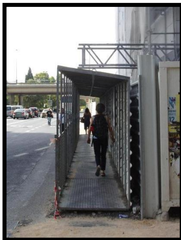
Figura 3.9 – Passadiço pedonal Av.Cipriano Dourado
