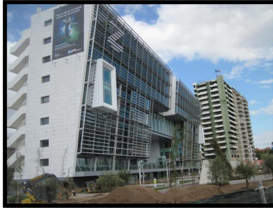
Figura 4.33 – Aspeto final da fachada cortina
