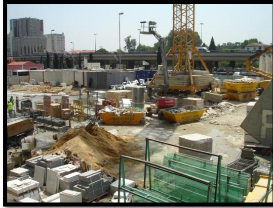
Figura 3.8 – Estaleiro de obra em fase de reorganização
