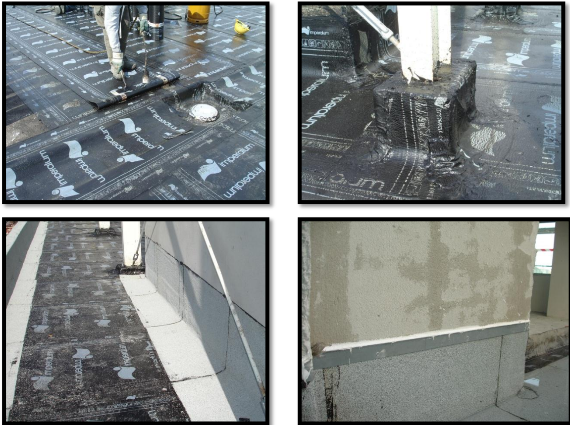
Figura 4.7 – Revestimento de impermeabilização
