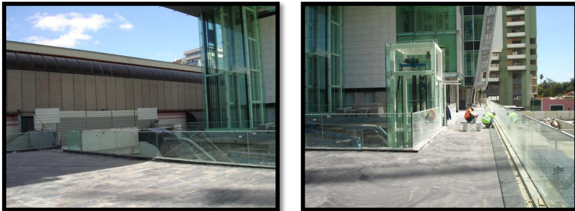
Figura 4.15 – Varanda de acesso à estação de metropolitano
