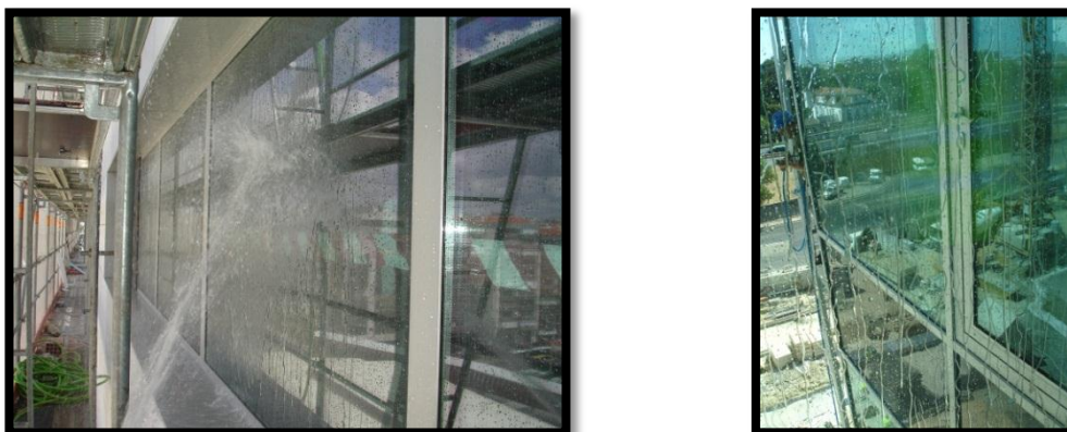
Figura 4.42 – Ensaios de estanquidade dos vãos exteriores e fachada cortina
