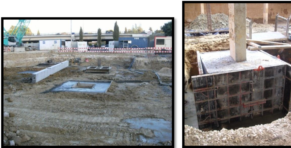
Figura 2.11 – Trabalhos preparatórios de colocação dos pilares pré-fabricados
