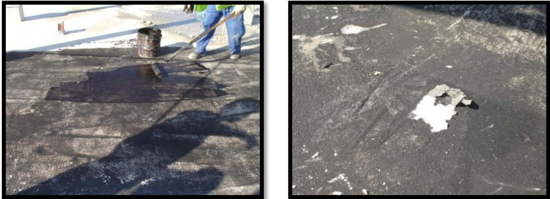
Figura 4.1 – Aplicação da barreira pára-vapor
