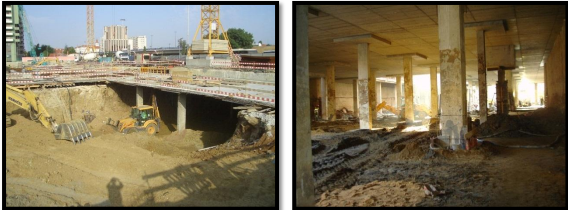
Figura 2.5 – Escavações método “Top-Down”
