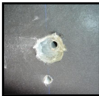
Figura 4.21 – Furação para colocação das fixações
