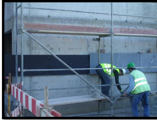
Figura 4.20 – Fixação do isolamento térmico no paramento exterior
