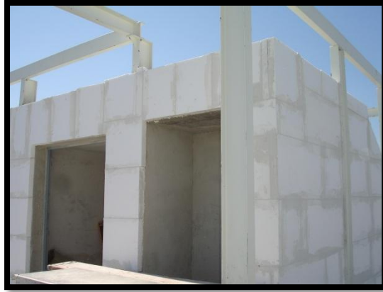
Figura 4.13 – Revestimento das paredes dos núcleos das escadas
