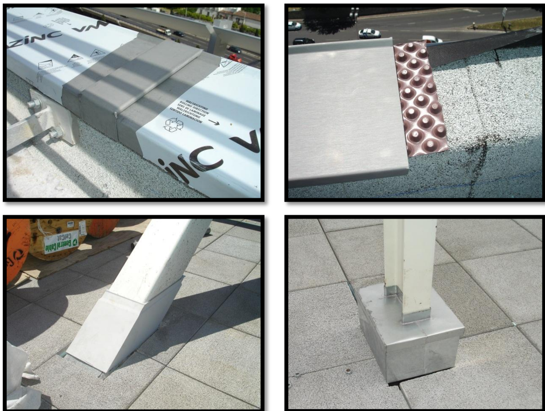
Figura 4.11 – Caapeamento de muretes, plintos e estrutura metálica da treliça
