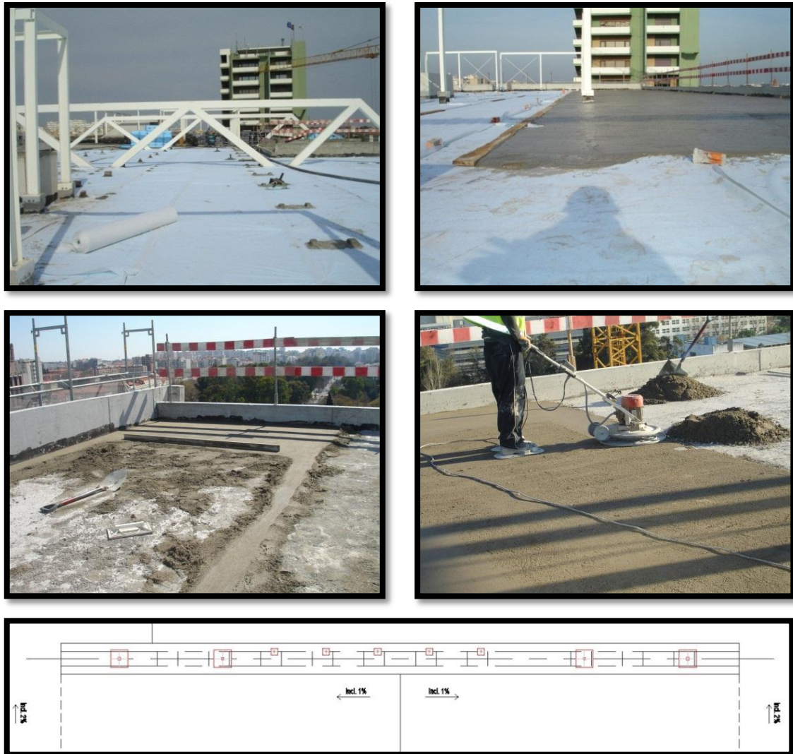
Figura 4.3 - Colocação da manta geotêxtil e execução da camada de forma e regularização
