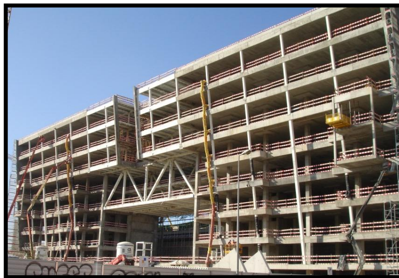
Figura 2.14 - Aspeto geral da estrutura elevada
