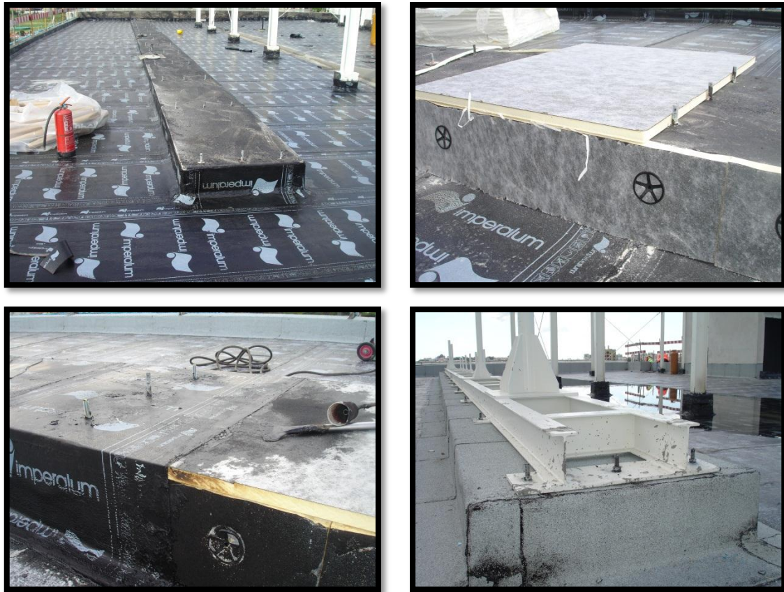
Figura 4.8 – Revestimento de impermeabilização do maciço
