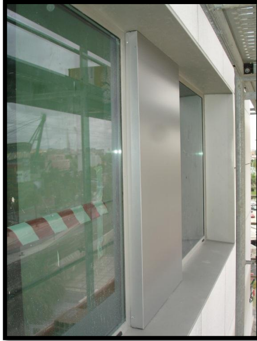
Figura 4.32 – Aspeto final dos vãos exteriores
