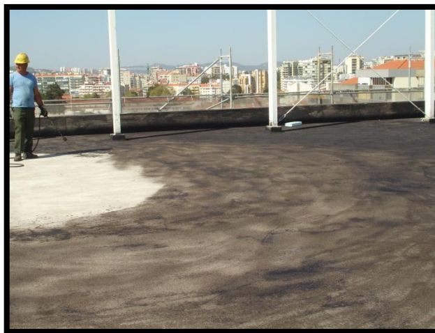
Figura 4.6 - Aplicação da camada impregnante
