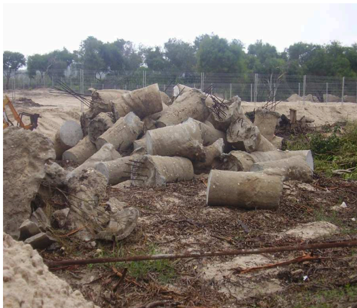
Figura 4.13 - Cabeças de estacas removidas para britagem (Contacto, 2006)
