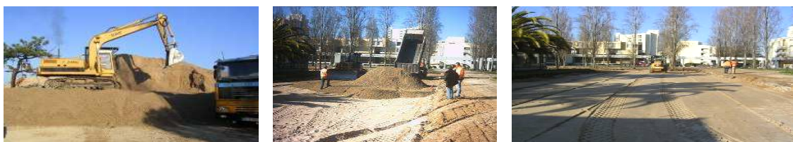
Figuras 4.30 a 4.32 – Execução de um arruamento com recurso a R CD (Contacto, 2007)
