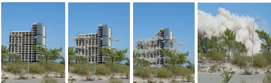
Figuras 4.6 a 4.9 – As fases da implosão da Torre 06 (Contacto, 2005)
