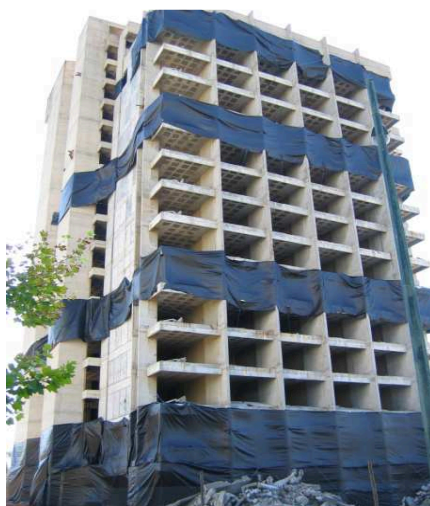
Figura 4.4 - A proteção dos pisos com cargas explosivas da Torre 06 (Contacto, 2005)
