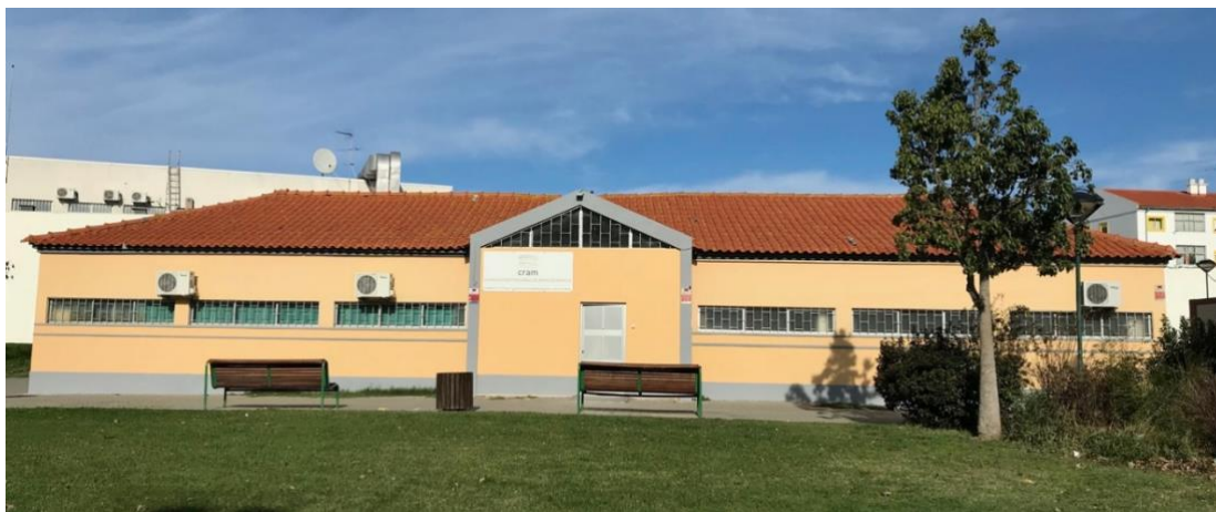
Figura 4 - Instalações da Casa Amarela
