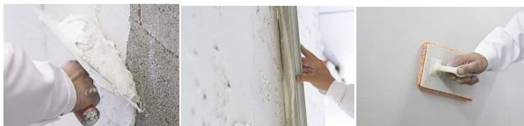
Figura 13 – Aplicação do reboco (Weber Saint-Gobain, 2013)
