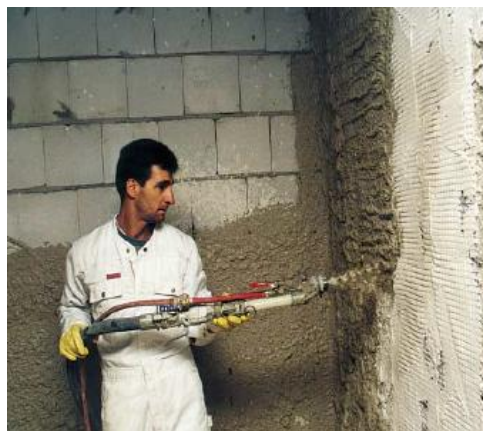
Figura 20 - Aplicação de reboco com PCM. (Schubert, 2005)
