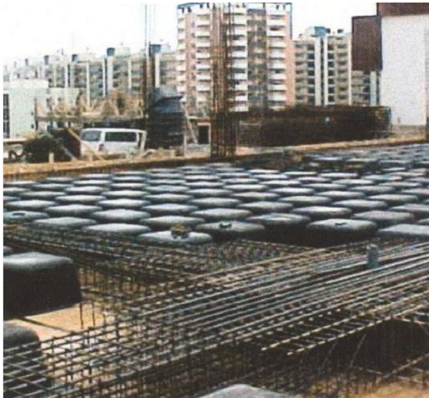
Figura 1 – Lajes Fungiformes Nervuradas - Cofragem
