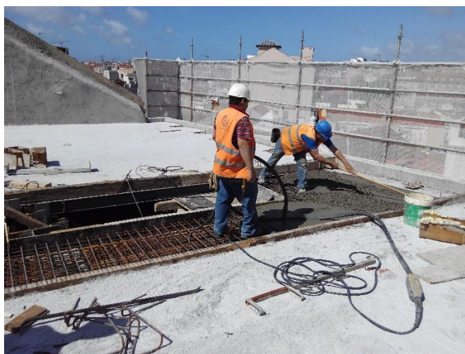
Figura 44 - Betonagem da Laje
