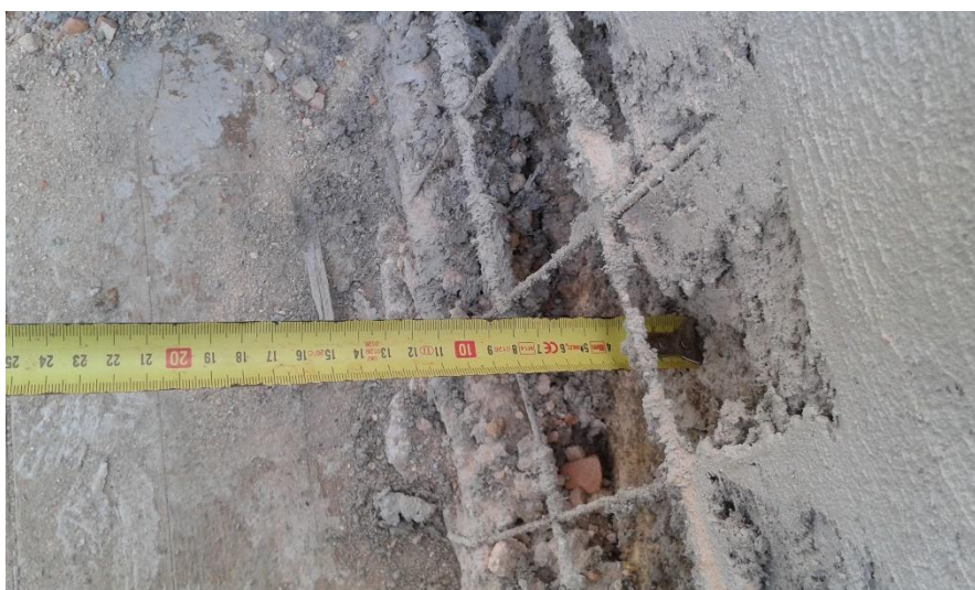
Figura 23 - Verificação da espessura da lâmina de microbetão
