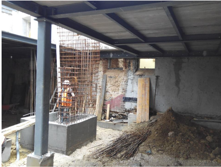
Figura 12 - Armaduras de espera no fosso do elevador
