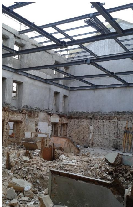
Figura 12 - Demolição do piso térreo do Edifício do Largo das olarias nº 35 a 42
