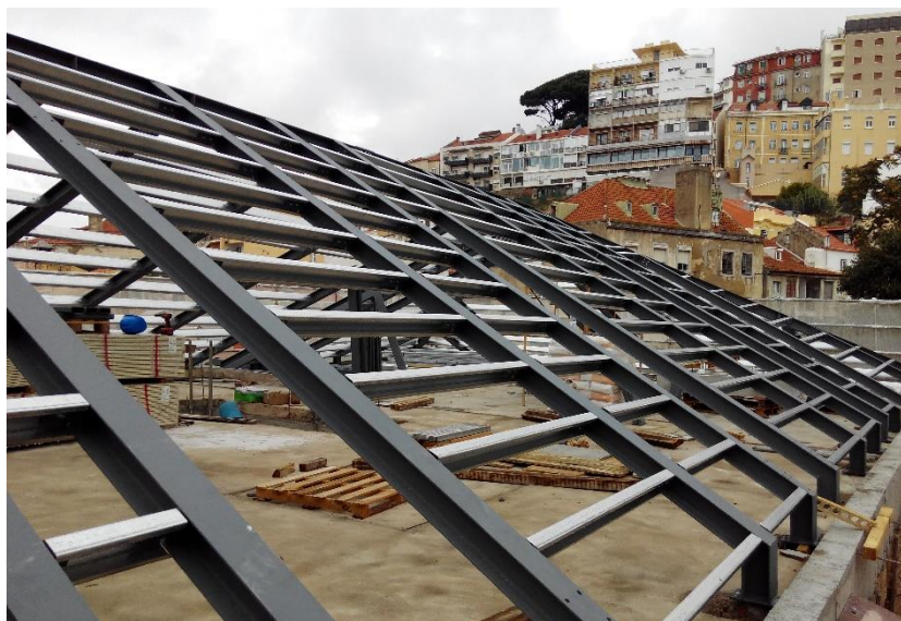
Figura 4613 - Estrutura da cobertura
