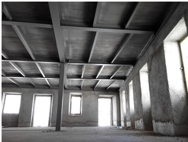
Figura 35 - Aspeto final do piso
