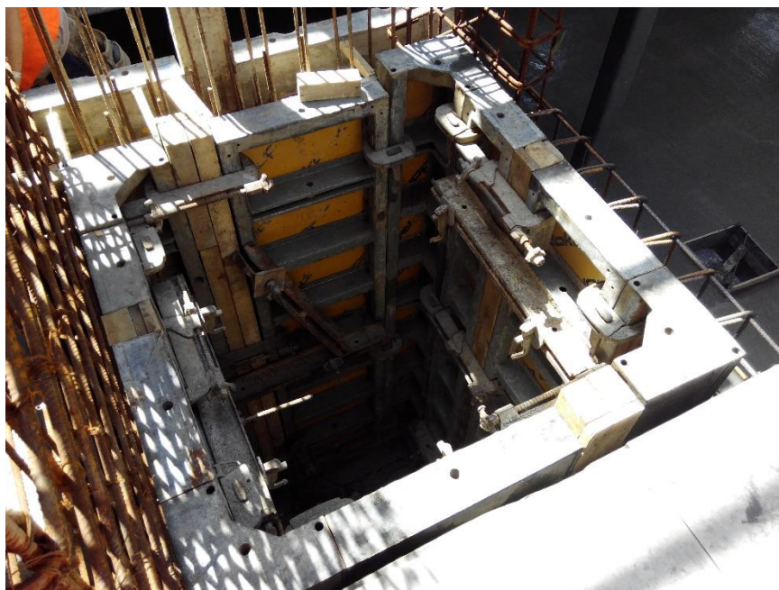
Figura 37 - Interior da cofragem para a caixa do elevador
