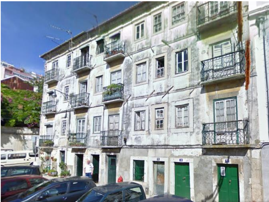
Figura 4 - Aspeto inicial da fachada do edifício do Largo das Olarias nº 35 a 42 (Fonte: Google Street View, Setembro 2015)
