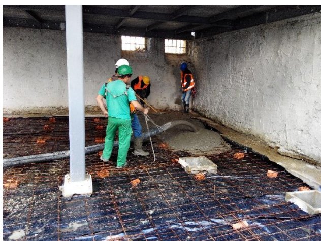
Figura 40 - Betonagem do massame
