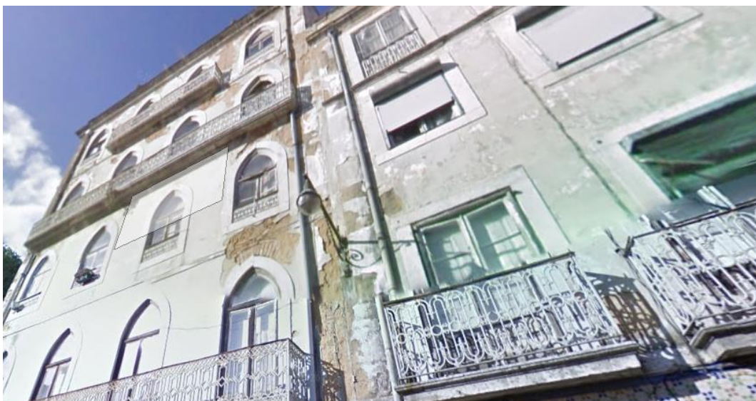
Figura 5 - Pormenor do Aspeto inicial da fachada do edifício da Rua dos Lagares nº 72 e 74 (Fonte: Google Street View, Setembro 2015)
