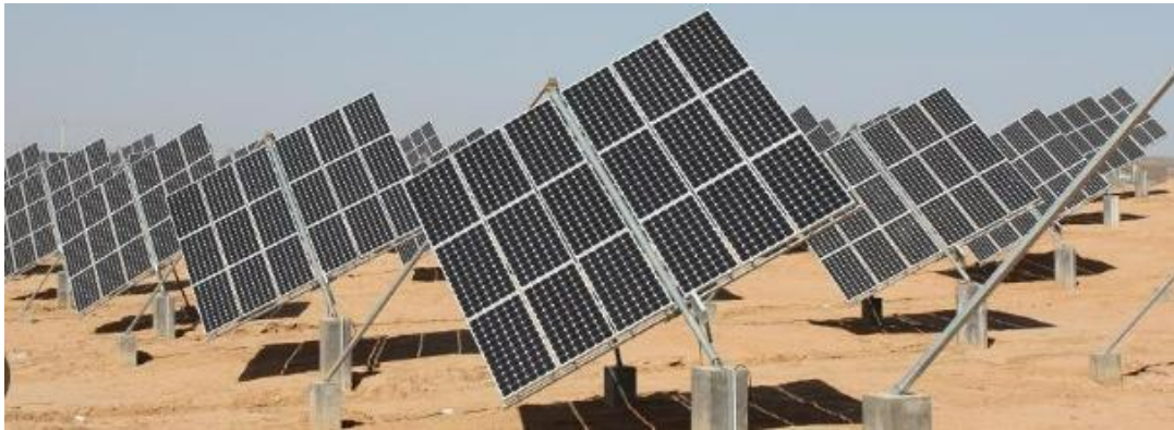
Figura 5 - Tracker de dois eixos
