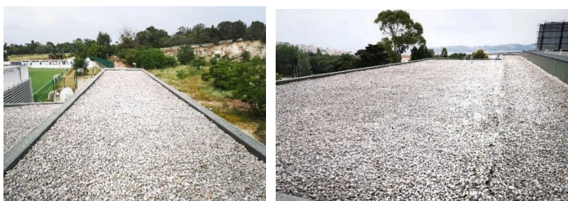
Figura 58- Cobertura da Piscina Municipal do Alvito.
