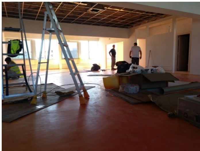
Figura 4.31 - Aplicação de grelha de teto amovível.
