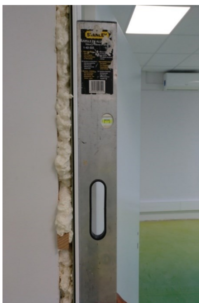
Figura 3.2 Verificação aprume segundo Y
