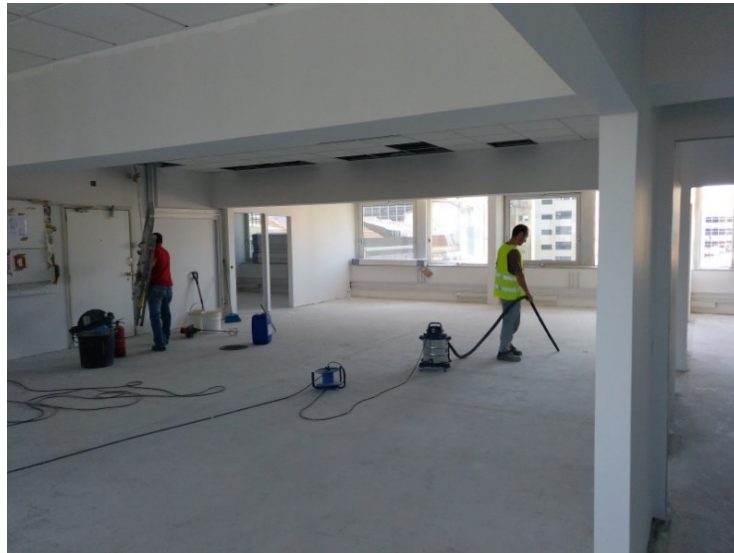
Figura 3.5 Aspiração das partículas de impurezas em pavimentos
