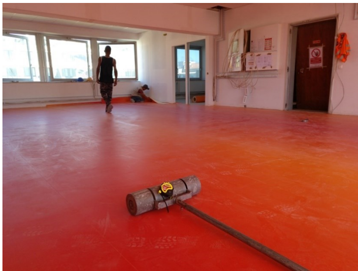
Figura 3.12 Rolo pesado aplicação final
