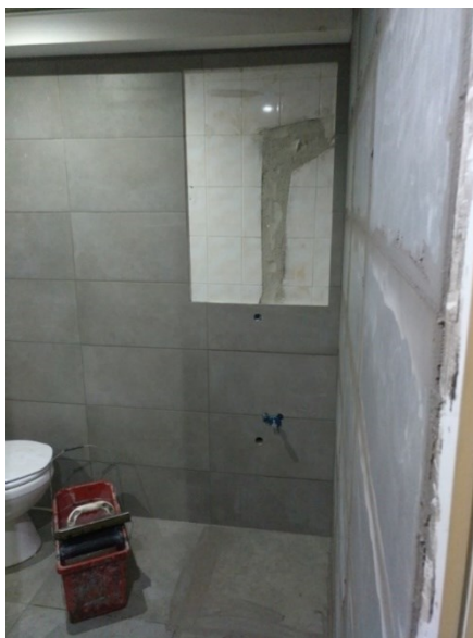
Figura 4.24 - Colagem de ladrilhos sobre os existentes, I.S.
