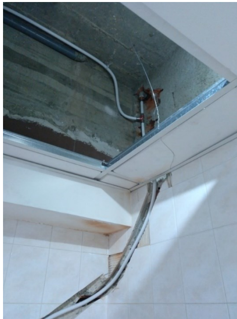
Figura 4.18 - Marcação de passagem tubagem roços até teto (opção executada).
