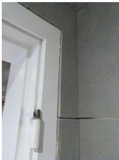
Figura 4.26 - Pormenor junto aos aros das portas de colagem ladrilhos sobre existentes.
