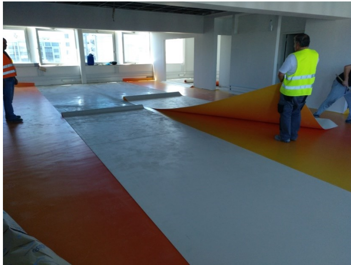
Figura 3.11 Aplicação de vinílico sobre a cola "Mapei Ultrabond333"
