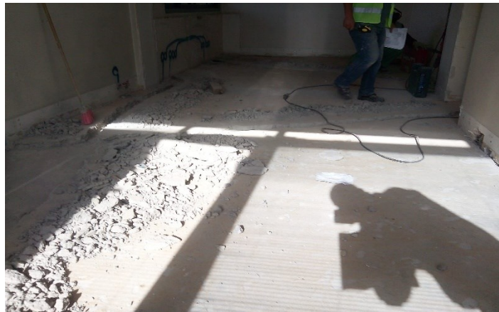
Figura 4.20 - Opção abertura de roços pela laje (solução não adotada).
