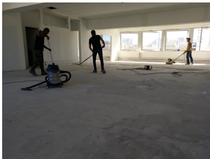
Figura 3.10 Polimento com helicóptero e limpeza
