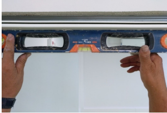
Figura 3.3 Verificação nível segundo X
