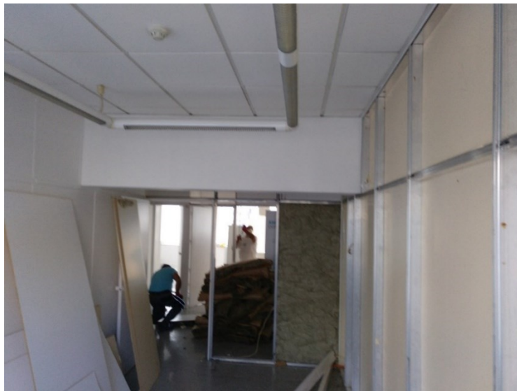
Figura 2.2 Imagem ilustrativa do estado inicial de um dos pisos
