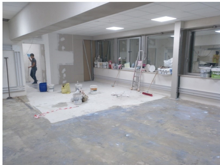
Figura 3.6 Aplicação de camada primário
