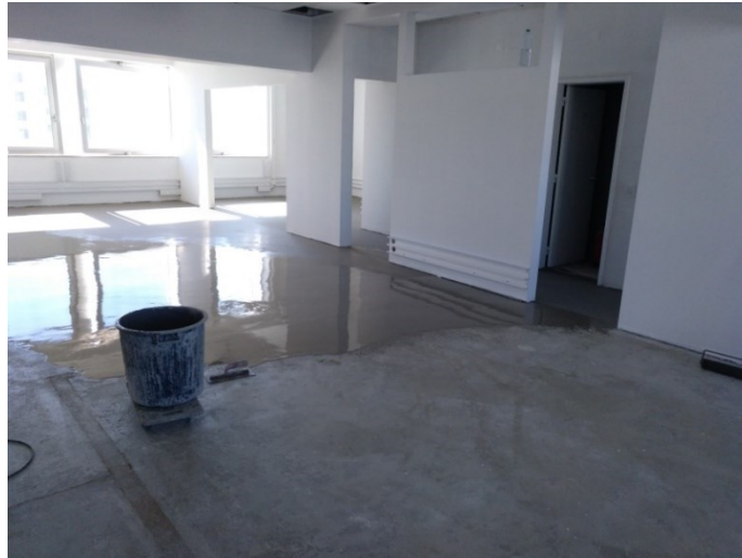
Figura 3.7 Aplicação massa auto-nivelante
