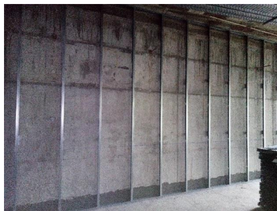
Figura 42 - Estrutura nas paredes periféricas (Fonte: Autor)
