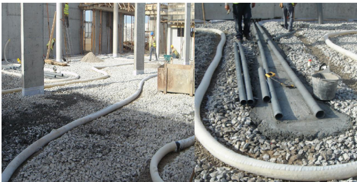
Figura 25 - Colocação dos geodrenos e tubos de drenagem (Fonte: Autor)
