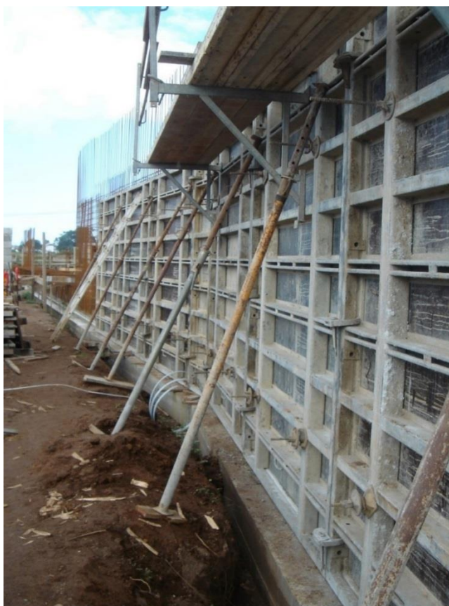
Figura 18 - Cofragem metálica de muros estruturais (Fonte: Autor)
