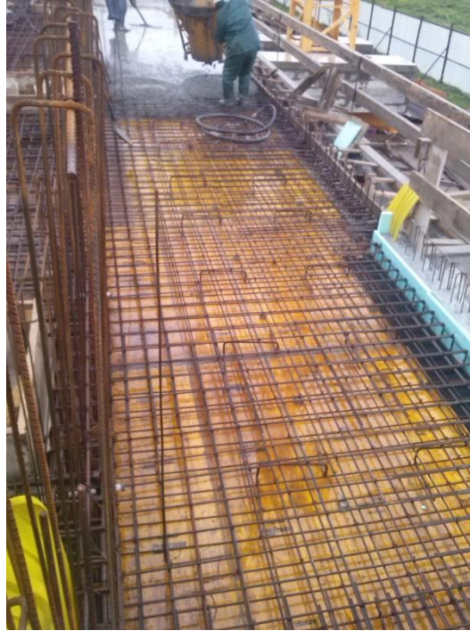
Figura 37 - Betonagem da laje maciça (Fonte: Autor)
