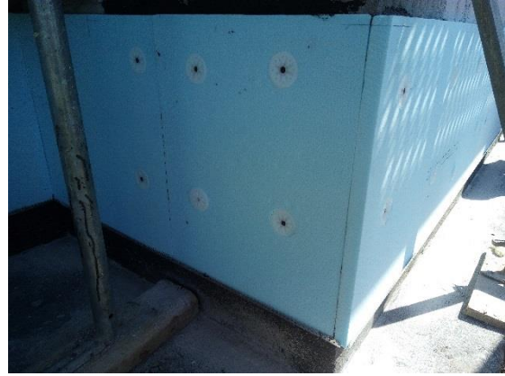
Figura 55 - Fixação mecânica das placas XPS (Fonte: Autor)
