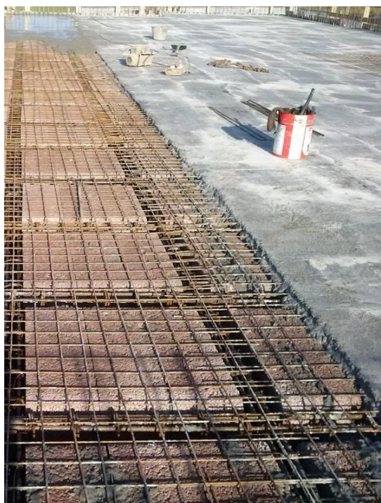
Figura 36 - Betonagem da laje (Fonte: Autor)
