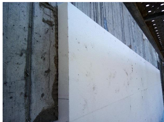
Figura 57 - Colagem das placas EPS (Fonte: Autor)
