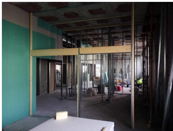
Figura 44 - Reforço na zona das portas de correr (Fonte: Autor)
