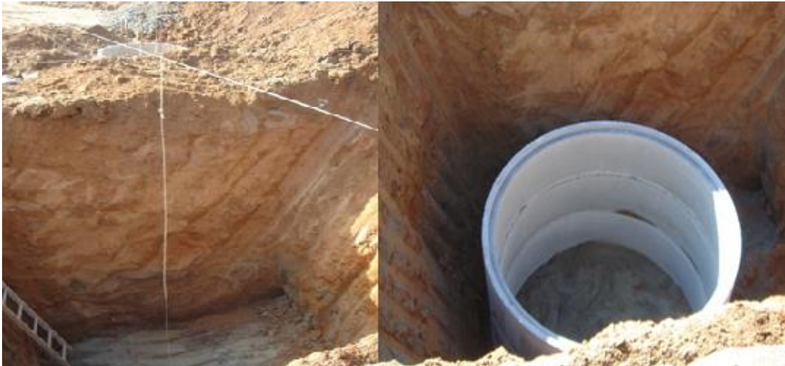
Figura 11 - Marcação e colocação das aduelas (Fonte: Autor)
