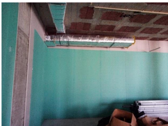
Figura 45 - Colocação das placas de gesso cartonado numa face (Fonte: Autor)
