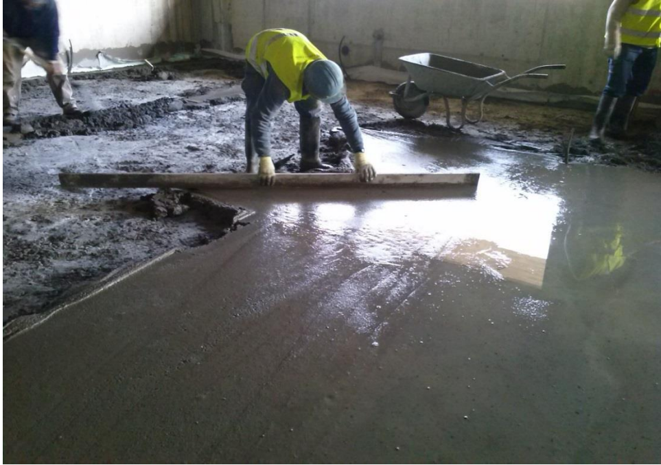
Figura 29 - Aplicação de argamassa no pavimento (Fonte: Autor)
