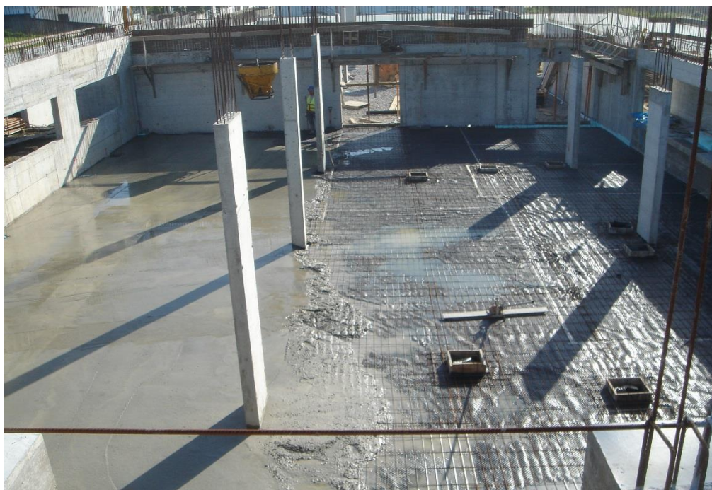
Figura 27 - Betonagem do piso térreo (Fonte: Autor)
