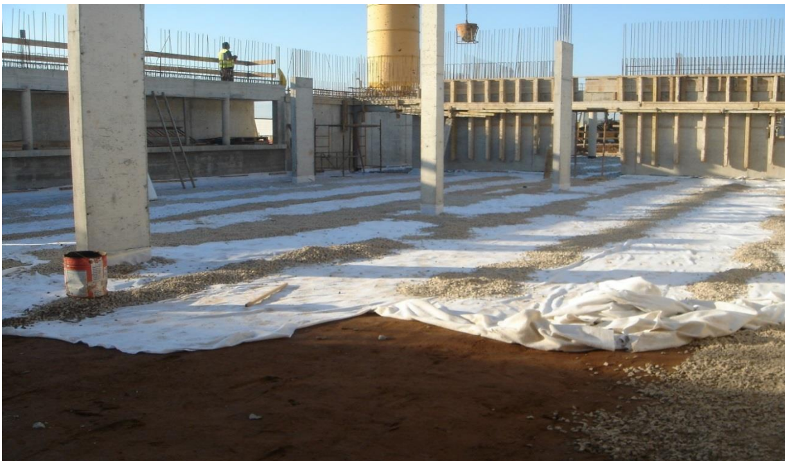
Figura 24 - Manta geotêxtil (Fonte: Autor)
