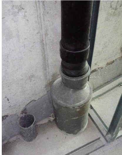
Figura 72 - Finalização do sistema em tubagem de PVC (Fonte: Autor)
