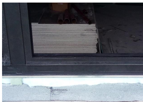
Figura 62 - Caixilho aplicado sobre o zinco (Fonte: Autor)
