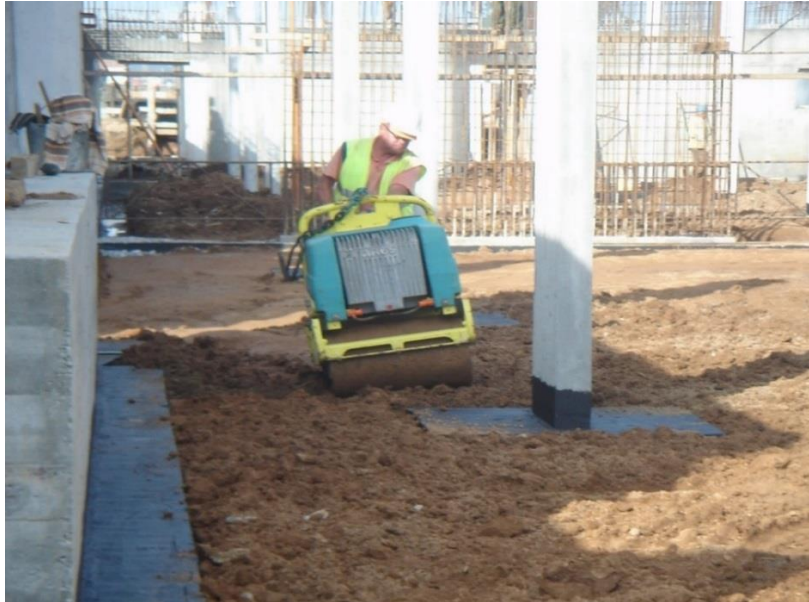
Figura 23 - Compactação do solo (Fonte: Autor)
