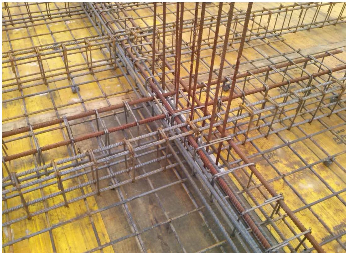
Figura 34 - Detalhe da cruzeta do pilar (Fonte: Autor)
