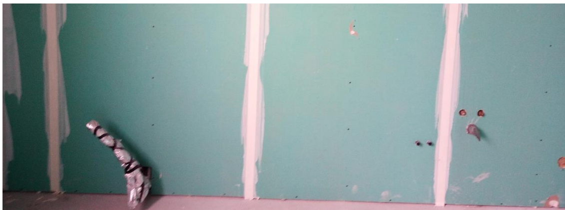
Figura 47 - Emaçamento das paredes interiores (Fonte: Autor)
