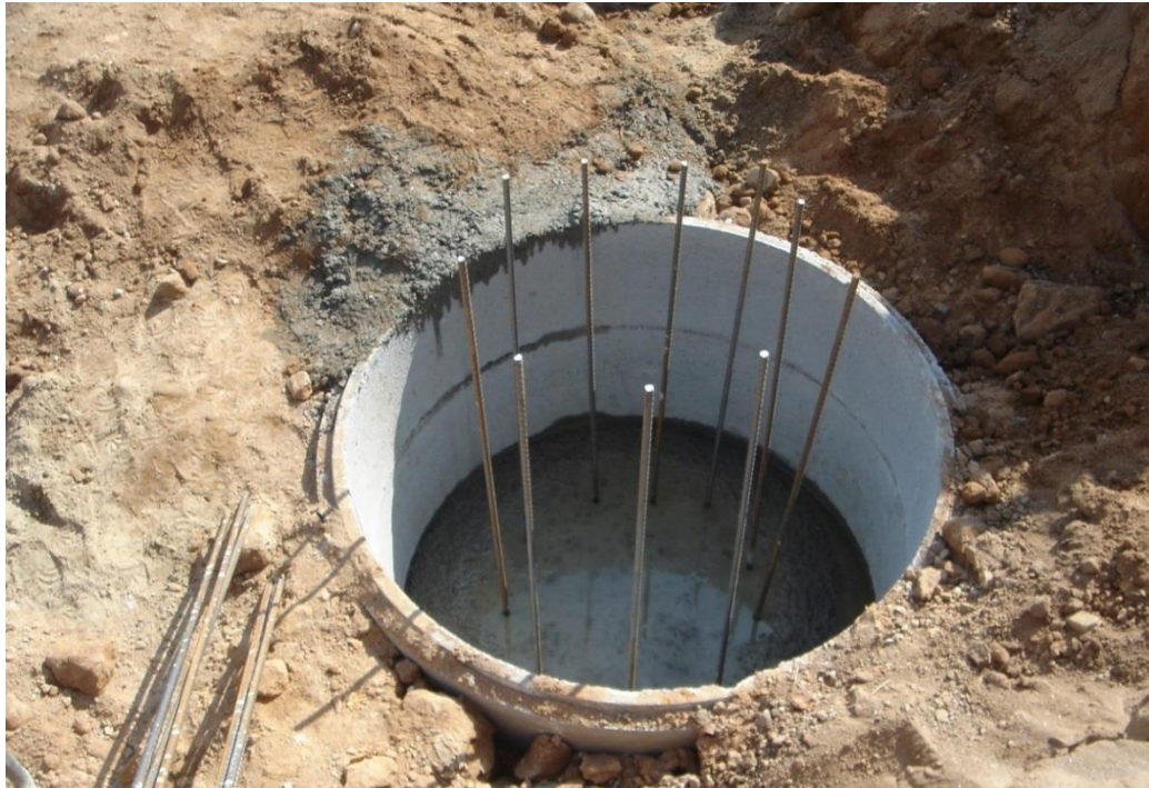
Figura 12 - Colocação de varões no betão (Fonte: Autor)
