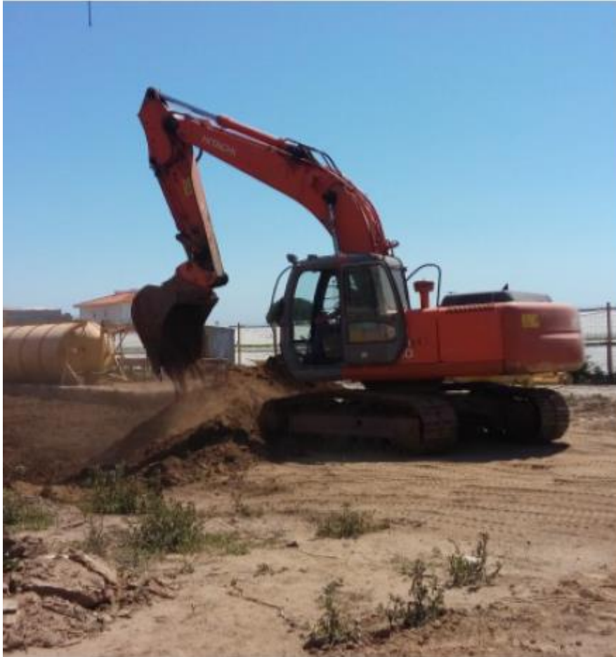
Figura 7 - Escavação do Terreno (Fonte: Relatório de Visita à obra)
