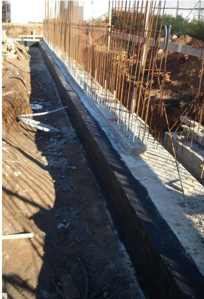
Figura 15 - Aplicação do impermeabilizante "Flintkoat" (Fonte: Autor)
