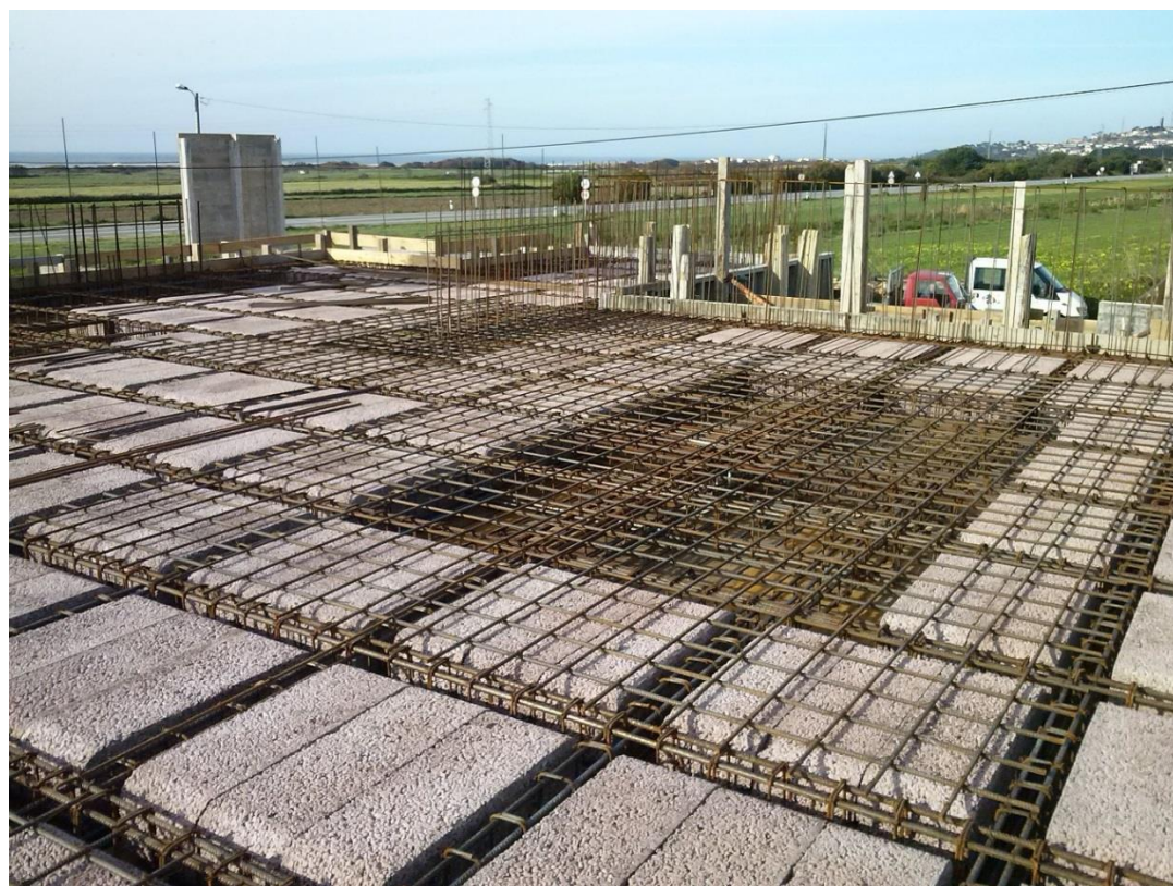
Figura 35 - Maciços concluídos (Fonte: Autor)
