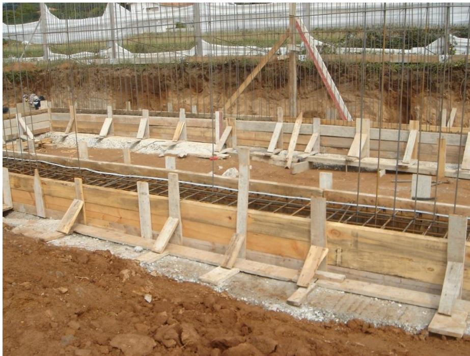
Figura 13 - Cofragem e armação da sapata de fundação (Fonte: Autor)
