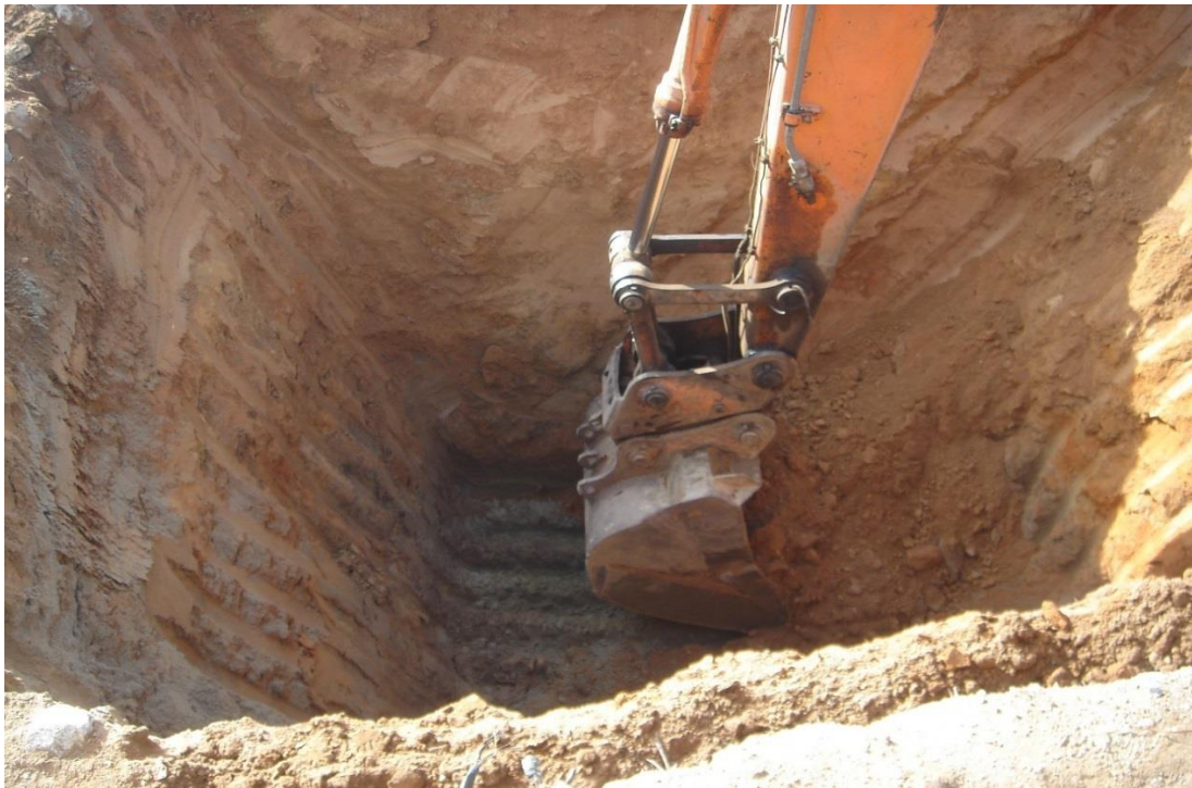
Figura 10 - Escavação até aos 4 metros de profundidade (Fonte: Autor)
