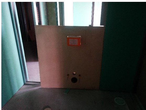
Figura 43 - Reforço na zona das sanitas suspensas (Fonte: Autor)
