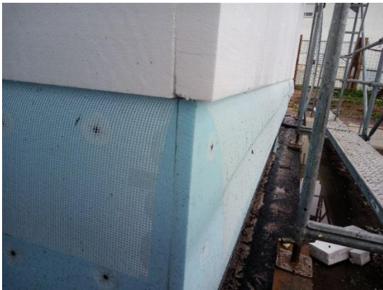
Figura 56 - Arranque da rede de fibra de vidro (Fonte: Autor)
