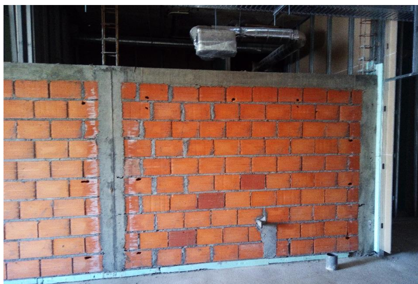
Figura 48 – Execução de paredes em alvenaria (Fonte: Autor)
