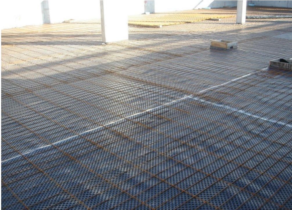
Figura 26 - Colocação da manta drenante e da malhasol (Fonte: Autor)
