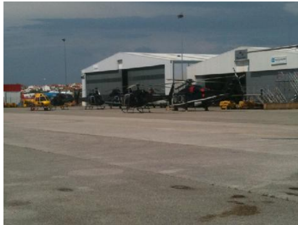
Figura 2 - Instalações da Helisupporte - Aeródromo Municipal de Cascais [7]
