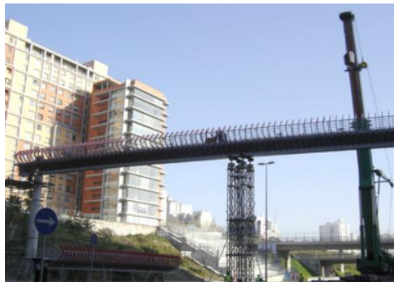
Figura 4.9 Montagem do tabuleiro da ponte (PPE, 2008).
