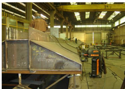
Figura 4.7 Construção em oficina de um dos troços que constitui o tabuleiro da ponte (PPE, 2008).
