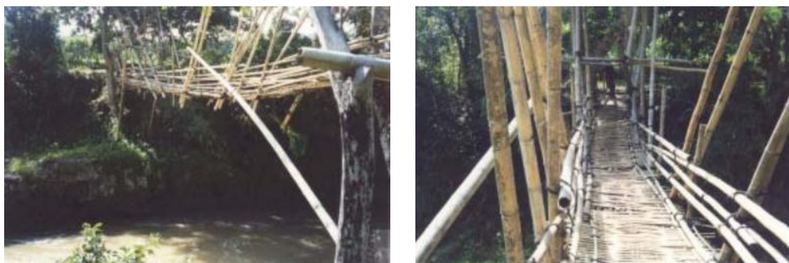
Figura 2.4 Exemplo de uma ponte pedonal em bambú; Adaptado de (Dennis, 2004)
