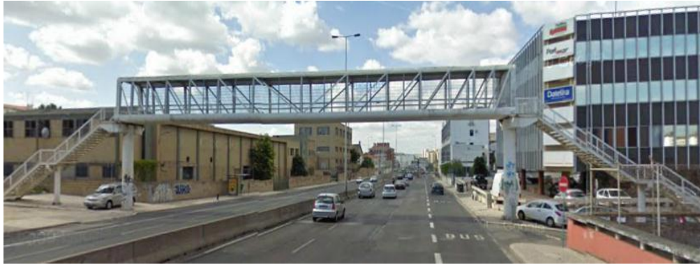
Figura 2.10 Ponte pedonal metálica sobre a Av. Infante Dom Henrique, Lisboa.
