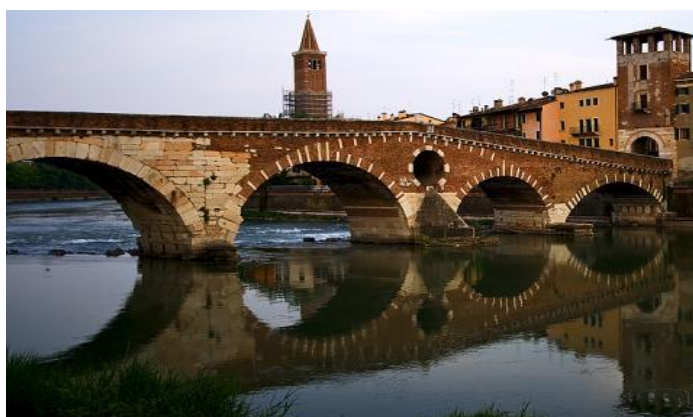
Figura 2.6 Ponte di Pietra, Verona.
