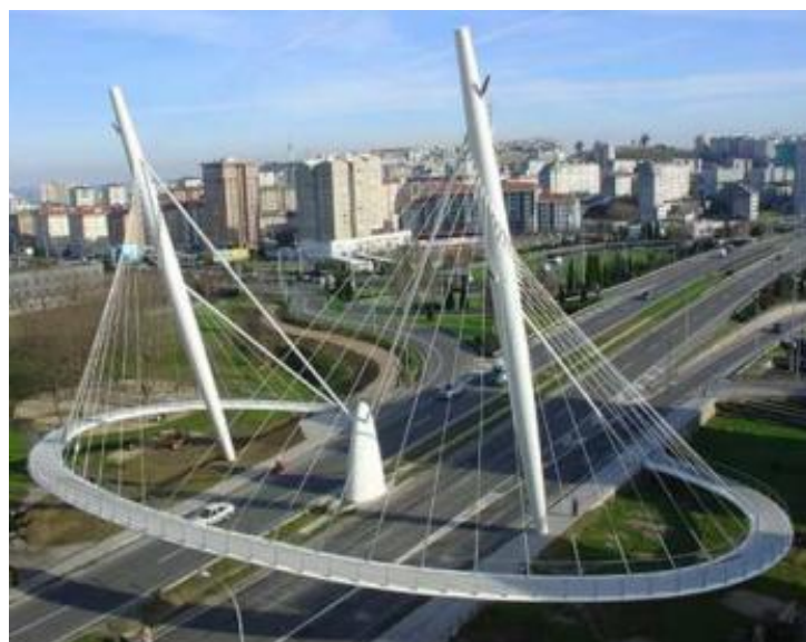
Figura 2.11 Ponte pedonal atirantada La Rosa , Corunha (Dolejs & Rotter, 2011).
