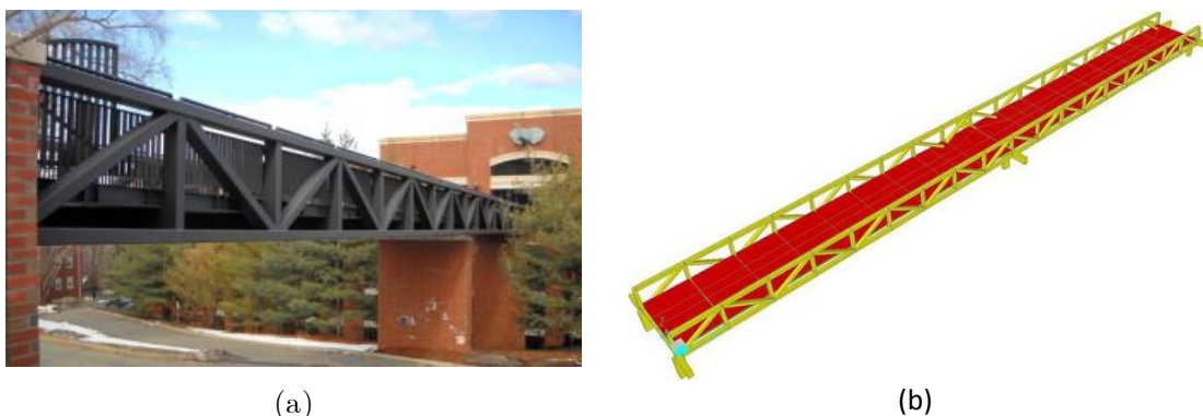
Figura 3.15 a) Ponte pedonal Dowling Hall, Boston (EUA); a) Modelo numérico em SAP2000 da ponte pedonal Dowling Hall.
