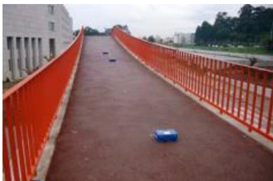
Figura 3.14 Ensaio de vibração ambiental na ponte pedonal Campus da FEUP. Fonte: (Moutinho et al., 2010).
