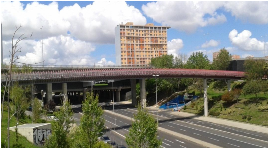
Figura 4.2 Vista da ponte pedonal.
