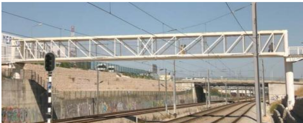
Figura 2.9 Ponte pedonal metálico sobre ferrovia, Moscavide (Chagas Carvalho, 2007)
