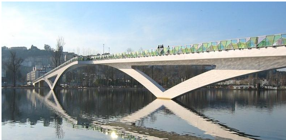
Figura 2.28 Ponte Pedro e Inês, Coimbra (Portugal) (Velo, 2012).
