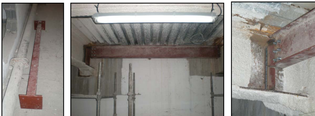
Imagens 41, 42 e 43 – Novos elementos metálicos e respectiva aparafusagem
