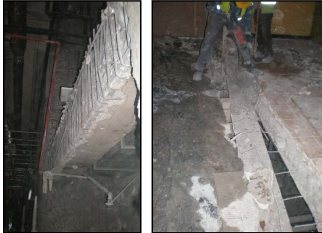
Imagens 10 e 11 – Manutenção de armaduras em vigas e picagem de lajes
