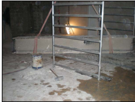
Imagem 34 – Remoção das vigas metálicas
