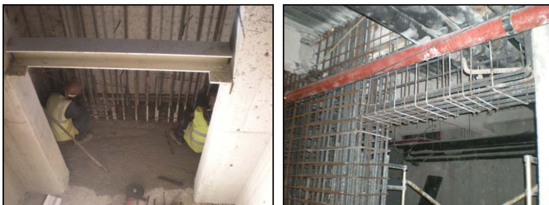
Imagens 18 e 19 – Armação de paredes
