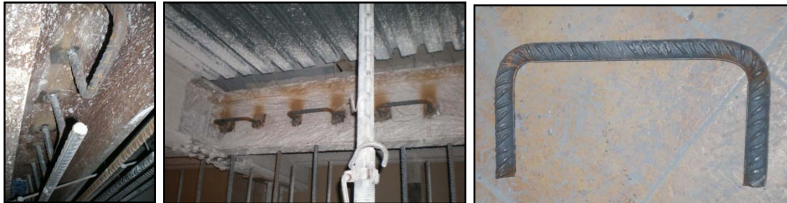
Imagens 38, 39 e 40 – Peça metálica em U e sua aplicação em vigas e pilares
