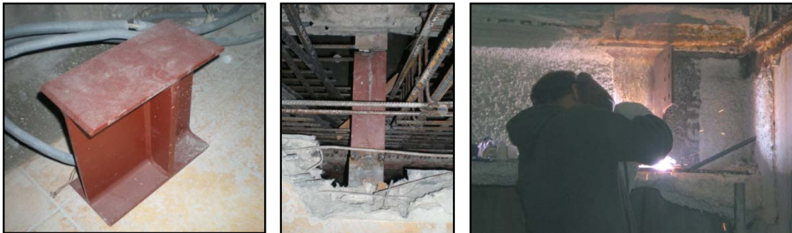
Imagens 35, 36 e 37 – Elemento de ligação metálico e soldagem em viga metálica
