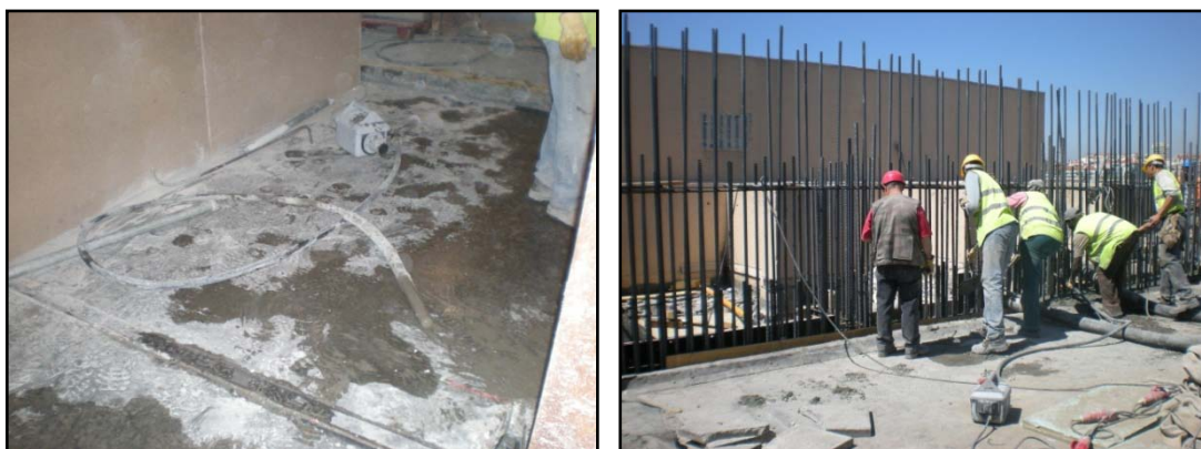
Imagens 26 e 27 – Agulhas vibradoras e betonagem da parede do alinhamento da caixa dos elevadores
