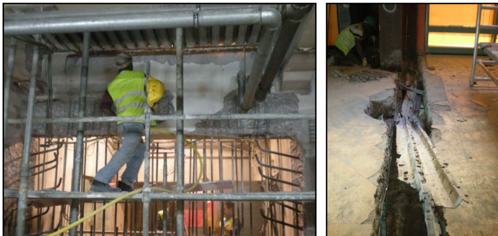
Imagens 12 e 13 – Picagem de elemento horizontal e corte da chapa constituinte da laje colaborante
