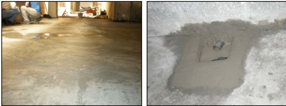
Imagens 55 e 56 – Aspecto final da intervenção e sistema de escoamento
