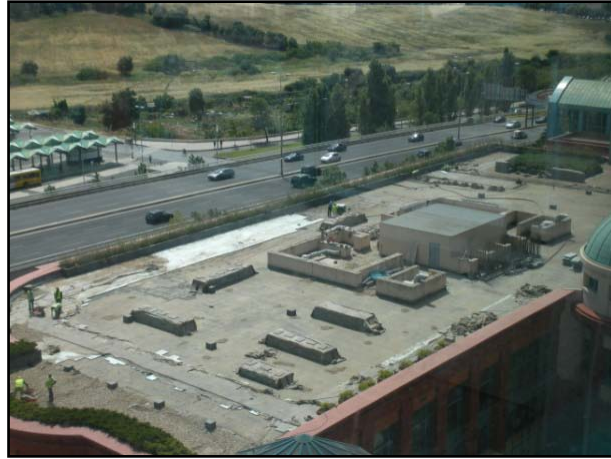
Imagem 66 – Trabalhos de remoção de inertes e roofmate
