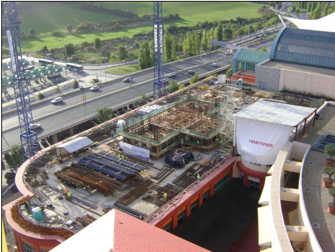
Imagem 81 – Perspectiva geral do estaleiro na fase anterior ao arranque do deslize
