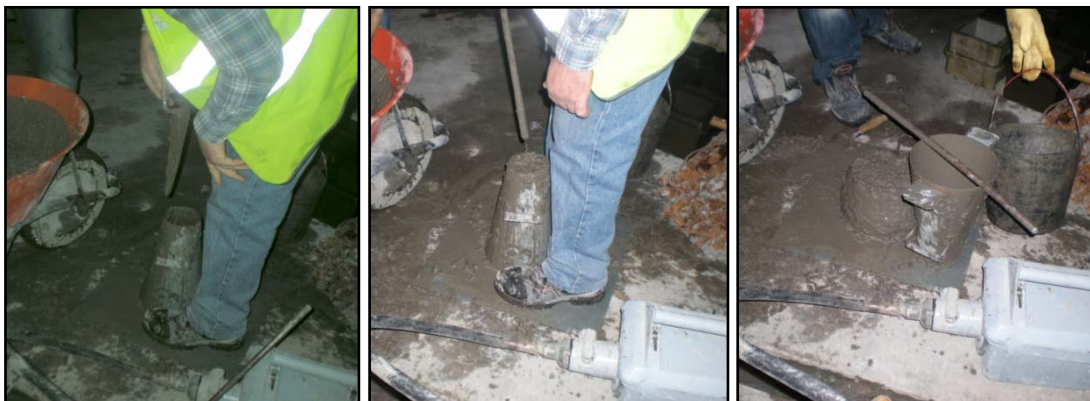
Imagens 28, 29 e 30 – Enchimento do molde, apiloamento e medição da diferença de cotas
