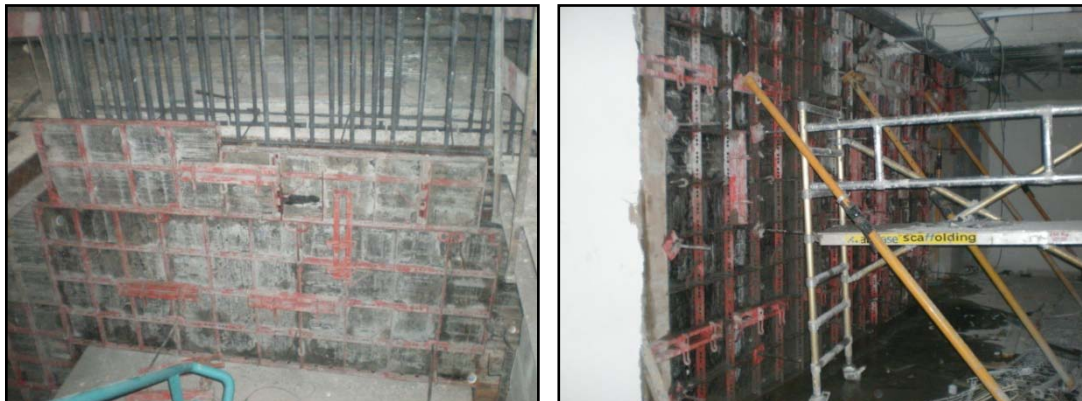
Imagens 20 e 21 – Cofragem de elementos e sistema de escoramento
