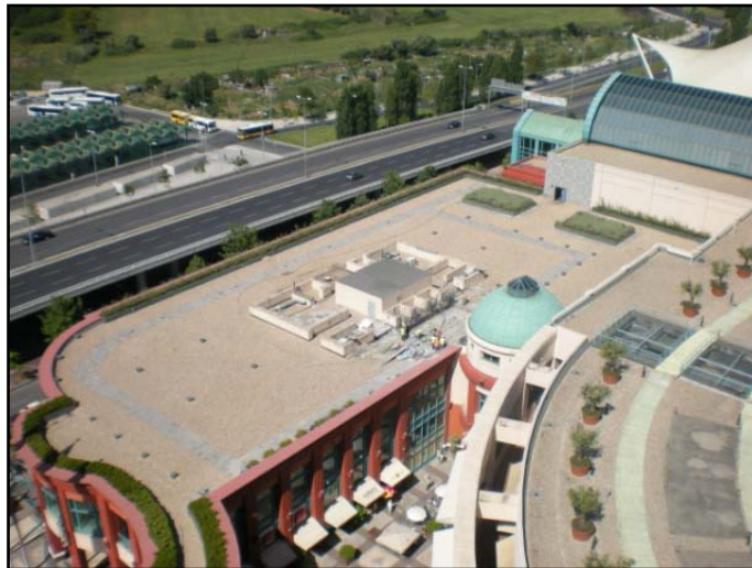
Imagem 65 – Cobertura inicial e remoção de inertes
