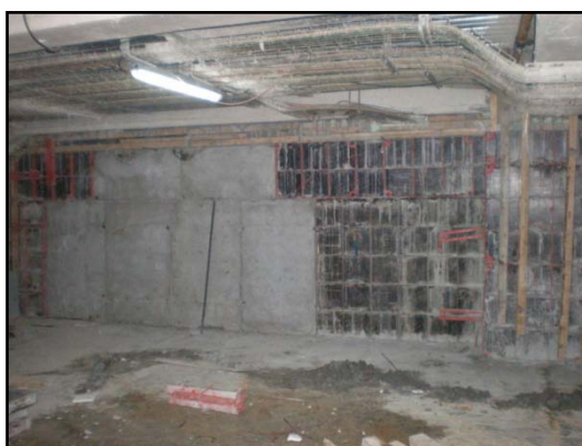
Imagem 22 – Descofragem de parede
