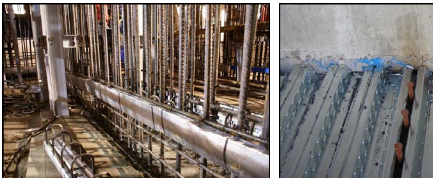
Imagens 49 e 50 – Disposição das caixas de espera (durante a execução do núcleo de betão armado) e pormenor da ligação laje colaborante-núcleo central (fonte: Eng.º Hugo Pereira, Mota-Engil)
