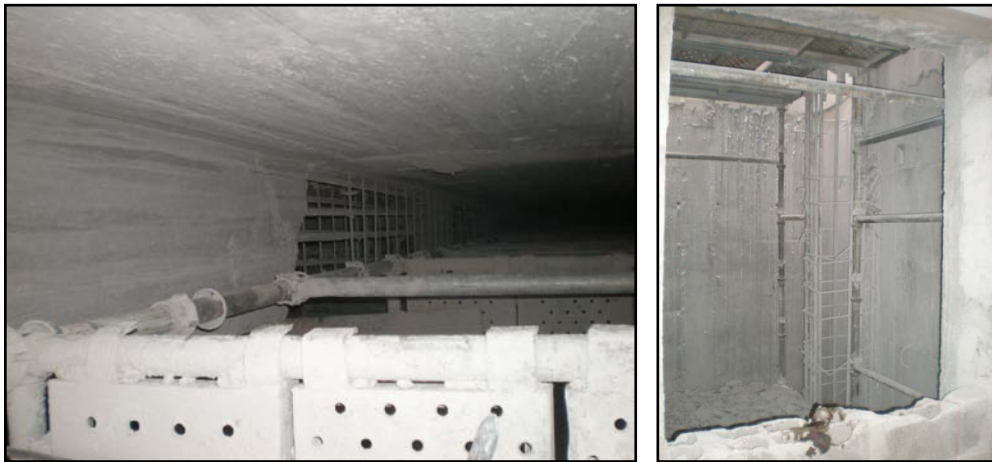
Imagens 74 e 75 – Vistas superior e lateral da estrutura de andaimes no interior da caixa de elevadores
