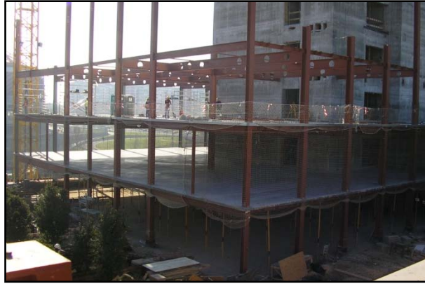
Imagens 44 – Disposição de vigas no período pré-betonagem de lajes (fonte: Eng.º Hugo Pereira, Mota-Engil)
