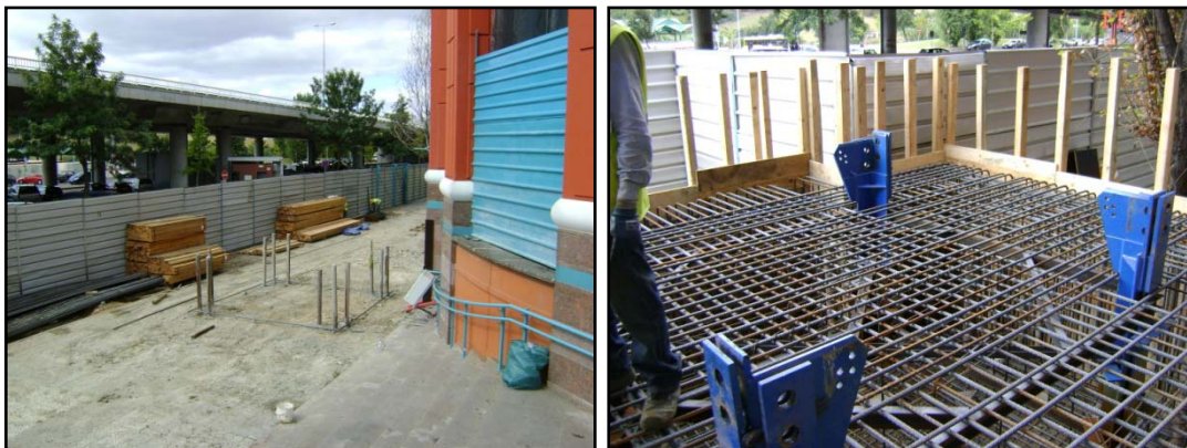
Imagens 78 e 79 – Localização de uma das gruas-torre e construção do maciço de suporte (fonte: Eng.º Hugo Pereira, Mota-Engil)
