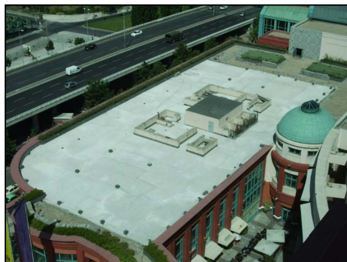
Imagem 69 – Camada de betonilha
