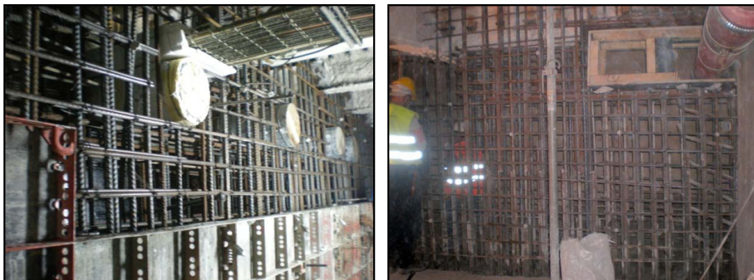
Imagens 8 e 9 – Armação das paredes e pormenores de cofragem
