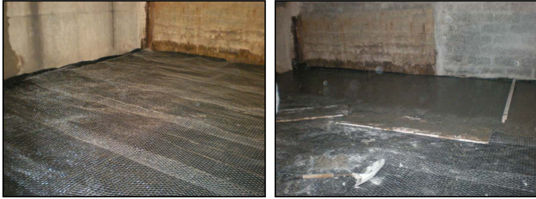
Imagens 53 e 54 – Camada de malhasol e aplicação da camada de betão
