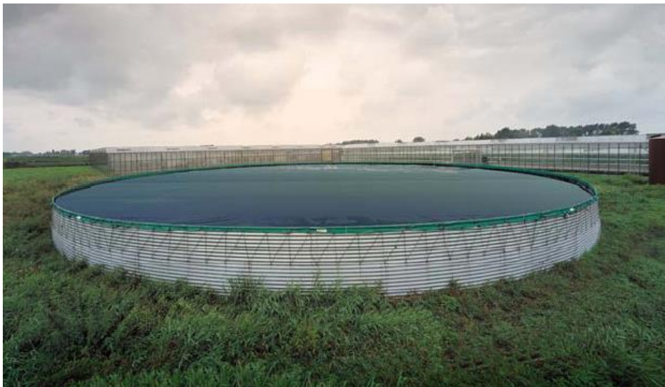
Figura 14 - Reservatório de armazenamento de águas pluviais
