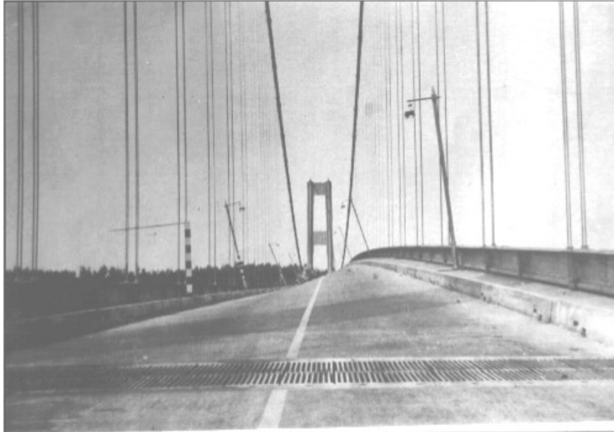
Figura 2 – Movimento de torção máximo no tabuleiro central antes do colapso do tabuleiro (Guerra, João Martins. Acção do vento, 2008)
