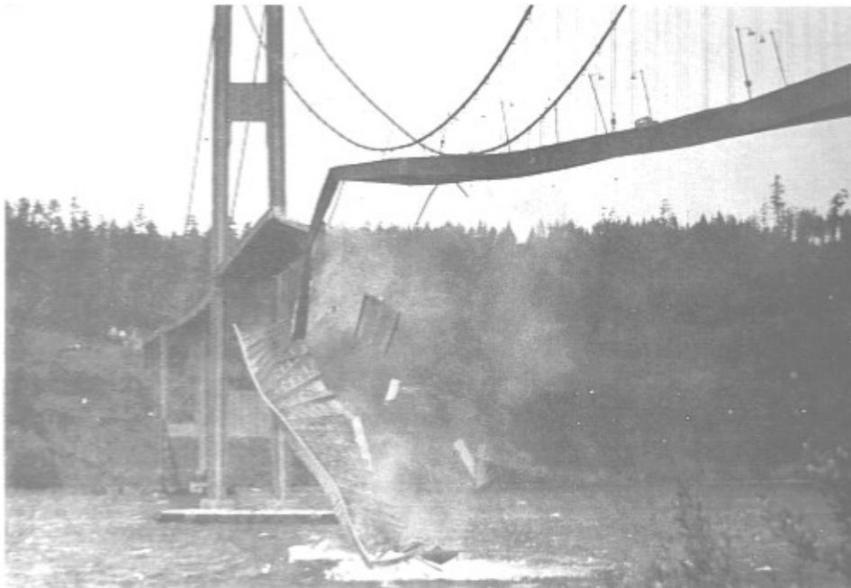
Figura 5 - Colapso do tabuleiro (Guerra, João Martins. Acção do vento, 2008)
