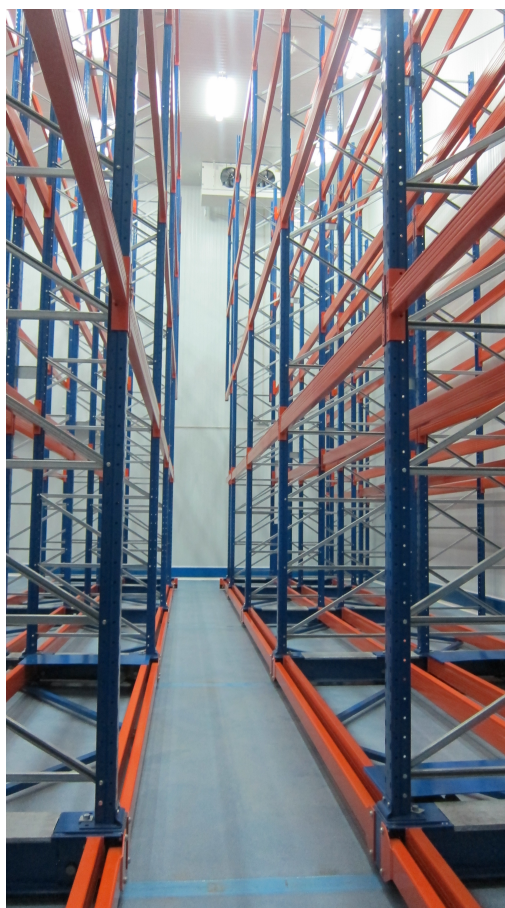
Figura 3 - Pormenor da estrutura de armazenagem móvel da Câmara de Refrigerados
