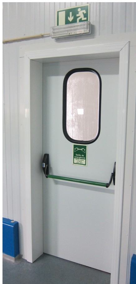
Figura 6 - Porta pivotante de acesso ao exterior
