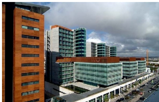
Figura 2.13 – Edifício Expoland, retirado de [39]
