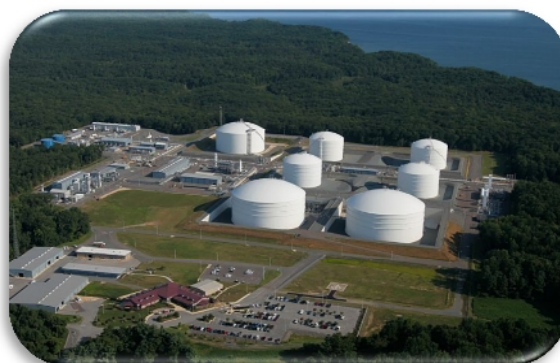
Figura 2.8 – Tanque de GNL, retirado de [32]
