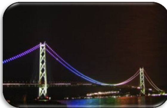
Figura 2.7 – Ponte Akaishi-Kaiko, retirado de [30]
