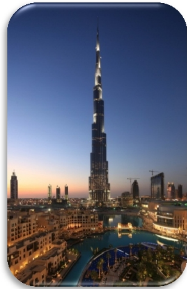
Figura 2.9 – Torre Burj Dubai, retirado de [35]
