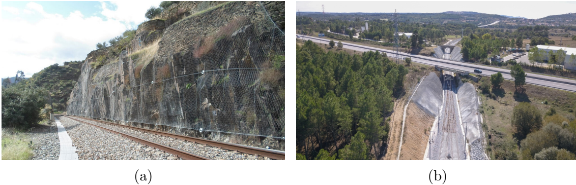
Figura 1.2: Exemplos de taludes presentes em linhas férreas portuguesas: talude rochoso (a) e talude em betão (b).
