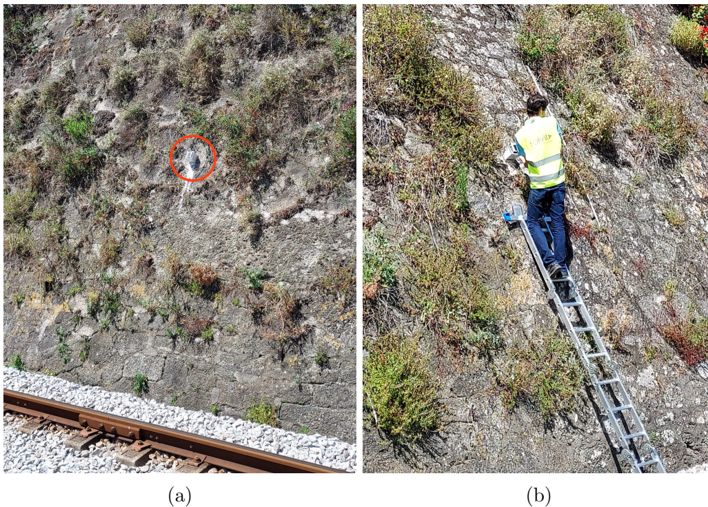
Figura 2.7: Talude (a) onde foi instalado o sensor (b) nos ensaios no Apeadeiro de Chelas.
