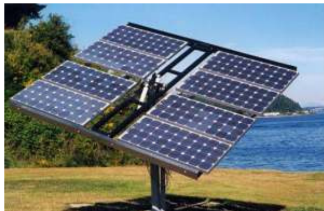
Fig. 15 Painéis solares fotovoltaicos, instalação no chão tipo árvore [20].
