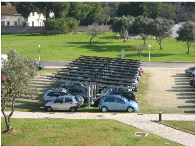
Fig. 17 – Instalação de painéis – exemplo cobertura de parque estacionamento [22].
