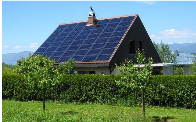
Fig. 16 – Instalação de painéis – exemplo telhado de uma habitação[21].
