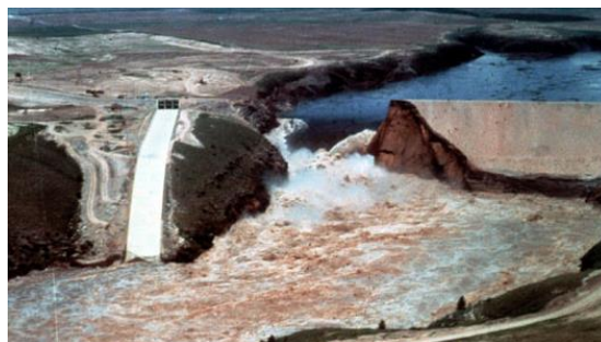
Figura 2.8 - Exemplo de rotura por “erosão interna” - Barragem de Teton , EUA em 1976.
