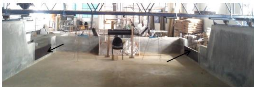
Figura 4.4 - Vista geral da albufeira vazia. Localização dos descarregadores laterais.
