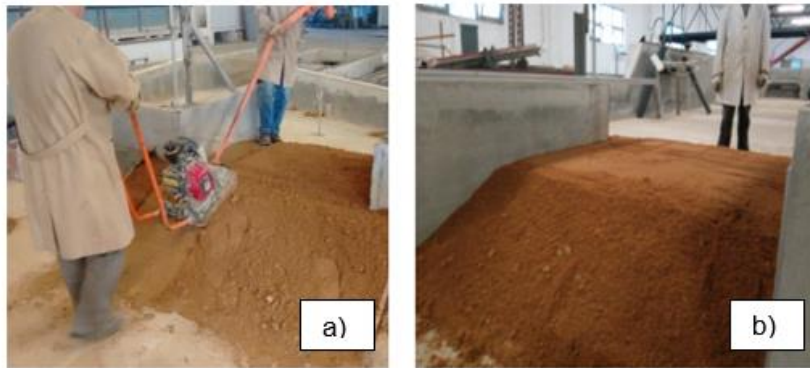
Figura 5.4 - a) Processo de compactação da 3. a camada da barragem; b) Morfologia do aterro após a compactação da 4. a camada.
