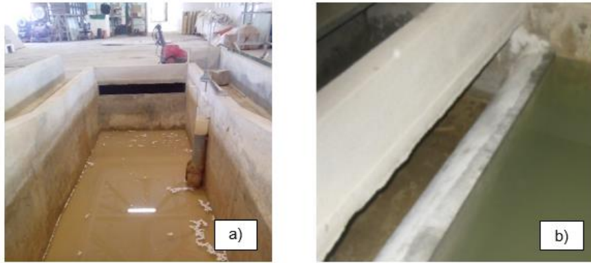
Figura 4.6 - a) Reservatório de Jusante; b) Descarregador a jusante do aterro.
