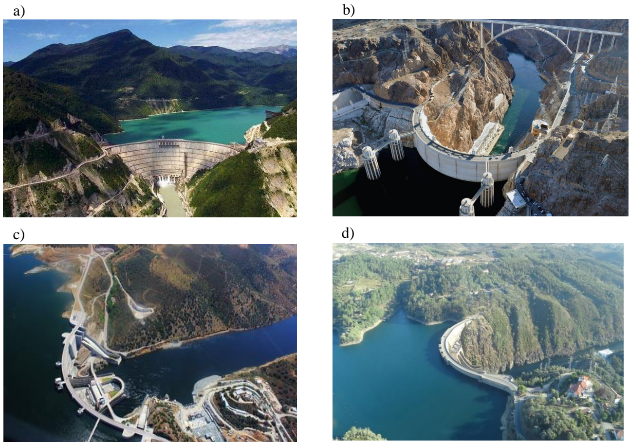
Figura 1.1 - Exemplo de grandes barragens: a) Inguri, b) Hoover, c) Alqueva e d) Castelo de Bode.
