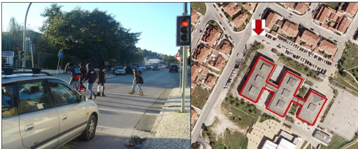
Figura 3.10 – Vista e localização do acesso à Esc. Básica 2,3 de D. João II
