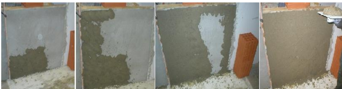
Figura 5.28 -Etapas realizadas na execução da camada de acabamento
