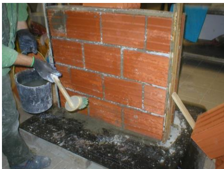
Figura 5.15 - Preparação do suporte: humedecimento
