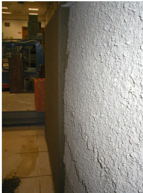
Figura 5.47 - Espessura final do reboco
