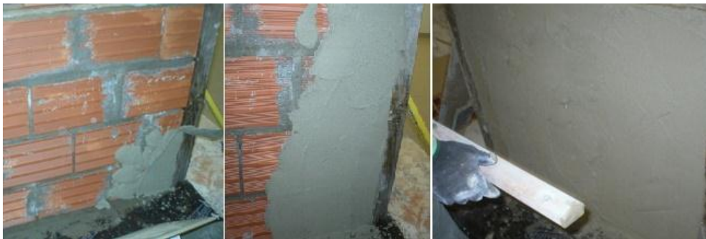
Figura 5.17 - Aplicação do RHP no respectivo suporte
