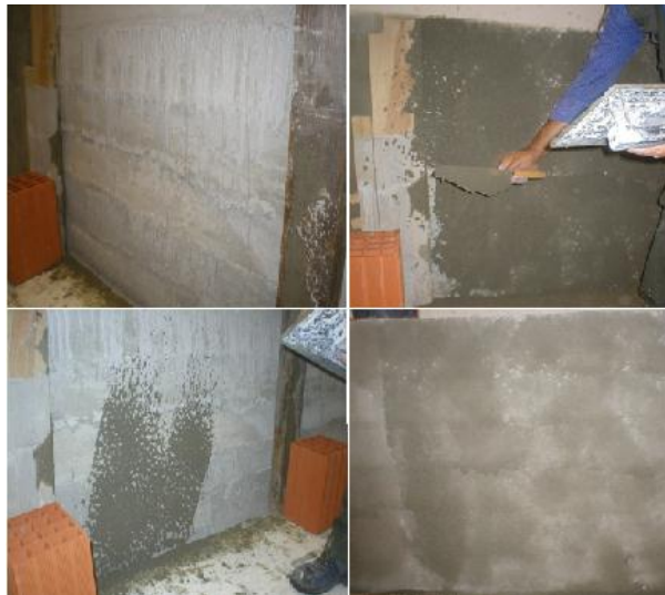
Figura 5.25 - Sequência da execução do salpico
