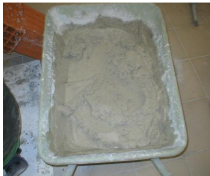
Figura 5.12 - Argamassa pré-doseada pronta a ser aplicada
