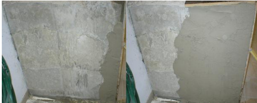
Figura 5.13 - Início da execução do reboco de argamassa pré-doseada RHP
