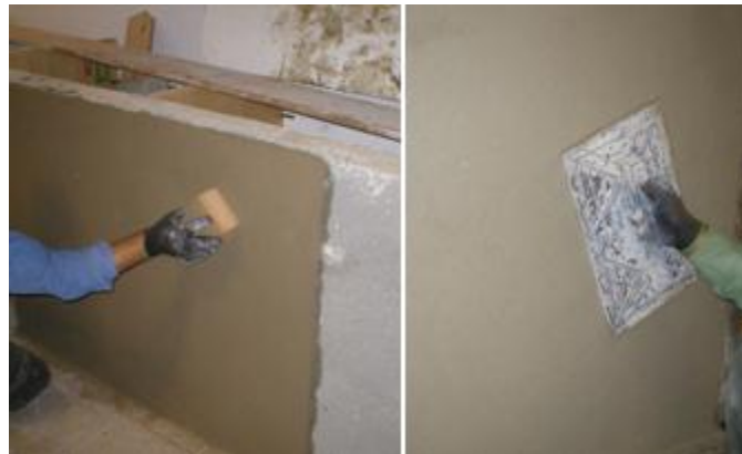
Figura 4.5 a) Acabamento areado b) acabamento talochado
