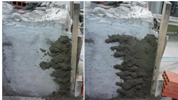
Figura 5.59 - Execução da camada de acabamento
