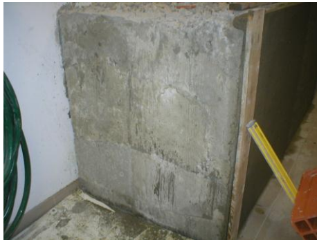
Figura 5.11 - Suporte de betão previamente humedecido
