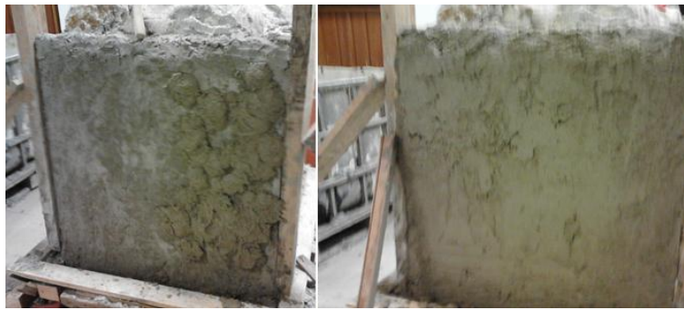
Figura 5.39 a) Chapar argamassa b) Existência de depressões após sarrafo
