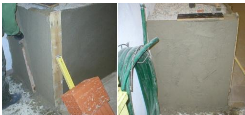
Figura 5.14 - Sarrafar a camada executada
