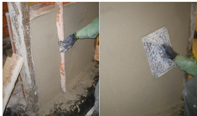
Figura 5.18- Conferir aspecto final ao reboco
