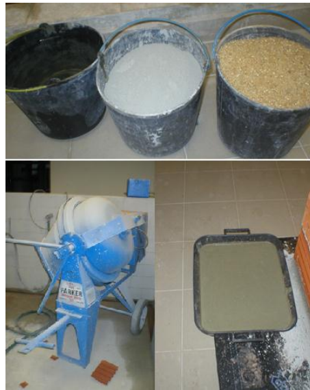
Figura 5.50 - Materiais necessários: a) Água, Cimento e Areia b) Betoneira c) Estância
