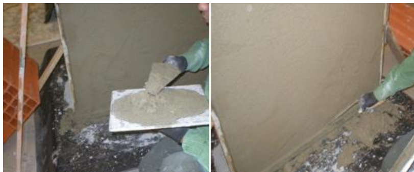
Figura 5.33 - Aplicação da argamassa seguida alisamento
