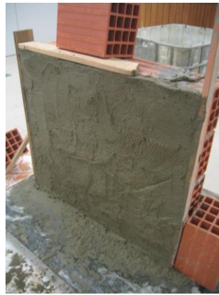
Figura 5.52 - Aspecto antes de talochar
