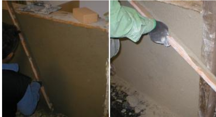
Figura 4.4 - Movimentos associados à técnica de sarrafar uma camada de reboco
