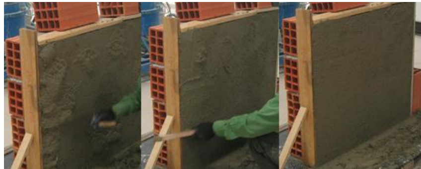
Figura 5.53 - Eliminar depressões e garantir planeza
