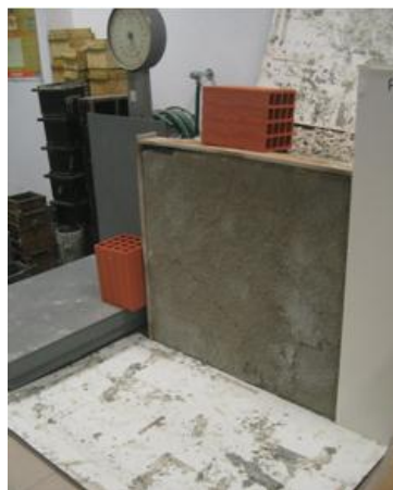
Figura 5.42 - Cofragem do suporte a rebocar
