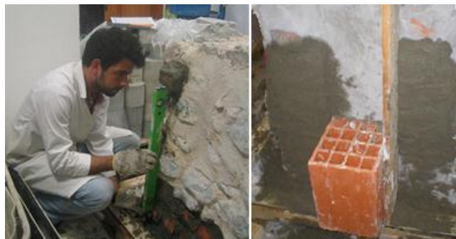
Figura 5.57 a) Nivelamento dos pontos b) Execução das duas filas verticais
