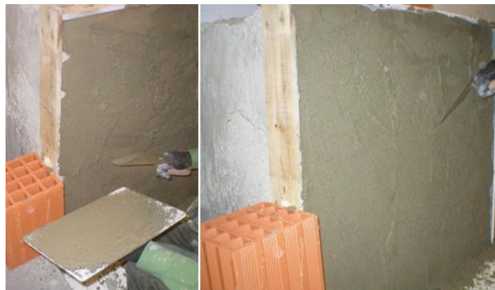
Figura 5.44 - Observar e tapar zonas com défice de argamassa
