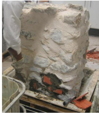
Figura 5.56 - Execução do encasque no reboco corrente
