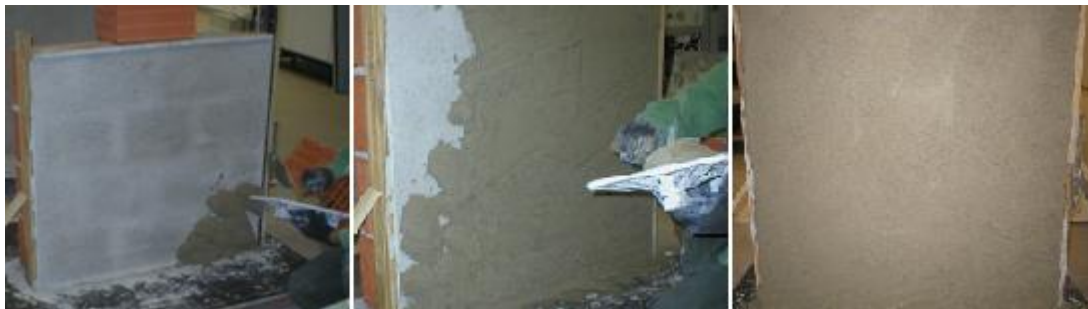
Figura 5.32 - Chapar a argamassa contra o suporte até à espessura pretendida
