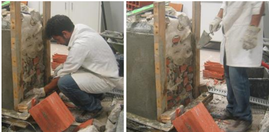
Figura 5.36 a) Aplicação do tijolo na alvenaria b) Encasque
