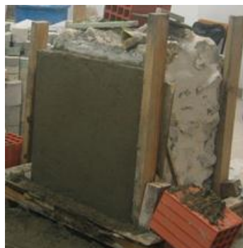
Figura 5.60 - Aspecto final da camada de acabamento do reboco corrente
