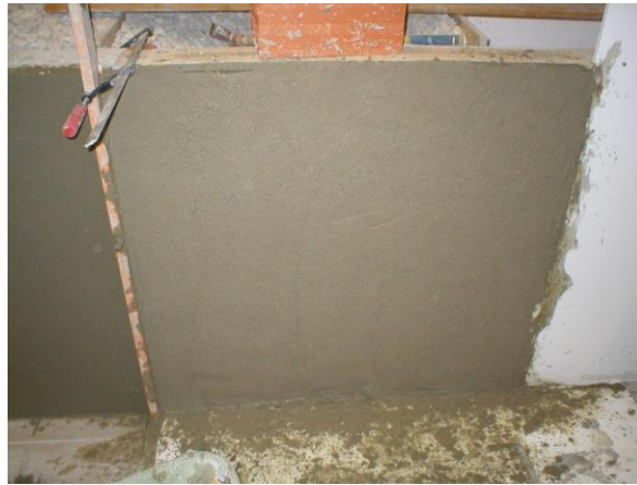
Figura 5.27 - Conclusão da 2ª camada: emboço
