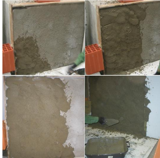
Figura 5.43 - Evolução construtiva do emboço
