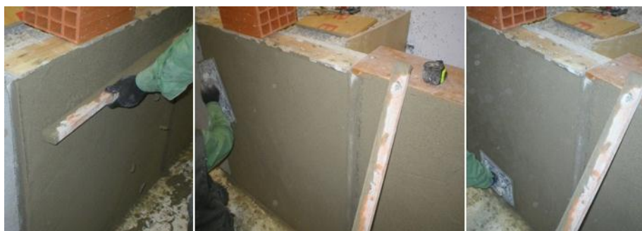
Figura 5.29 - Excessos de argamassa retirados e talochar alternadamente
