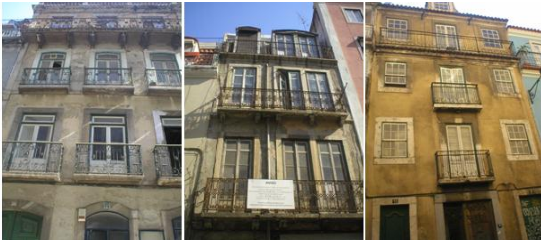
Figura 3.1 - Aspecto de geral de edifícios antigos
