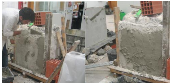
Figura 5.23 - Aplicação da camada de acabamento RBR 20
