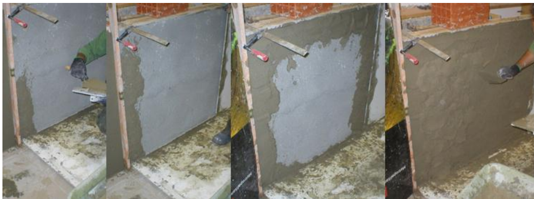
Figura 5.26 – Desenrolar da aplicação da argamassa
