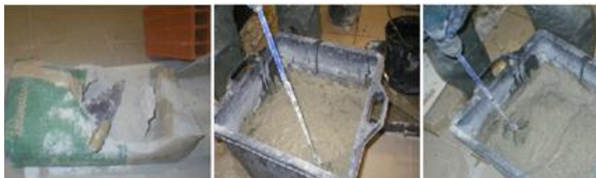
Figura 5.16 - Preparação da argamassa pré-doseada
