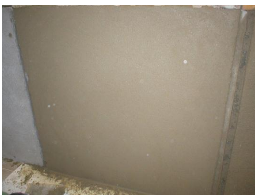
Figura 5.30 - Terminada a 3ª camada: acabamento
