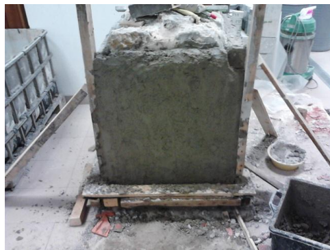
Figura 5.38 - Aspecto após execução do sarrafo
