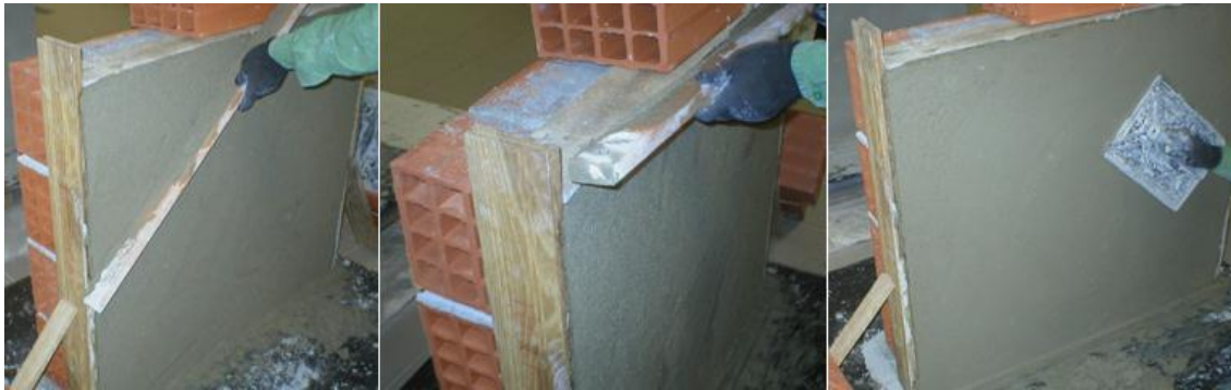
Figura 5.34 - Etapas finais: remover excessos e talochar
