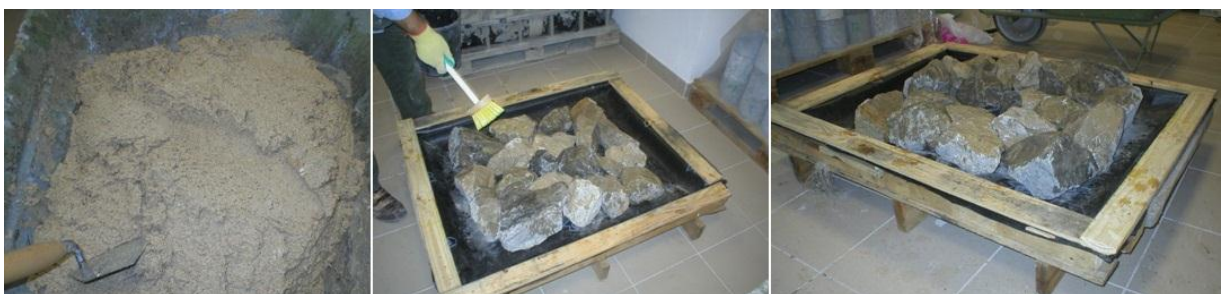
Figura 5.7 - a) Preparação da argamassa b) e c) Molhagem das pedras
