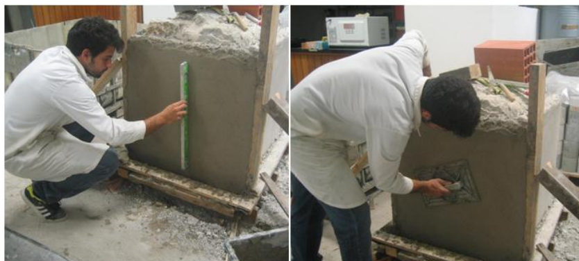
Figura 5.40 a) Nivelamento da camada b) Acabamento à talocha
