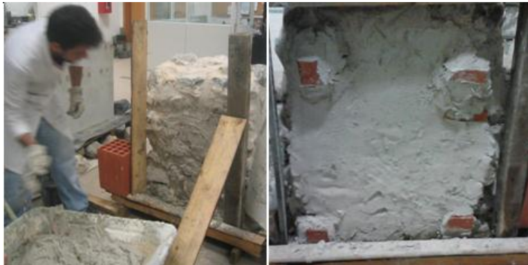
Figura 5.19 a) Execução do encasque b) Marcação dos pontos
