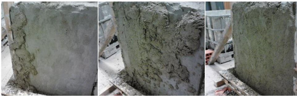
Figura 5.37 - Sequência construtiva da camada base: emboço
