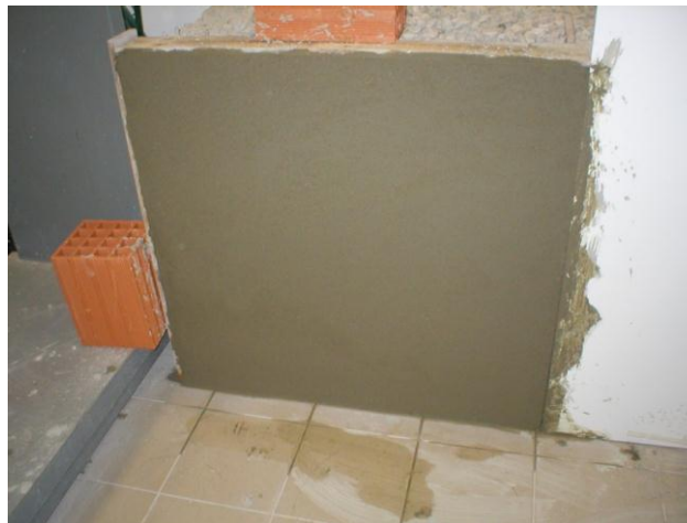
Figura 5.46 - Reboco de obra com acabamento talochado
