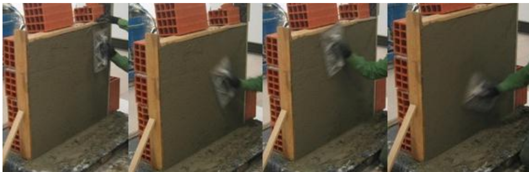
Figura 5.54 - Conferir acabamento talochado ao reboco
