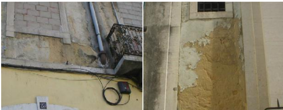
Figura 3.8 - Exemplo de perda de coesão
