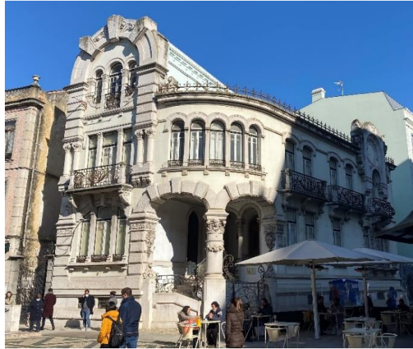
Figura 2.2 - Edifício na Praça Duque de Saldanha, classificado como Imóvel de Interesse Público (imagem do autor).
