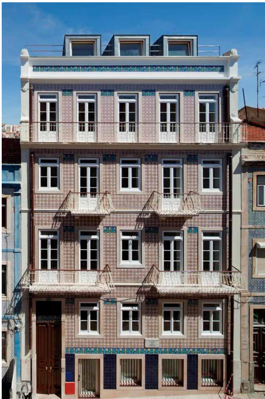
Figura 5.12 – Edifício após a reabilitação (Urbanspace, 2012).
