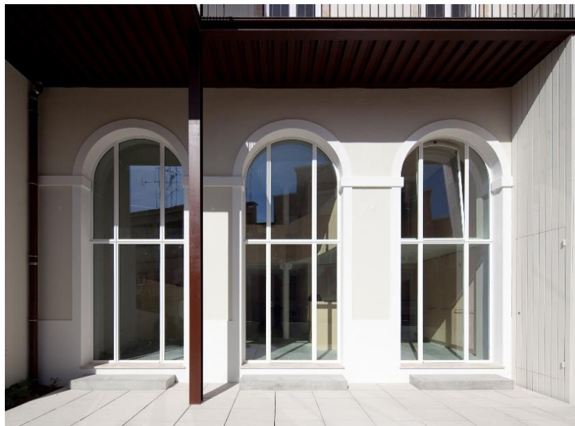
Figura 5.22 – Caixilharia nova do edifício (IHRU, 2012).
