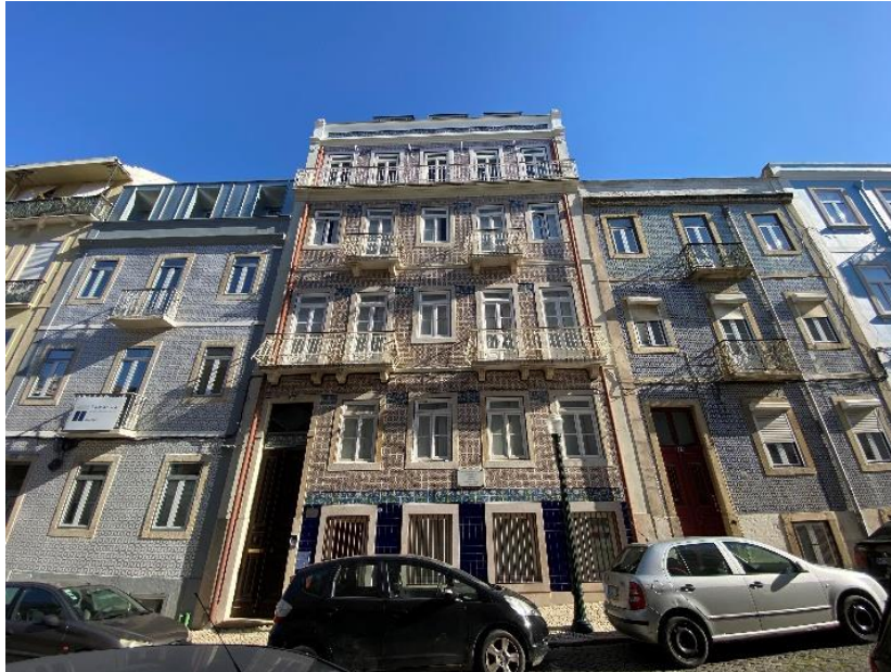
Figura 5.20 – Edifício em análise e os seus vizinhos (imagem do autor).
