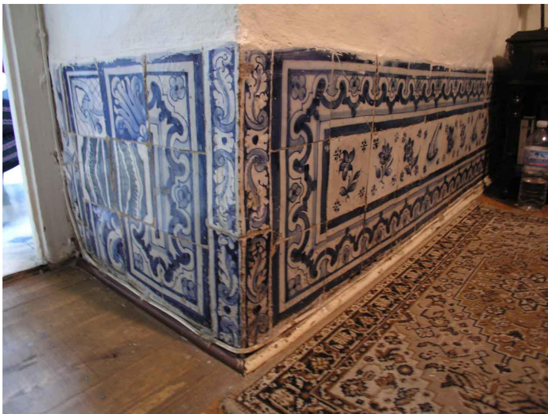
Figura 5.10 – Revestimento presente no interior do edifício (Fonte: Penim Loureiro, 2007).
