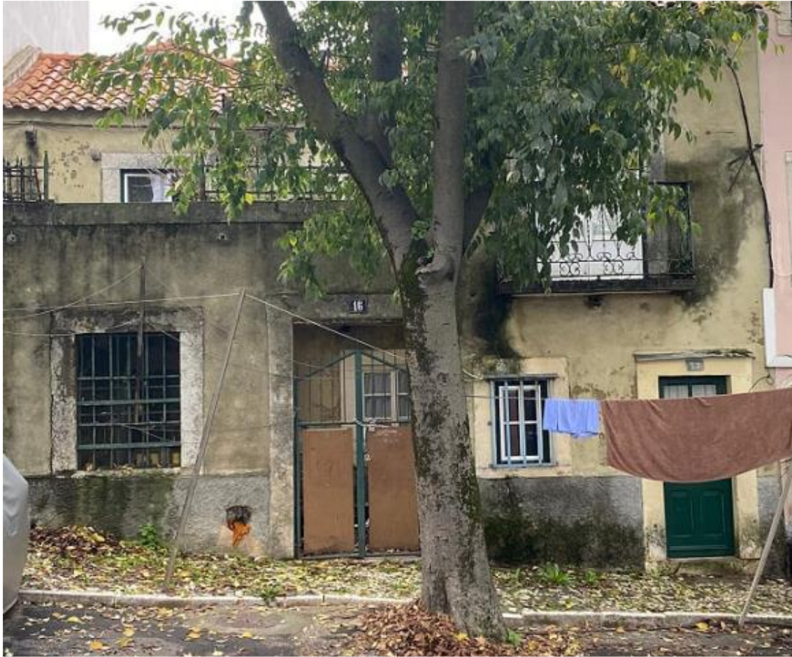
Figura 5.3 – Fachada do conjunto habitacional em estudo (Rego et al., 2021)
