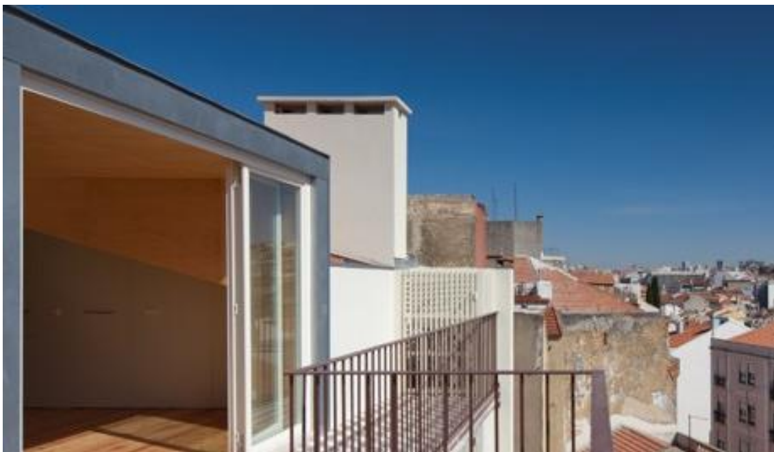
Figura 5.26 – Cobertura da chaminé (TETRAPOD, 2017).
