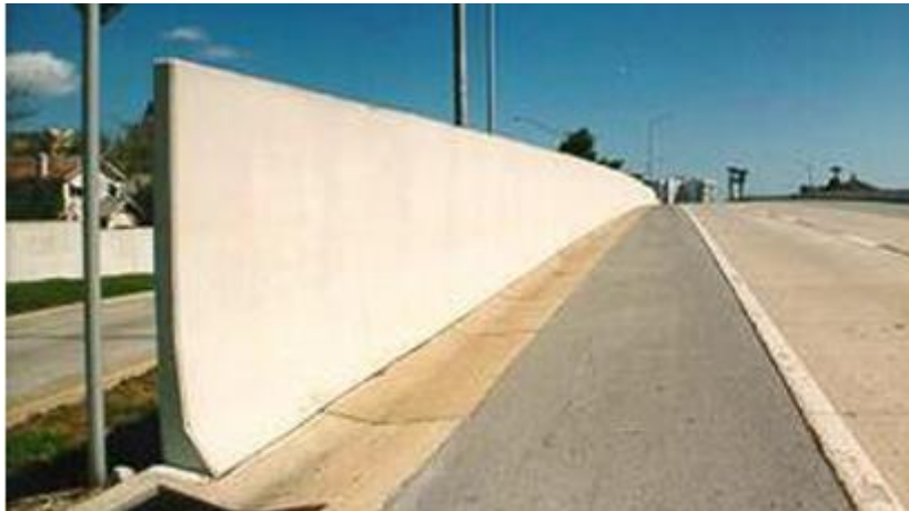
Figura 4.32 – Barreira de betão armado betonada “in situ” (Knauer et al., 2000)
