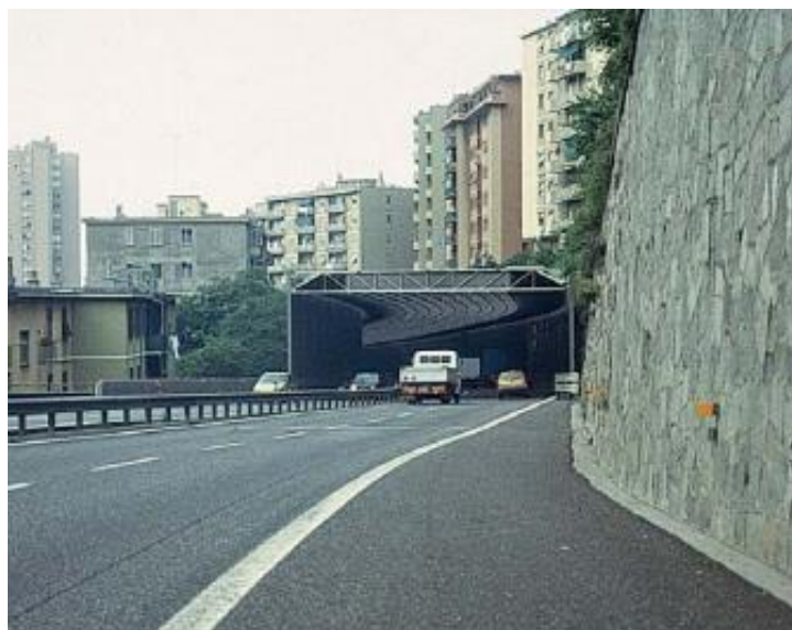
Figura 4.29 – Túnel para isolamento de ruído em Génova (Kotzen & English, 2009)
