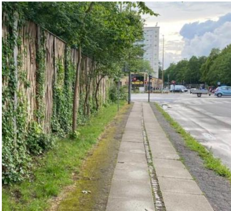
Figura 4.31 – Barreira de madeira com vegetação em meio urbano (Pilebyg, 2024)
