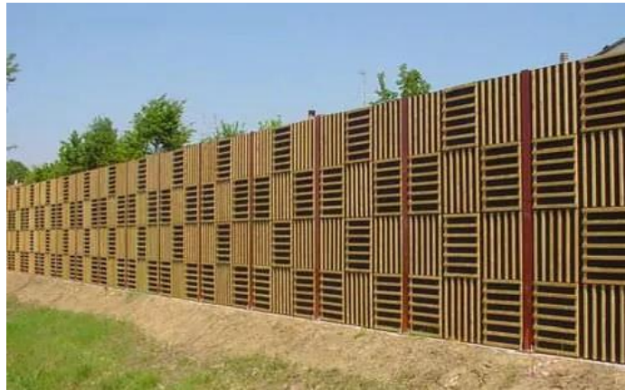
Figura 4.25 – Barreira acústica com material de absorção sonora (Portal Acústica, 2019)
