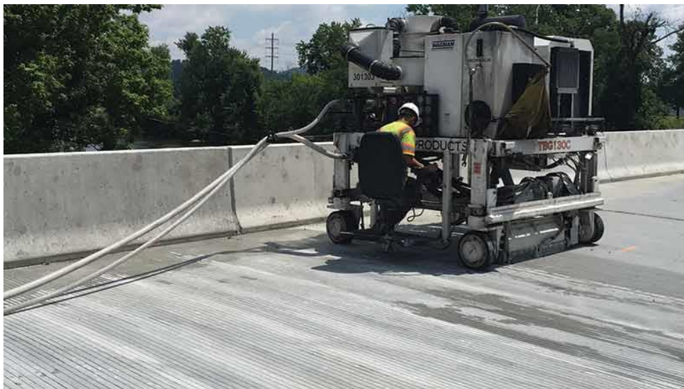
Figura 4.12 – Execução de ranhuração transversal em pavimento rígido (Wagman Construction, 2024)
