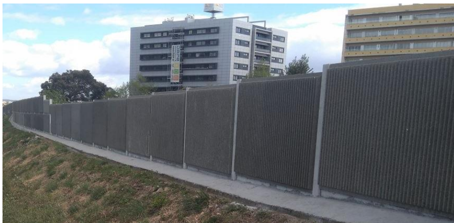
Figura 4.34 – Barreira de betão armado (Farcimar, 2019)
