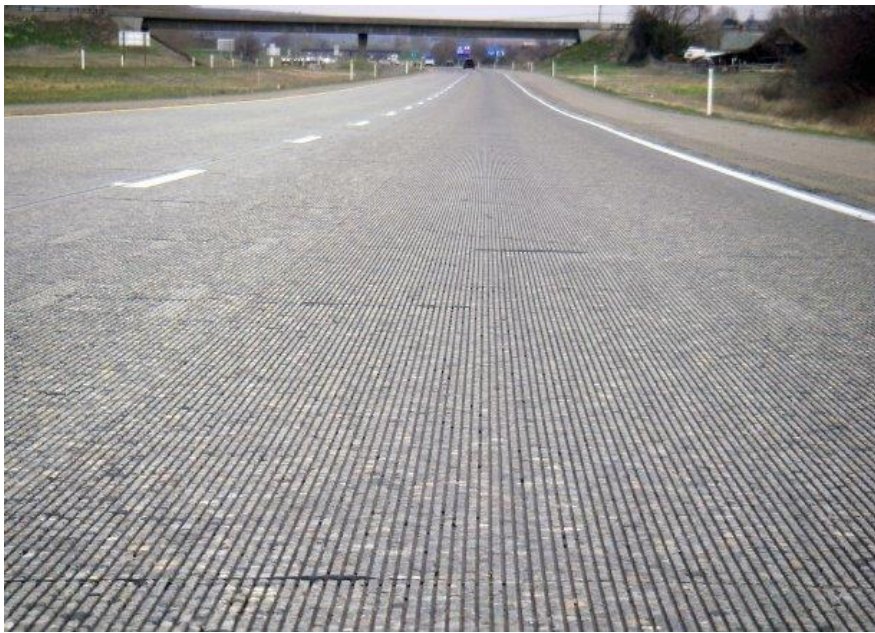
Figura 4.11 – Pavimento com ranhuração longitudinal (adaptado de Construction Connect Canada, 2023)
