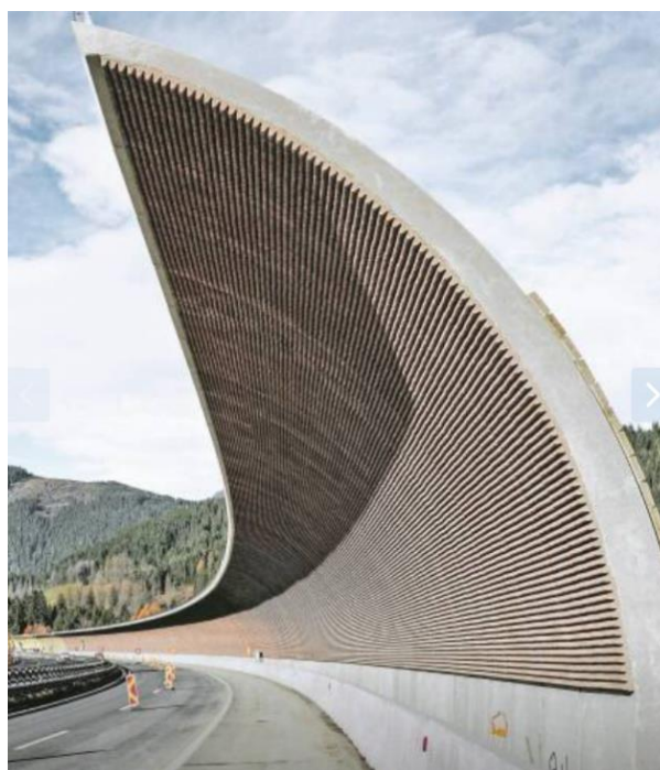
Figura 4.30 – Barreira acústica em consola (SN, 2018)
