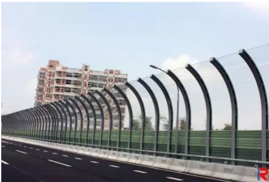
Figura 4.40 – Barreira acústica com painéis de acrílico curvados (Ray Chung Acrylic Enterprise, 2024)
