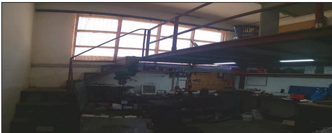
Figura 4.4 – Área de trabalho da eletricidade. Fonte: Fornecido pela STEP.
