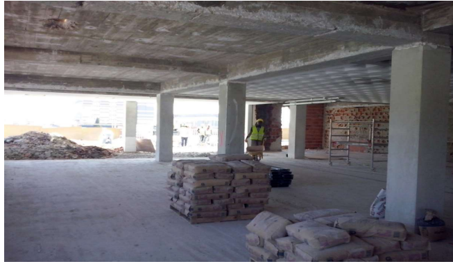
FIGURA 46 - PISO 4 EDIFÍCIO A/B, INÍCIO DA RECONSTRUÇÃO
