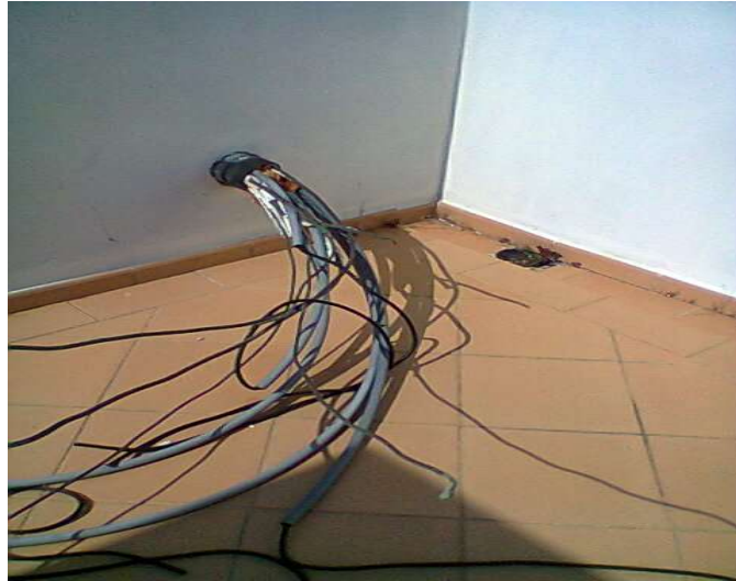
FIGURA 16 – LOCALIZAÇÃO DO COMPRESSOR - AR CONDICIONADO
