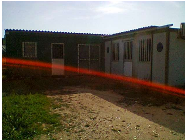
FIGURA 15 - ESTALEIRO DIRECÇÃO DE OBRA
