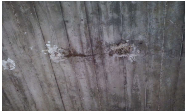
FIGURA 42 - FISSURAS EM LAJES
