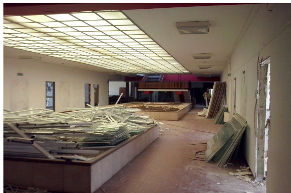
FIGURA 39 - PISO 3 EDIFÍCIO A/B, DEMOLIÇÕES
