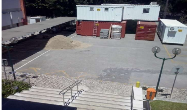
FIGURA 37 - VISTA DO ESTALEIRO
