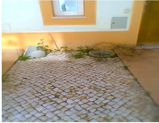
FIGURA 29 - CAIXAS DE TELECOMUNICAÇÕES
