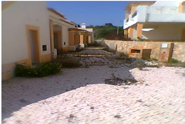
FIGURA 20 - ARRUEAMENTO ZONA CENTRO, CALÇADA
