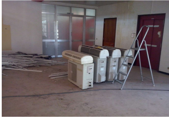
FIGURA 40 - PISO 2 EDIFÍCIO A/B, ENTREGA DE EQUIPAMENTOS
