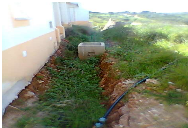
FIGURA 21 - ARRUEAMENTO ZONA NORTE - VALA TELECOMUNICAÇÕES
