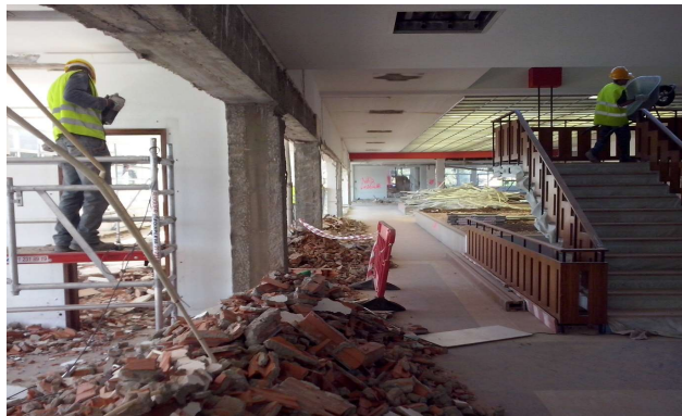
FIGURA 41 - PISO 3 EDIFÍCIO A/B, DEMOLIÇÕES DE ALVENARIAS
